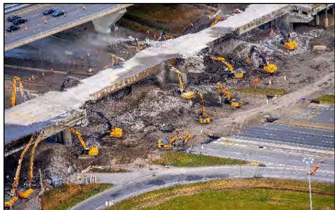
Démolition des travées et piles sur la Rive-Sud, à Brossard
