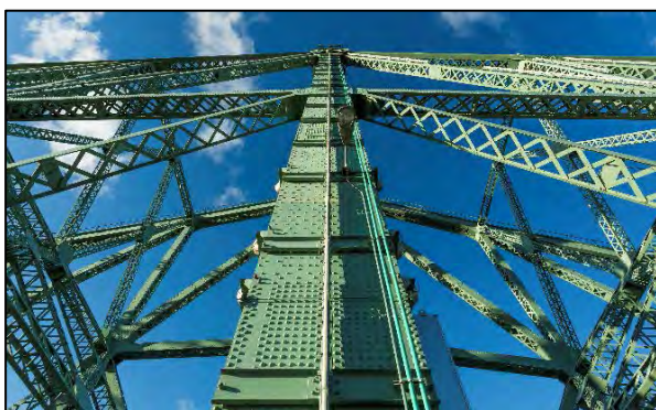
Superstructure du pont Jacques-Cartier
