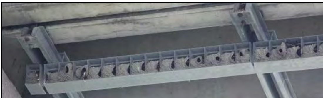
Hirondelles à front blanc - poutrelles de nidification installées sous l'Estacade
