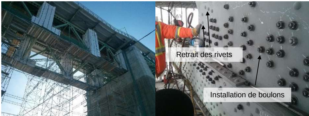
a) Vue de dessous des travaux d'entretien sous le tablier du pont b) Opérations de retrait des rivets et d'installation des boulons Figure 2: Travaux sous le tablier du pont et opérations d'entretien lors de la visite
