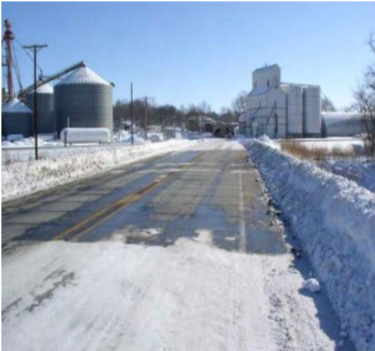
Figure 6.1-8 : Essai de fonte avec le béton conducteur sur le pont Roca Spur, Nebraska
