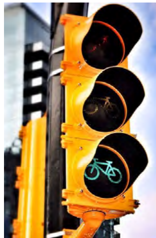
Figure 7.4-7 : Exemple de signaux lumineux à l'entrée du pont, www.victoria.ca
