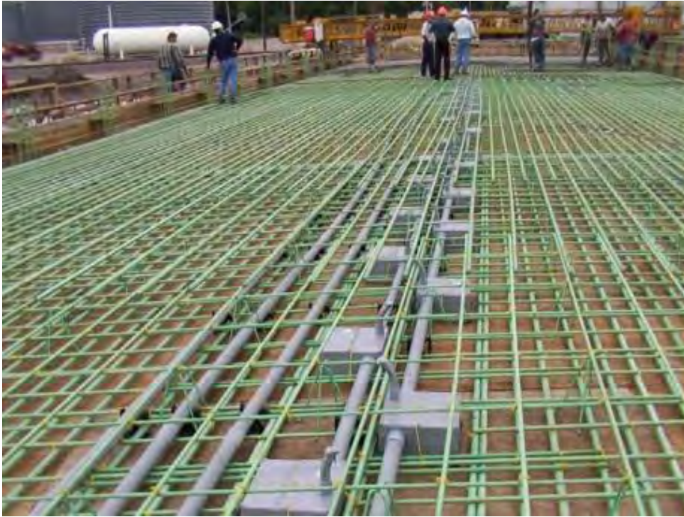
Figure 6.1-5 : Intégration des conduits électriques, boîtes de jonctions et électrodes à la dalle structurale du pont Roca Spur, Nebraska
