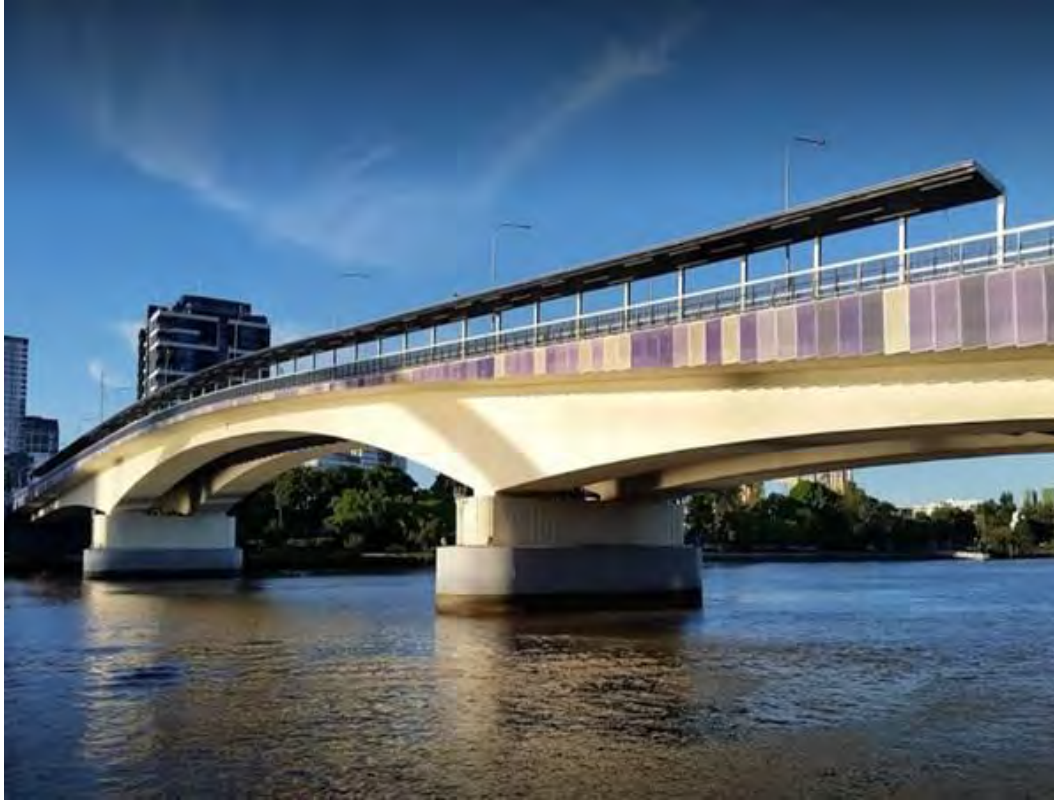
Figure 8.3-6 : Pont « Go Between » à Brisbane, Australie
