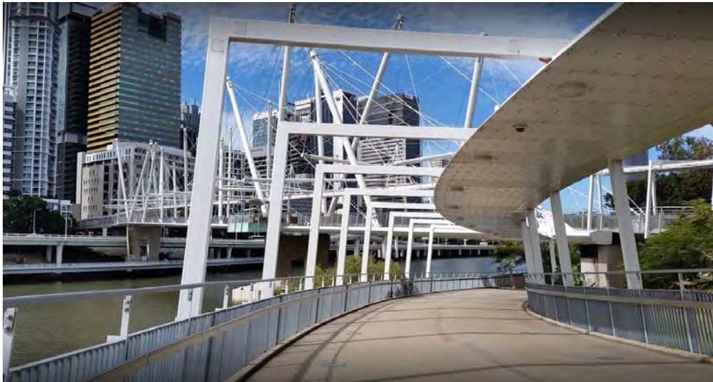
Figure 8.3-5 : Pont Kurilpa à Brisbane, Australie
