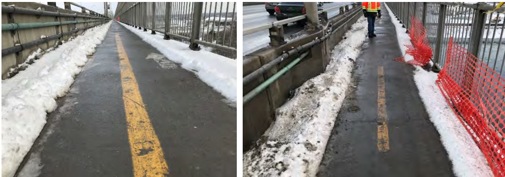
Figure 3.4-5 : Condition de surface humide, dégagée et non glacée (suivi du scénario de base, 2018.02.01)
