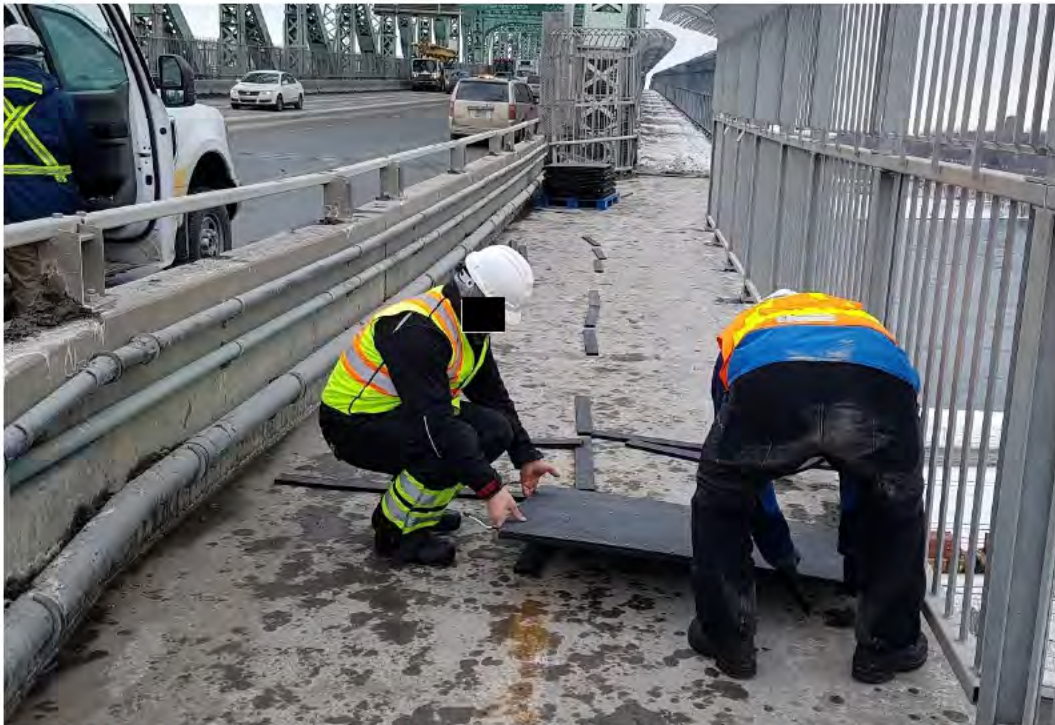
Figure 6.4-4 : Les tapis chauffants sont déposés sur des coussins de caoutchoucs apposés directement sur la dalle
