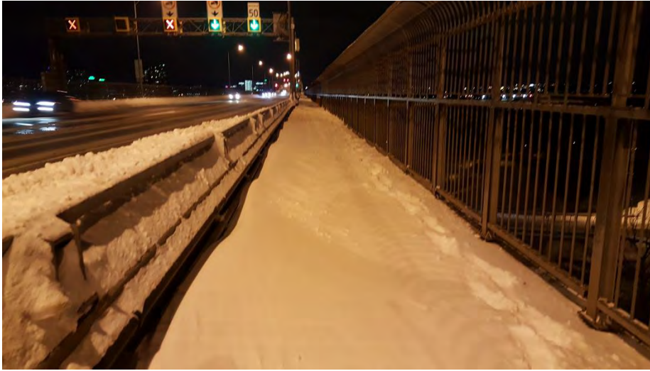
Figure 7.6-18 : Figure tirée de la visite du site le 13 janvier. La profondeur de neige mesurée sur le chantier était d'environ 35 cm
