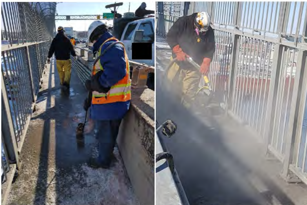
Figure 6.4-9 : Préparation de la surface au chalumeau et au jet de sable
