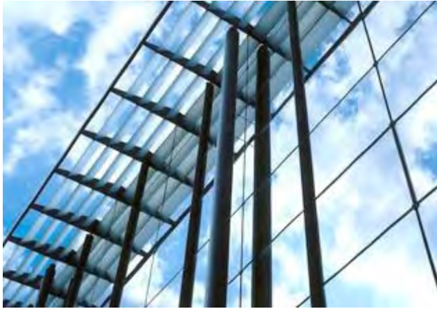
Figure 8.3-7 : Exemple de déflecteurs en verre - Vertal-AGC©
