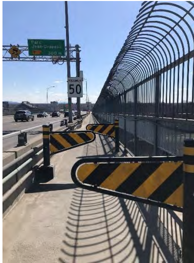
Figure 7.2-2 : Chicanes installées sur le pont Jacques-Cartier en avril 2018
