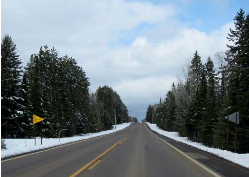
Figure 3.4-3 : Condition de surface « à sec, sèche et non glacée », sur un chemin routier a Minnesota (source : AASHTO). Le passage du trafic autoroutier permet l'assèchement des surfaces de roulement en hiver, contrairement aux pistes cyclables
