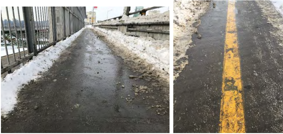
Figure 3.4-6 : Condition de surface humide, avec des résidus et non glacée (suivi du scénario amélioré, 2018.02.09)
