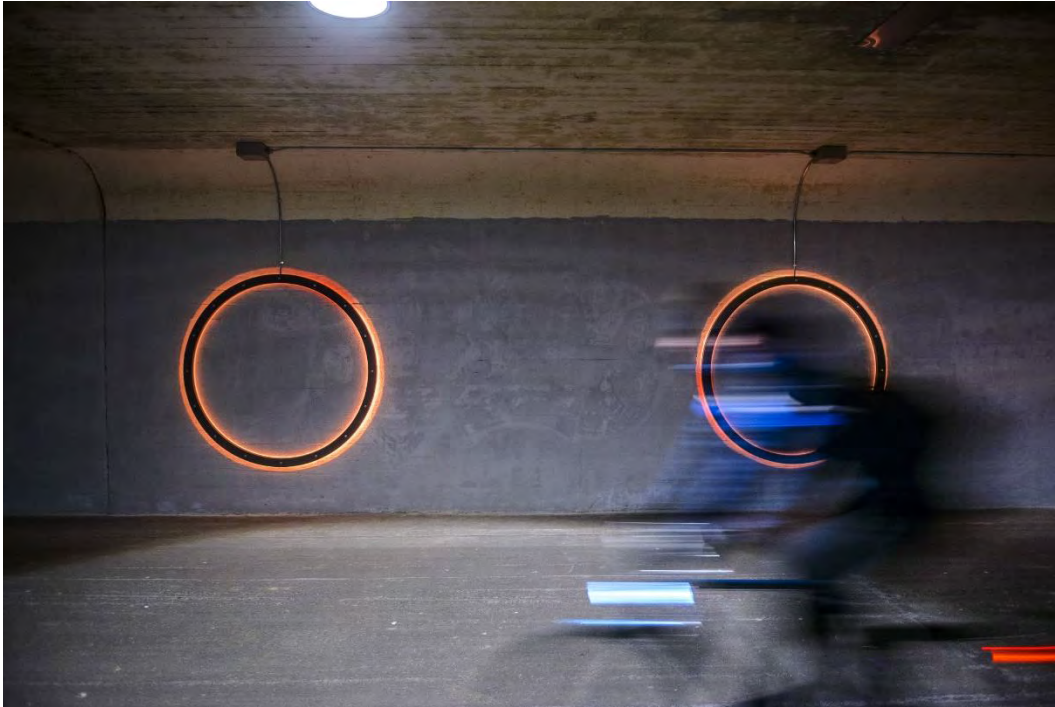
Figure 7.2-4 : Lumières sensibles au passage des cyclistes dans les portions souterraines de la Cycle Superhighway au Danemark
