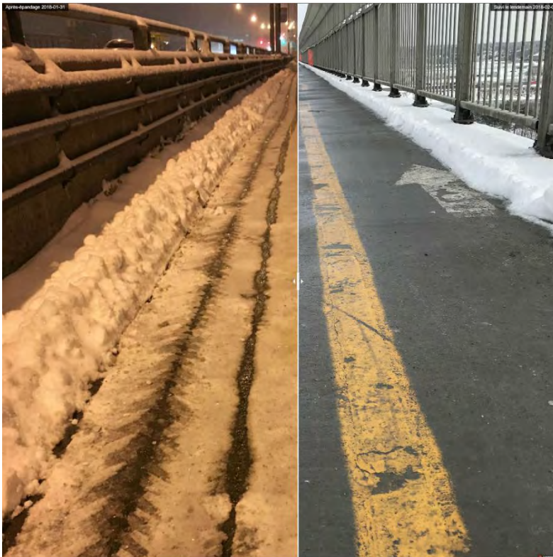
Figure 3.7-10 : Comparaison entre la surface de la dalle immédiatement après l'épandage des produits solides vs la condition de la surface 8 heures après. On observe que le produit s'est distribué graduellement sur toute la largeur de la dalle.
