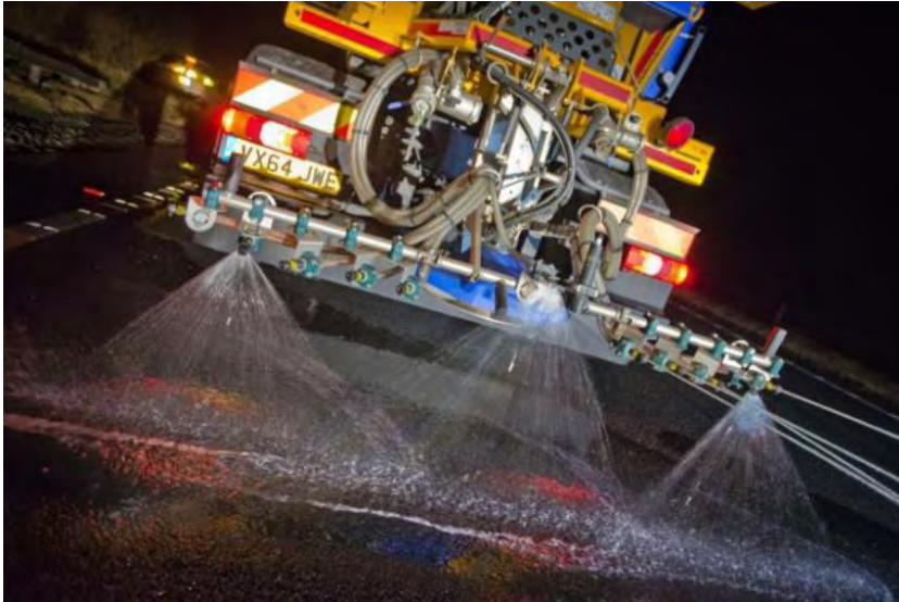
Figure 3.7-11 : Citerne pour l'aspersion des produits liquides ( Brine spreader ), Autoroute A1, R.-U. (source : XV International Winter Road Congress, 2018, Gdansk, Pologne).
