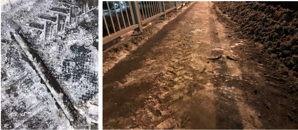
Figure 3.4-8 : Condition de surface glacée avec résidus de neige, suite au passage de la pelle à lame lisse et avant l'application des produits
