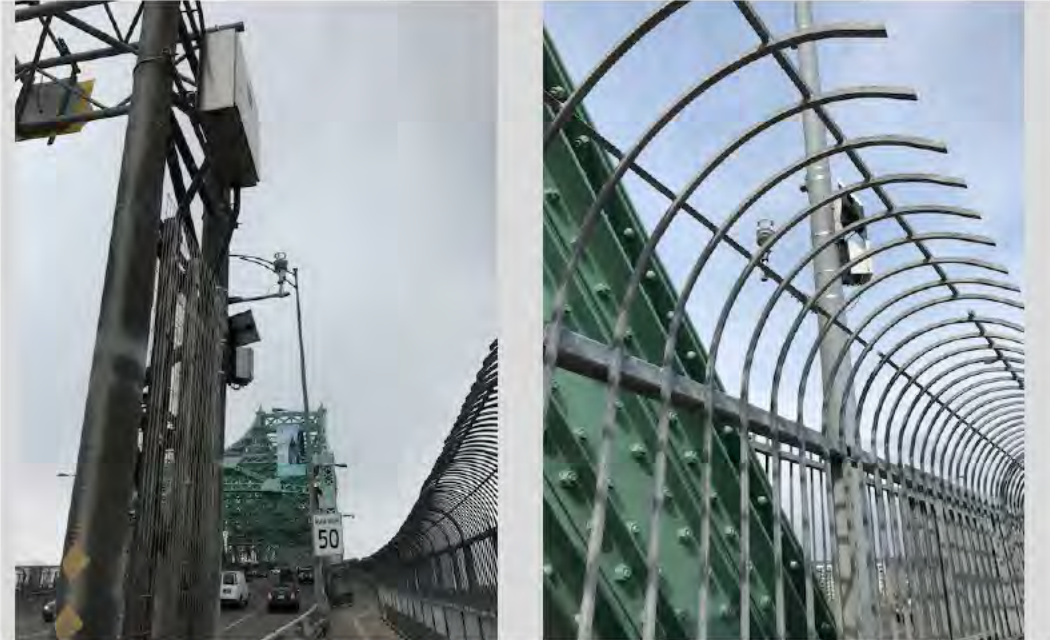
Figure 7.6-5 : SPJCC-Ouest et SPJCC-Est. Les deux stations sont abritées de certains vents par la structure du pont, la signalisation, les lampadaires et d'autres éléments.
