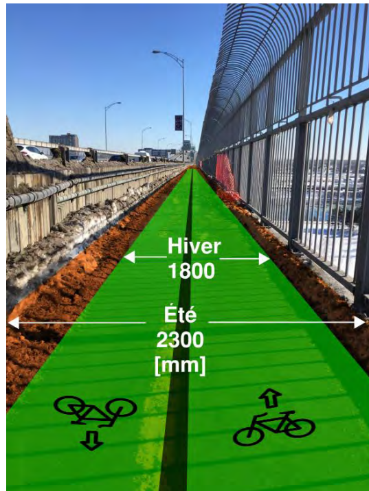
Figure 7.1-5 : Dégagement latéral réduit lors du déneigement hivernal
