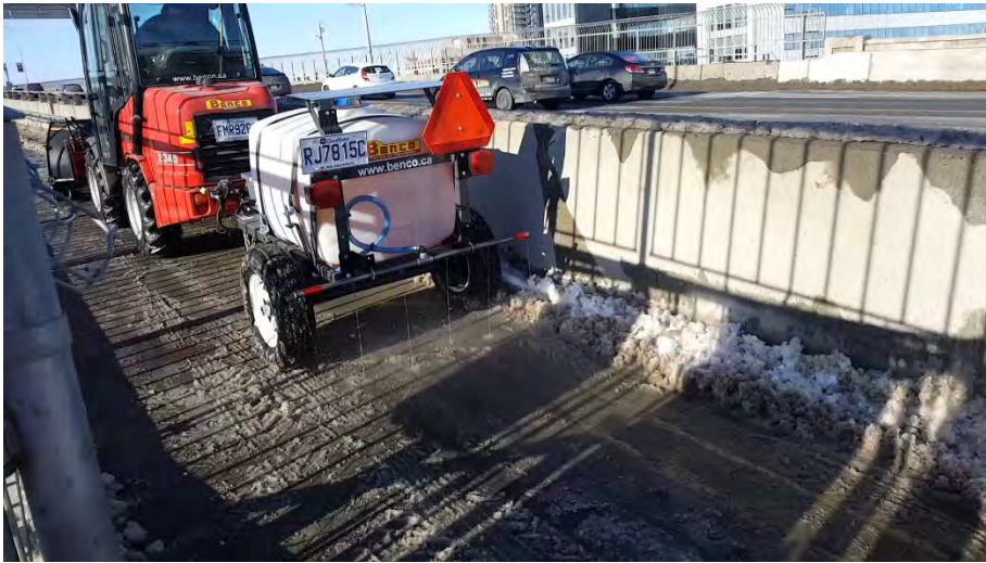
Figure 3.7-9 : Remorque avec épandeur de produits liquides ; on observe le jet et la trace en forme des « rainures » sur la dalle
