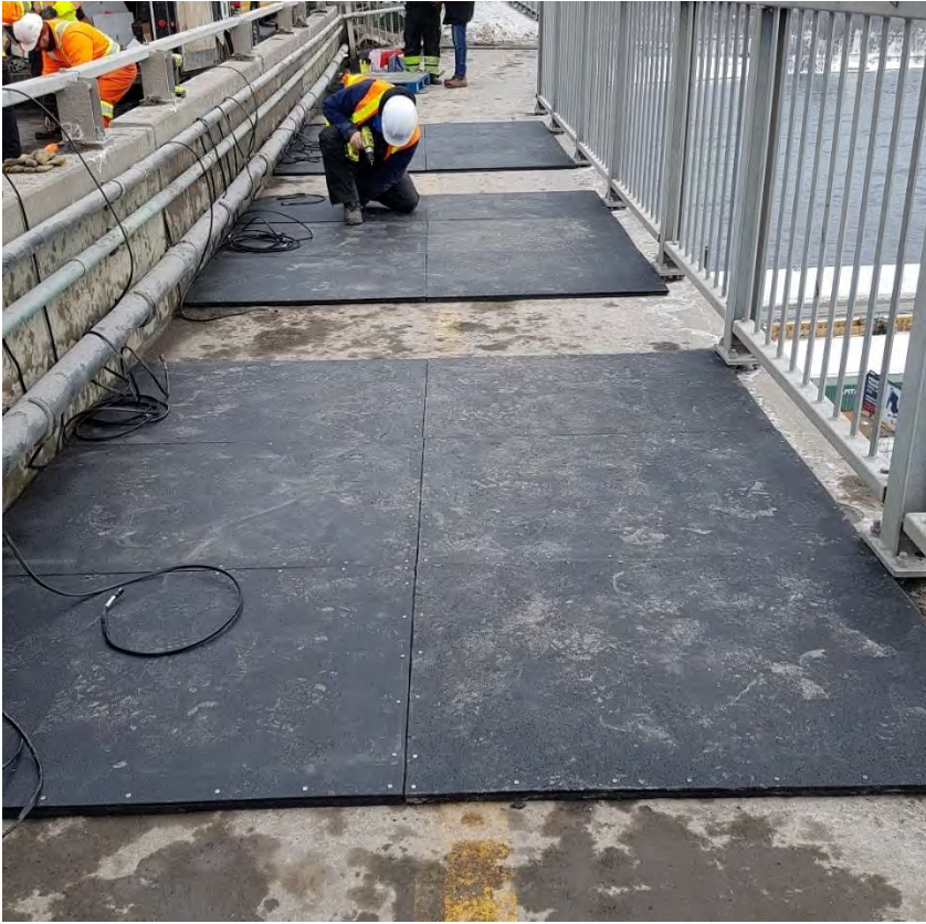
Figure 6.4-6 : Installation des tapis chauffants complétée
