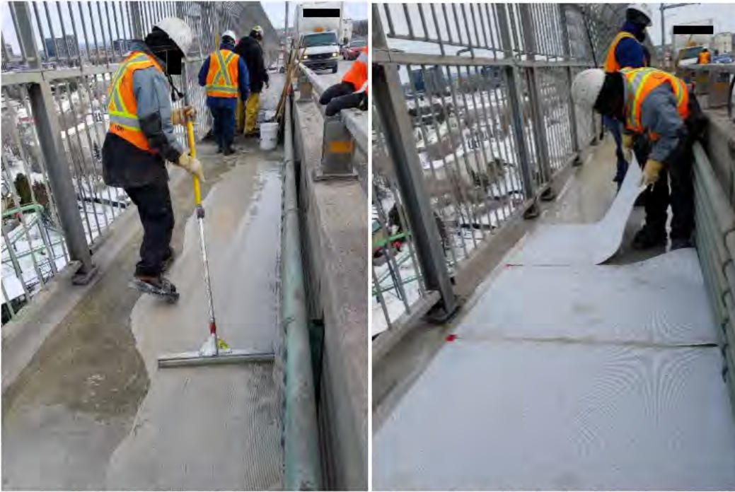
Figure 6.4-10 : Application de la membrane et installation de la pellicule chauffante
