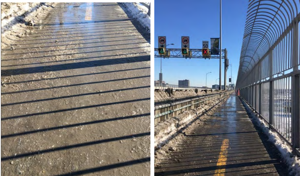
Figure 3.4-7 : Condition de surface avec une fine couche de neige fondante ou slush , pas de sous-couche glacée (suivi du scénario amélioré, 2018.02.13)
