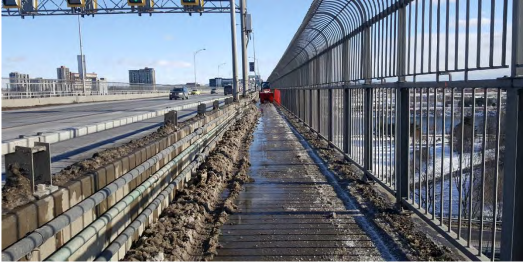
Figure 3.4-1 : Largeur résiduelle réduite de la piste lors du passage des équipements mécaniques
