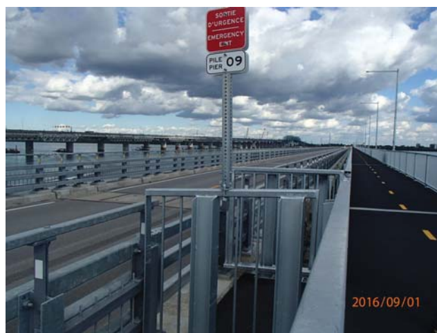
Figure 3 - Structure du dessus de l'Estacade et de la piste cyclable
