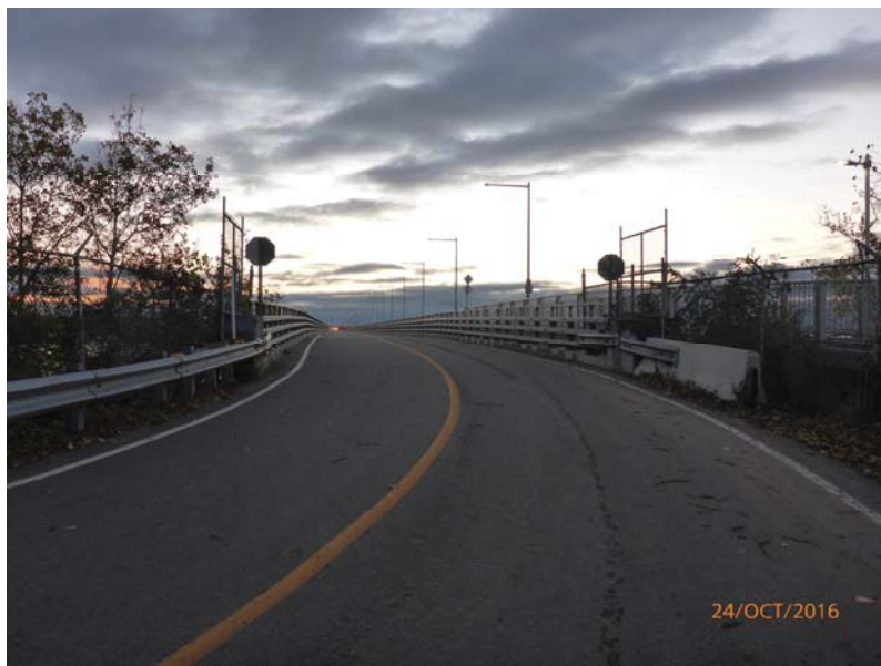
Figure 5 - Approche de l'Estacade
