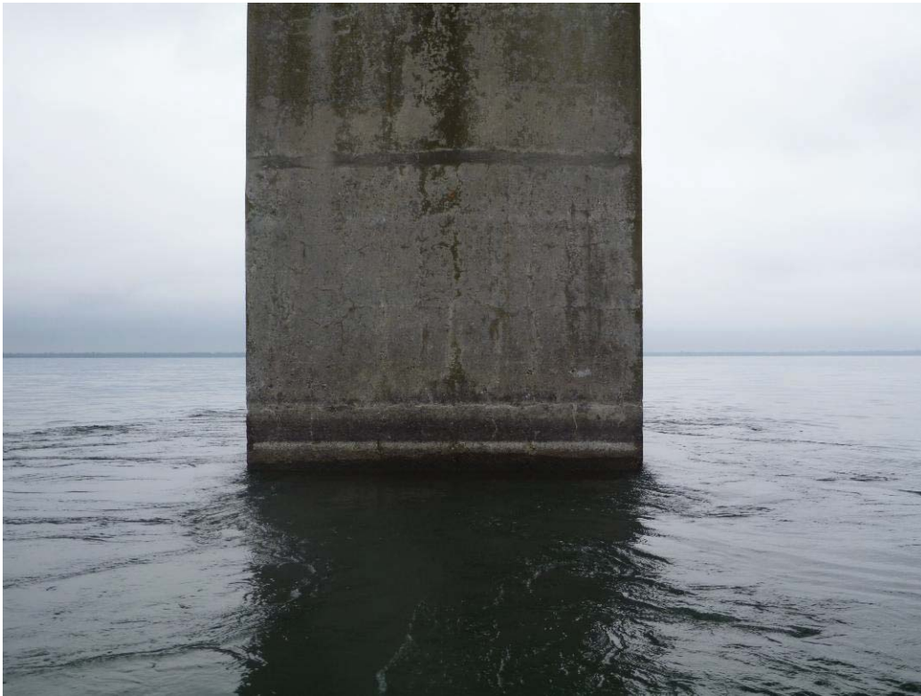
Figure 272 : Paroi aval / Pile 10 (ES10-AV)
