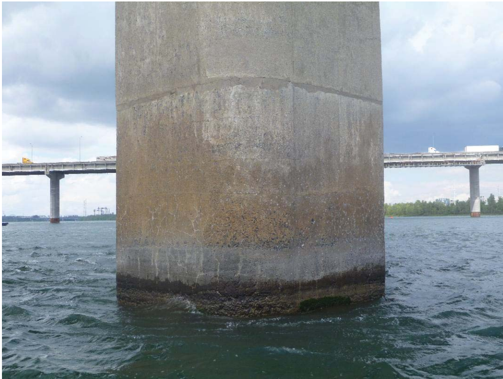
Figure 314 : Paroi amont / Pile 58 (ES58-AM)
