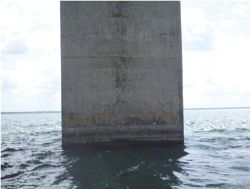
Figure 332 : Paroi aval / Pile 62 (ES62-AV)
