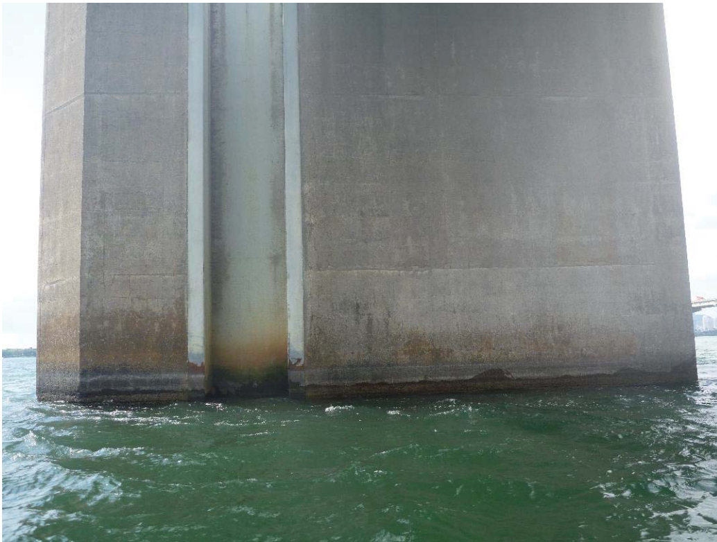
Figure 297 : Paroi droite / Pile 53 (ES53-PD)
