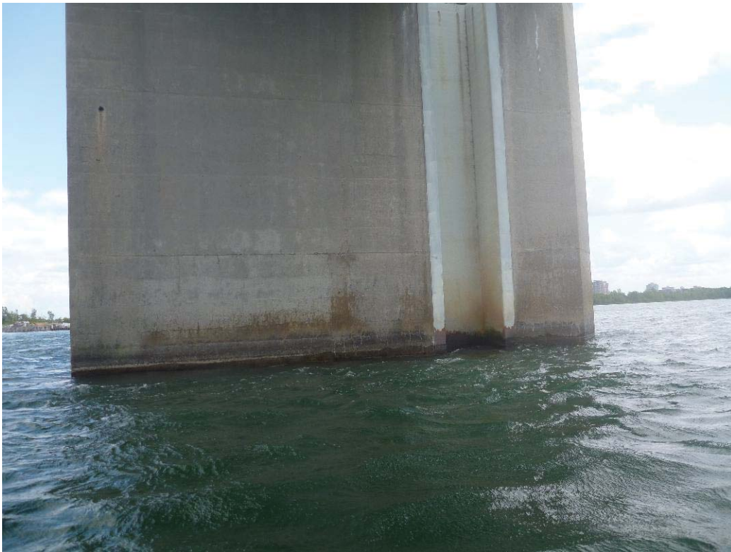
Figure 299 : Paroi gauche / Pile 54 (ES54-PG)
