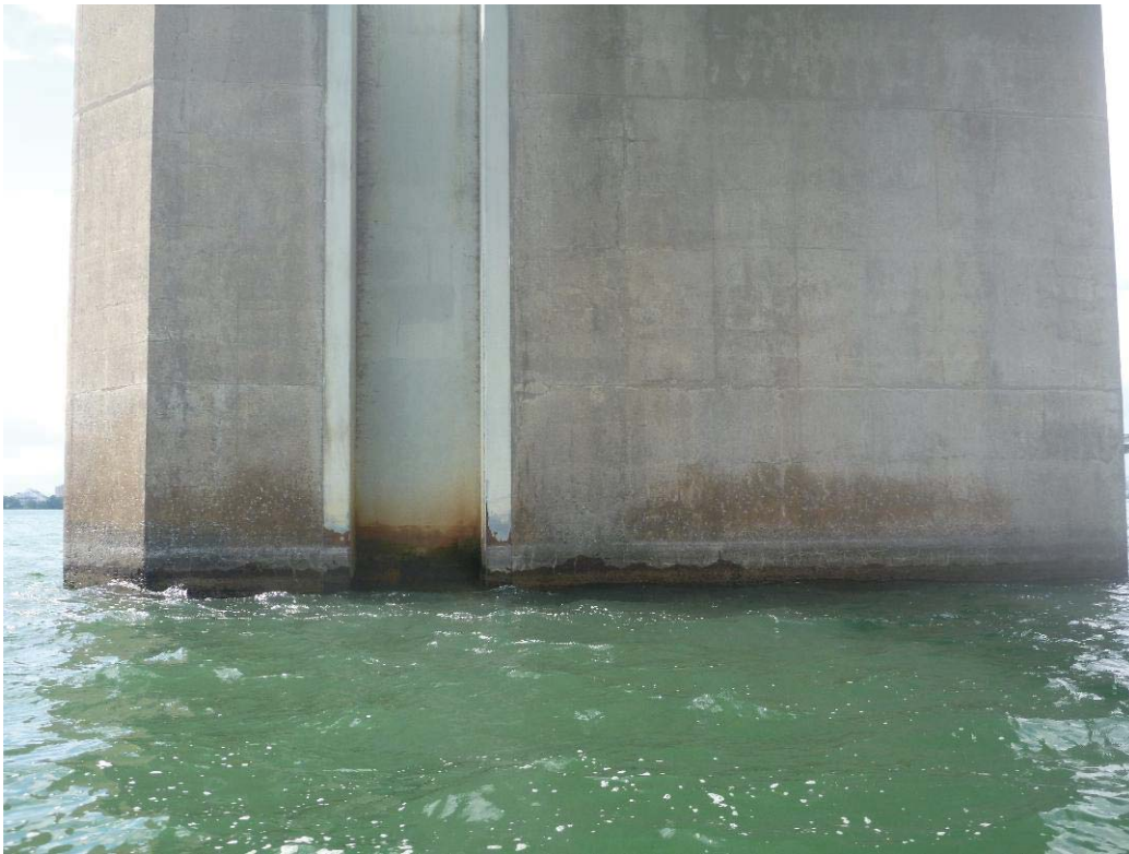
Figure 309 : Paroi droite / Pile 56 (ES56-PD)
