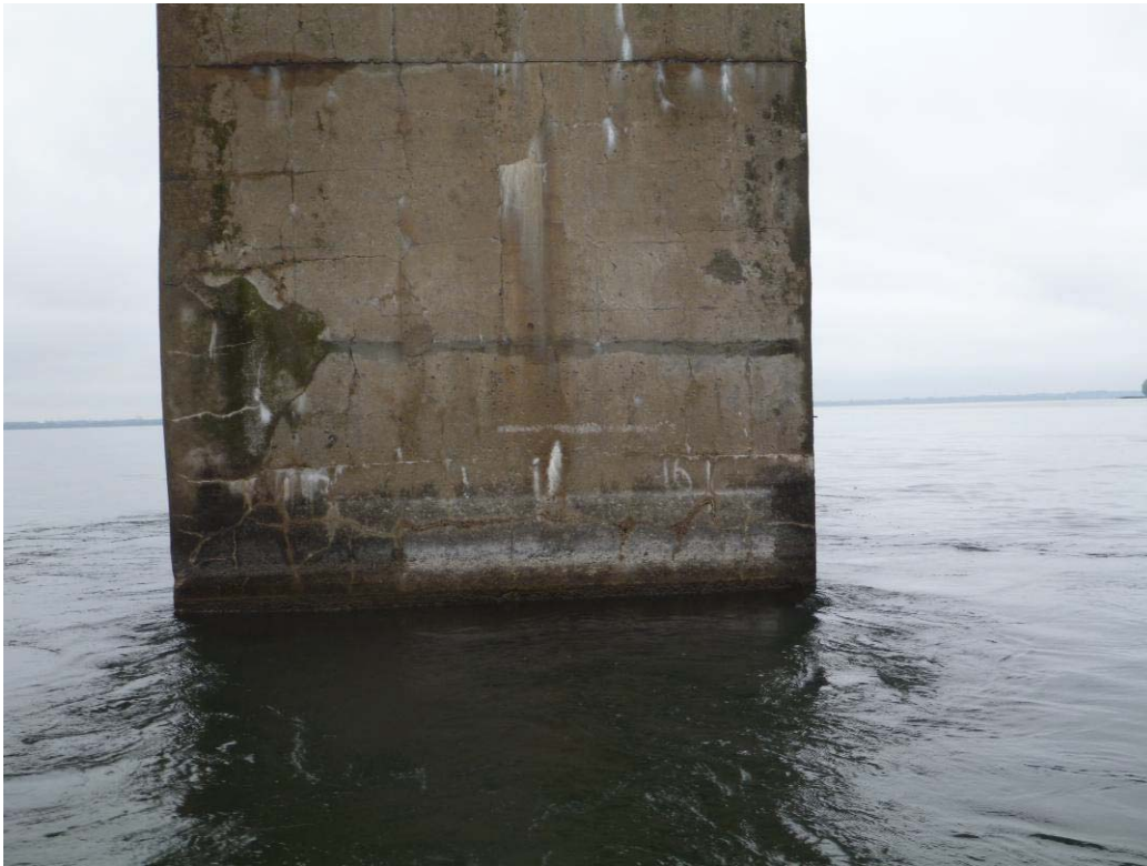
Figure 240 : Paroi aval / Pile 02 (ES02-AV)
