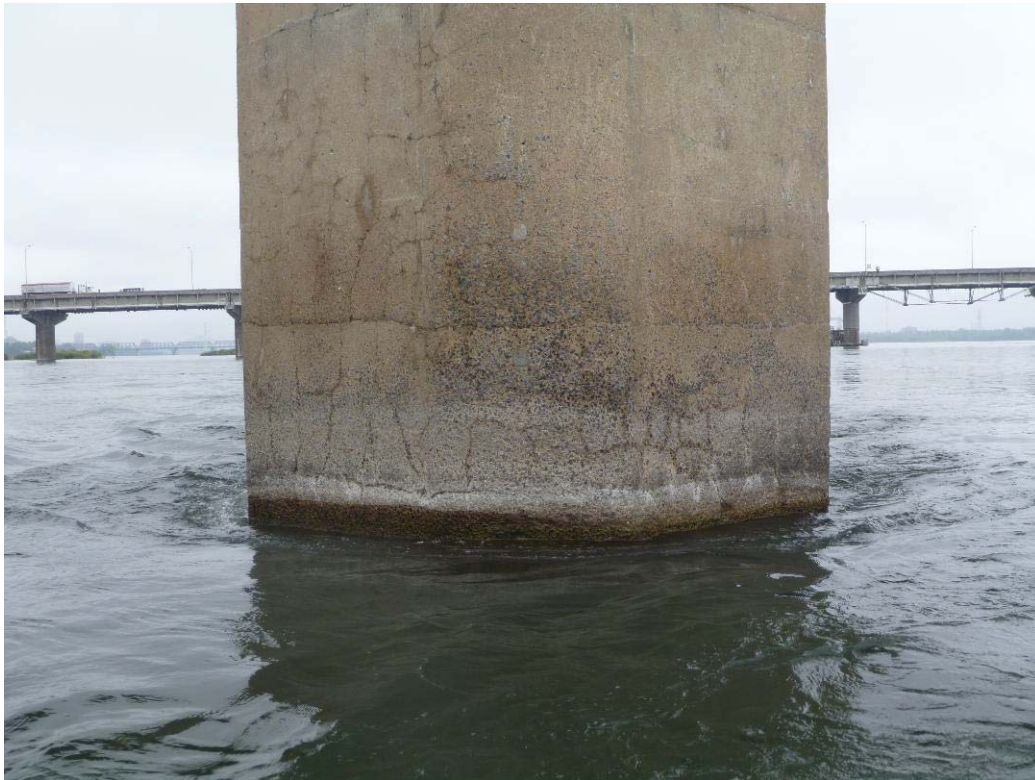
Figure 246 : Paroi amont / Pile 04 (ES04-AM)
