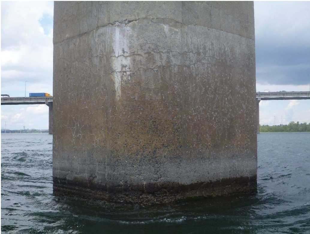
Figure 298 : Paroi amont / Pile 54 (ES54-AM)
