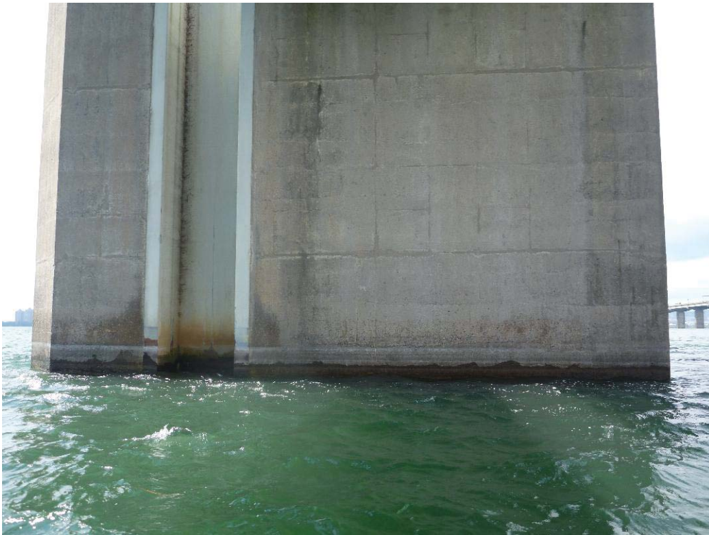
Figure 369 : Paroi droite / Pile 71 (ES71-PD)
