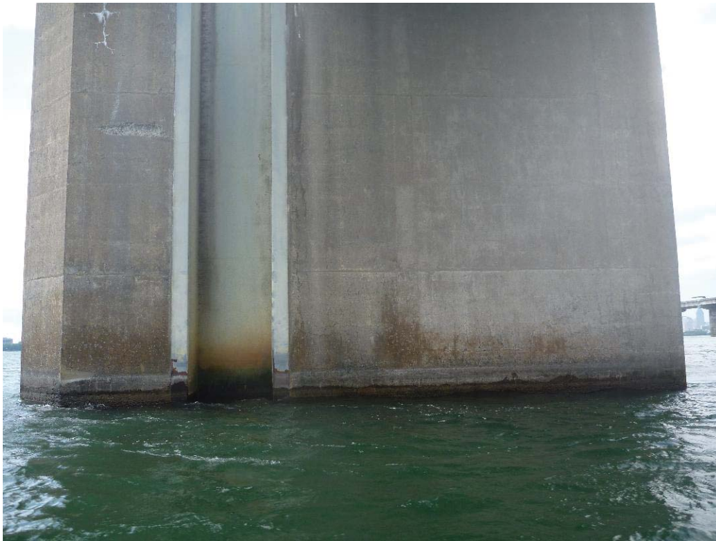
Figure 305 : Paroi droite / Pile 55 (ES55-PD)
