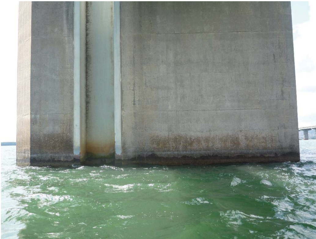
Figure 333 : Paroi droite / Pile 62 (ES62-PD)
