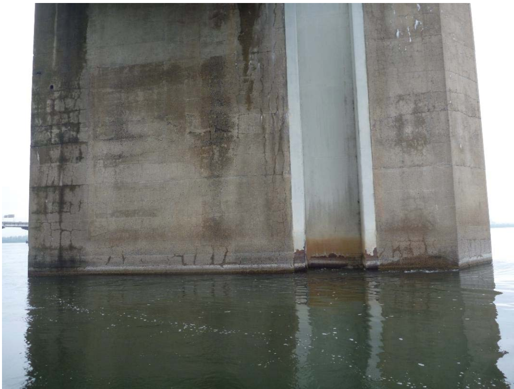
Figure 235 : Paroi gauche / Pile 01 (ES01-PG)
