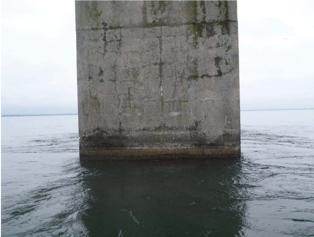
Figure 276 : Paroi aval / Pile 11 (ES11-AV)
