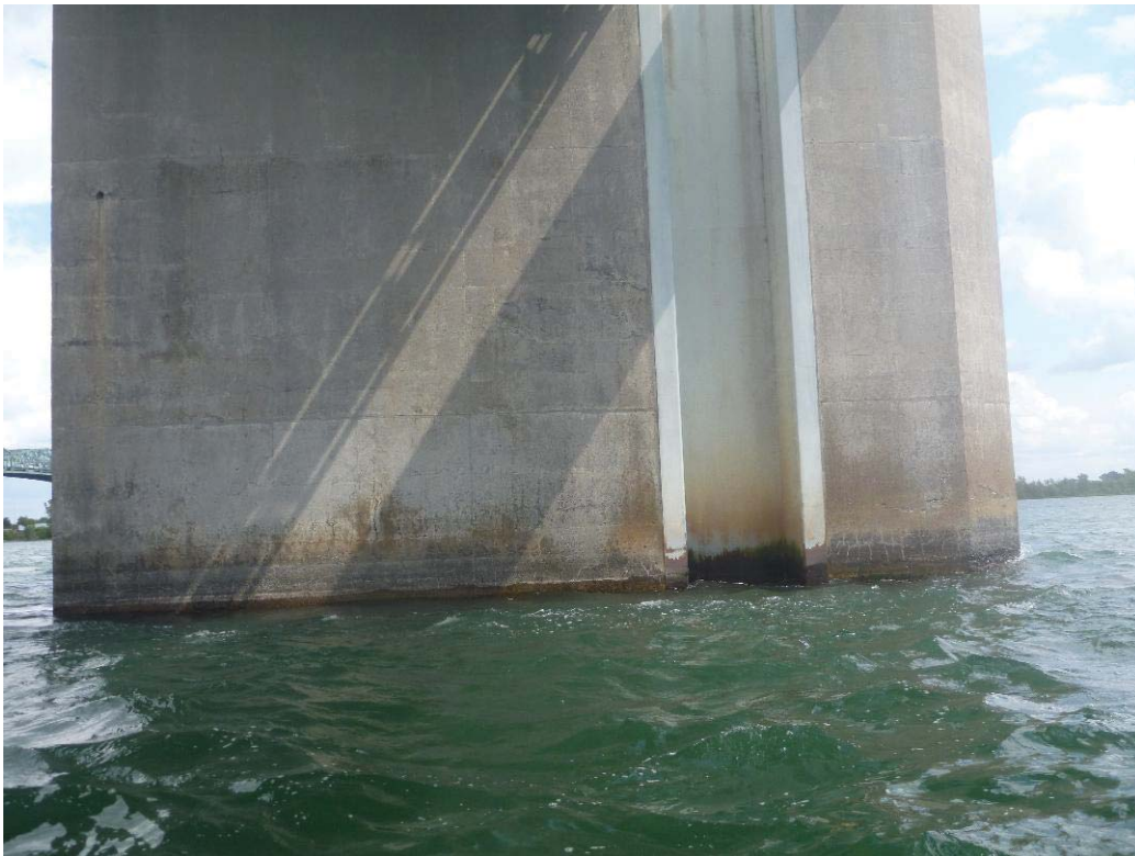
Figure 295 : Paroi gauche / Pile 53 (ES53-PG)
