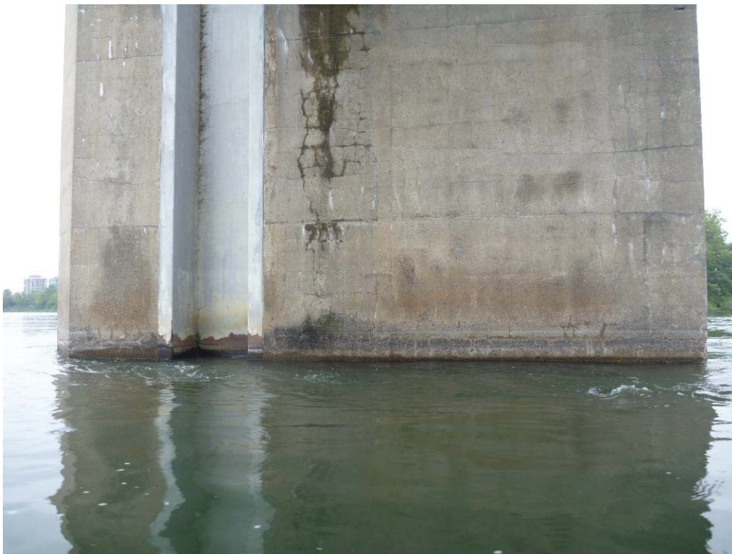
Figure 245 : Paroi droite / Pile 03 (ES03-PD)
