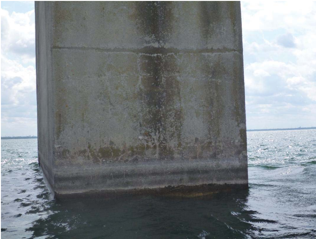
Figure 372 : Paroi aval / Pile 72 (ES72-AV)
