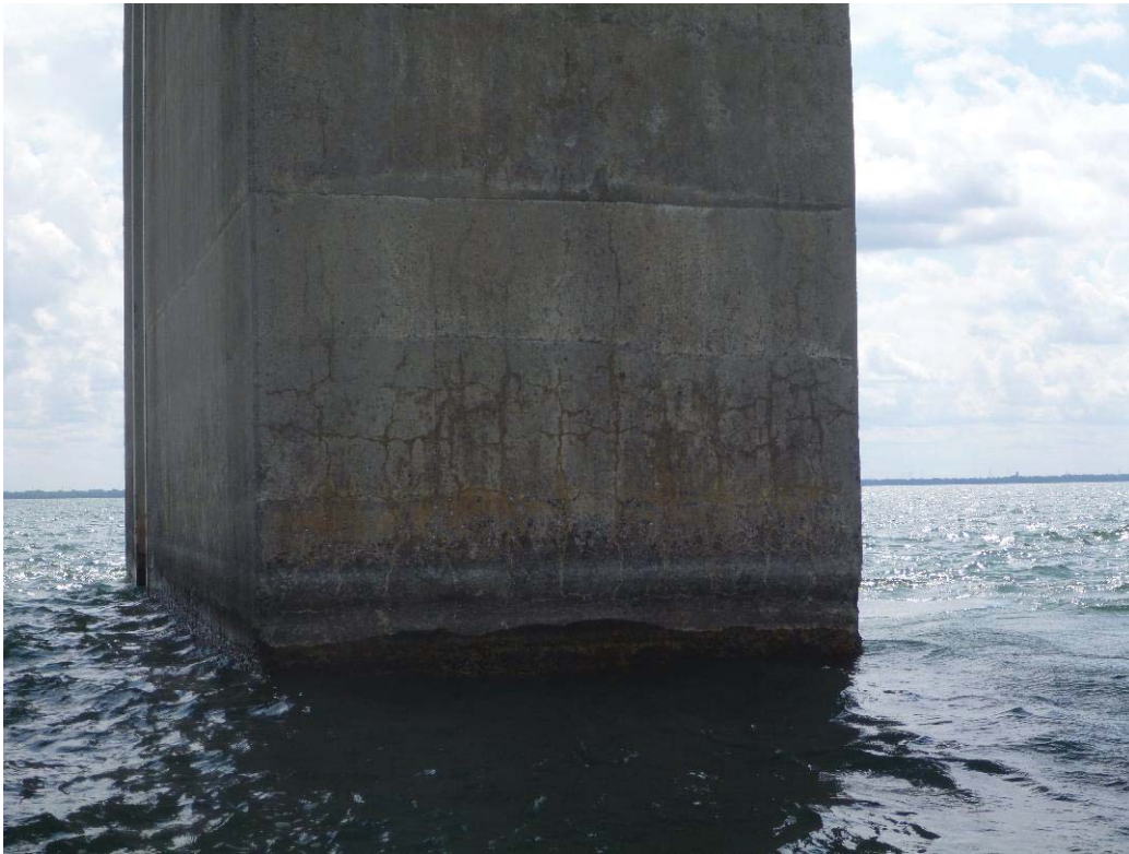
Figure 348 : Paroi aval / Pile 66 (ES66-AV)
