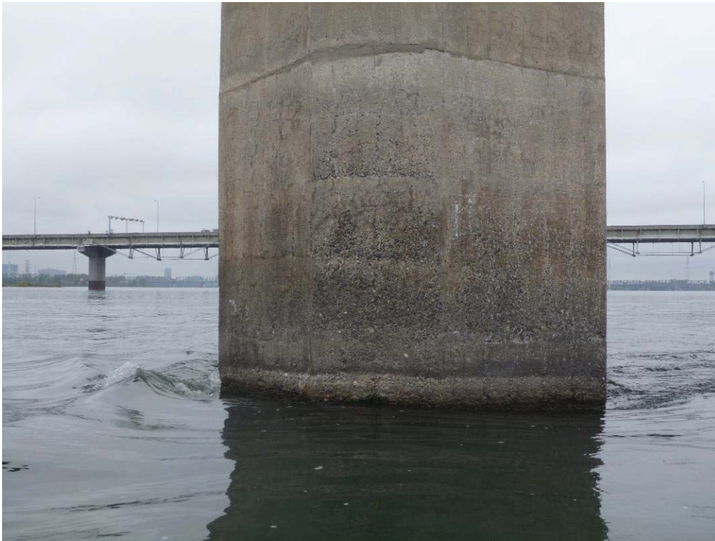
Figure 274 : Paroi amont / Pile 11 (ES11-AM)
