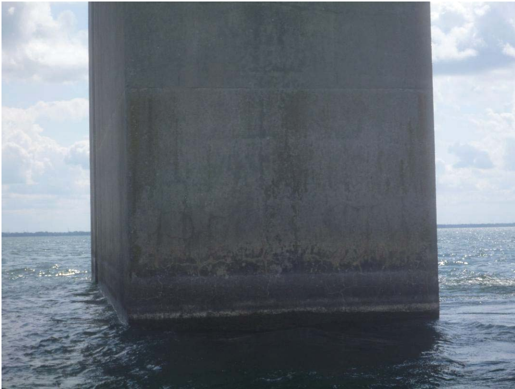
Figure 284 : Paroi aval / Pile 50 (ES50-AV)
