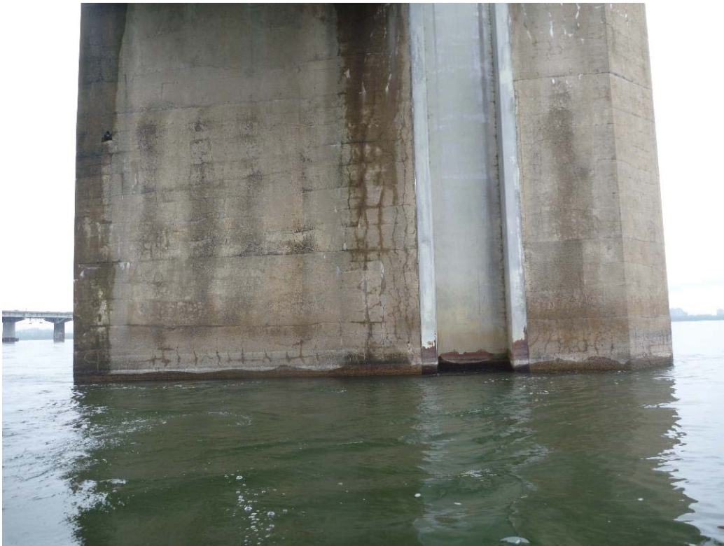
Figure 239 : Paroi gauche / Pile 02 (ES02-PG)
