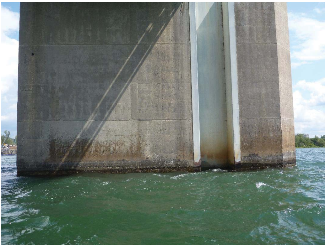
Figure 347 : Paroi gauche / Pile 66 (ES66-PG)
