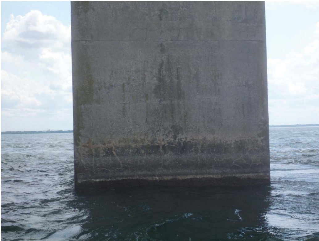
Figure 296 : Paroi aval / Pile 53 (ES53-AV)
