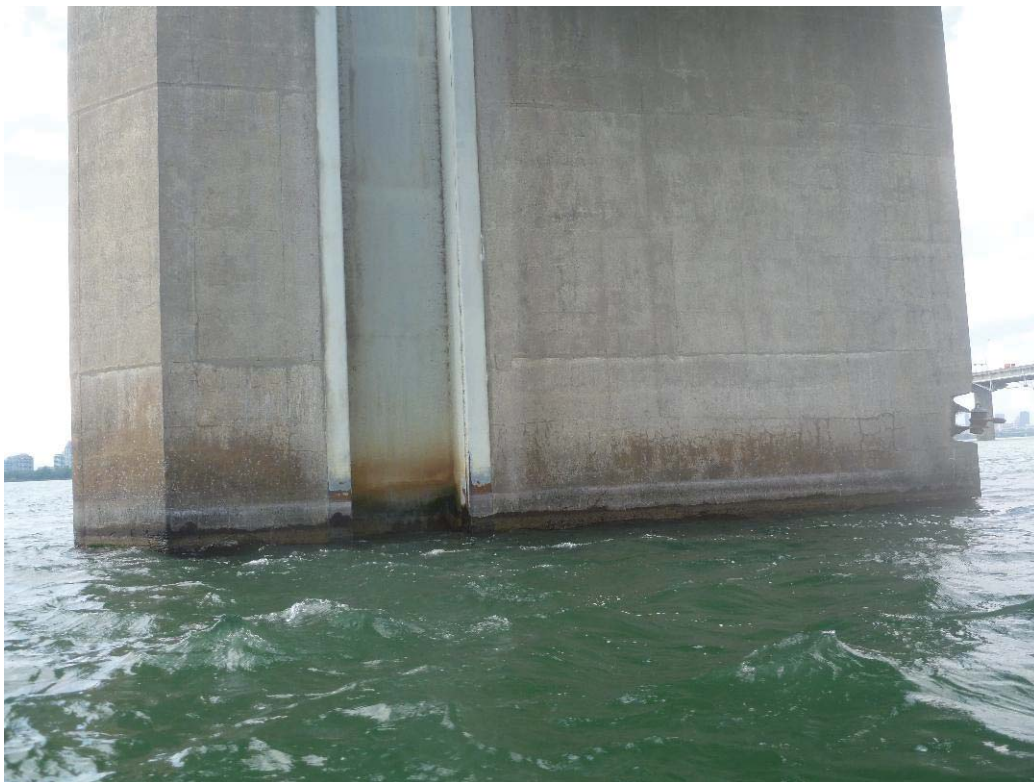
Figure 317 : Paroi droite / Pile 58 (ES58-PD)
