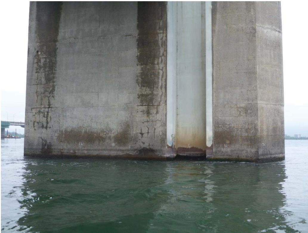
Figure 275 : Paroi gauche / Pile 11 (ES11-PG)
