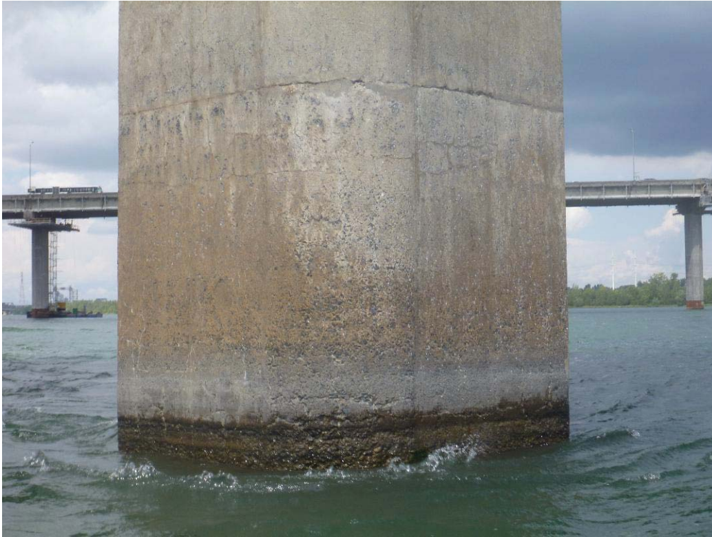
Figure 302 : Paroi amont / Pile 55 (ES55-AM)
