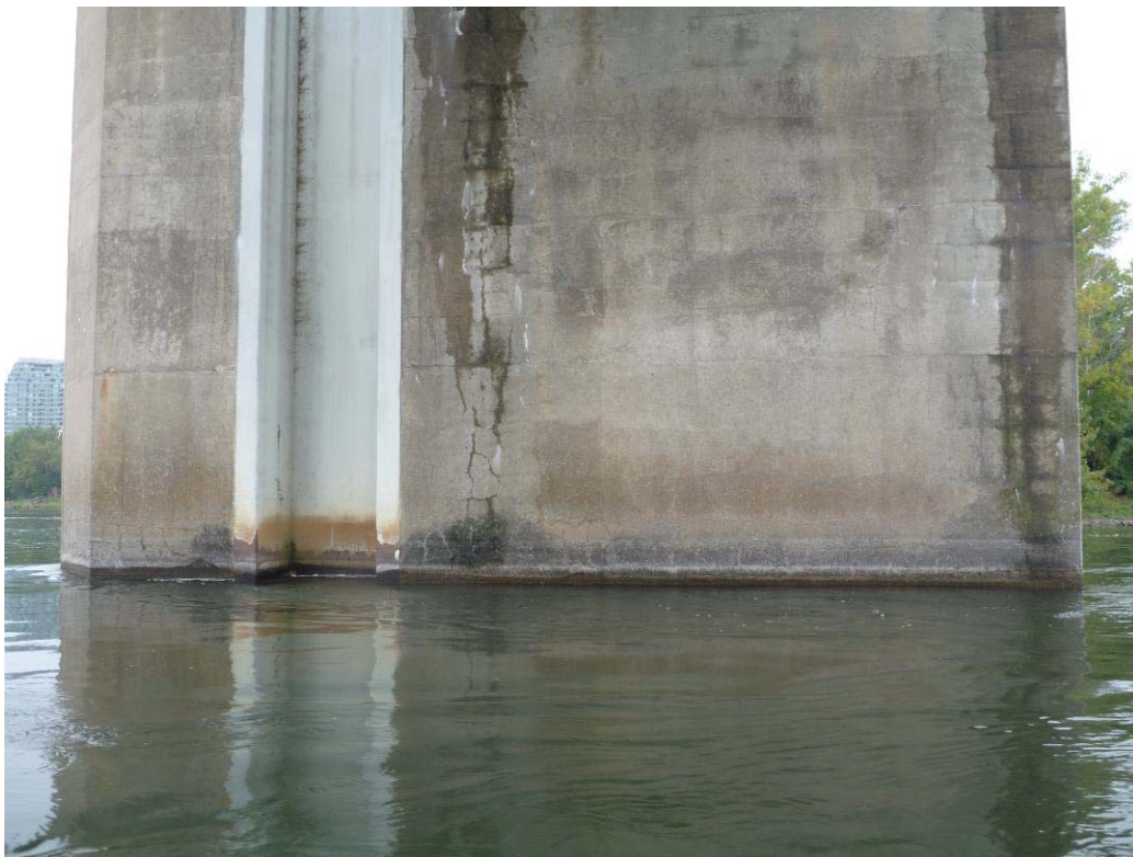
Figure 237 : Paroi droite / Pile 01 (ES01-PD)
