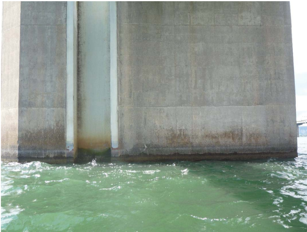
Figure 341 : Paroi droite / Pile 64 (ES64-PD)
