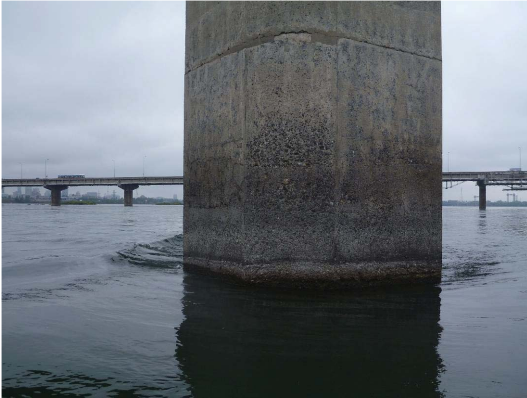
Figure 258 : Paroi amont / Pile 07 (ES07-AM)
