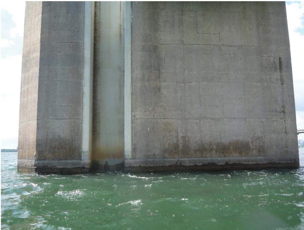
Figure 365 : Paroi droite / Pile 70 (ES70-PD)
