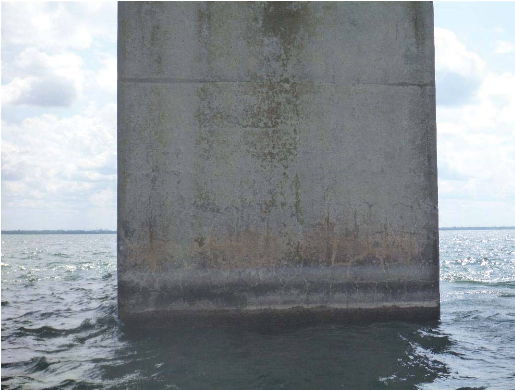
Figure 336 : Paroi aval / Pile 63 (ES63-AV)
