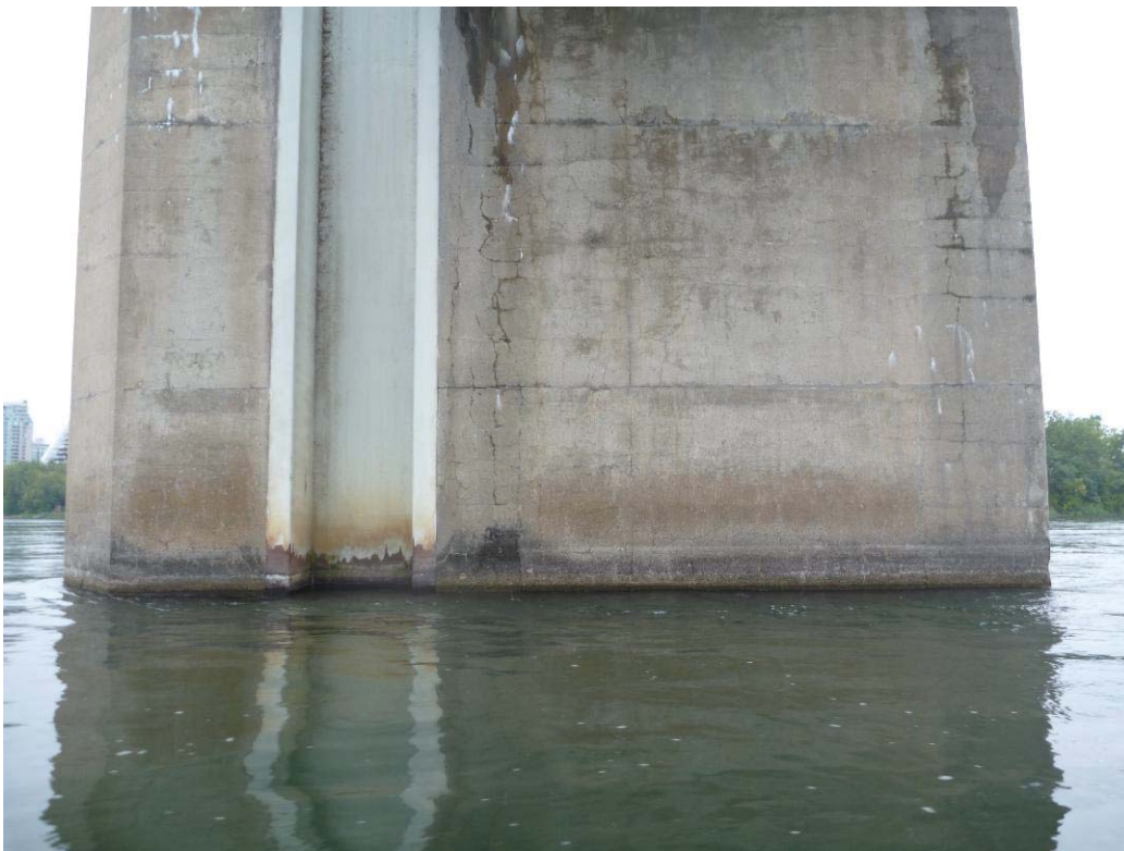
Figure 249 : Paroi droite / Pile 04 (ES04-PD)
