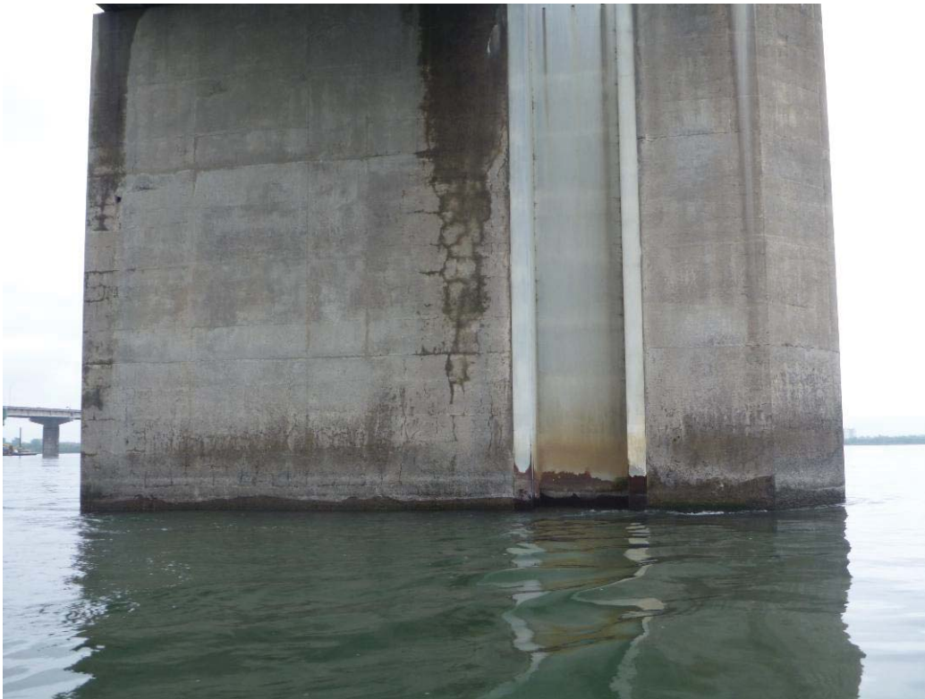
Figure 267 : Paroi gauche / Pile 09 (ES09-PG)
