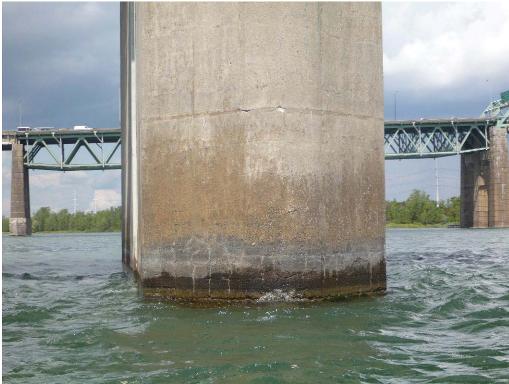
Figure 342 : Paroi amont / Pile 65 (ES65-AM)
