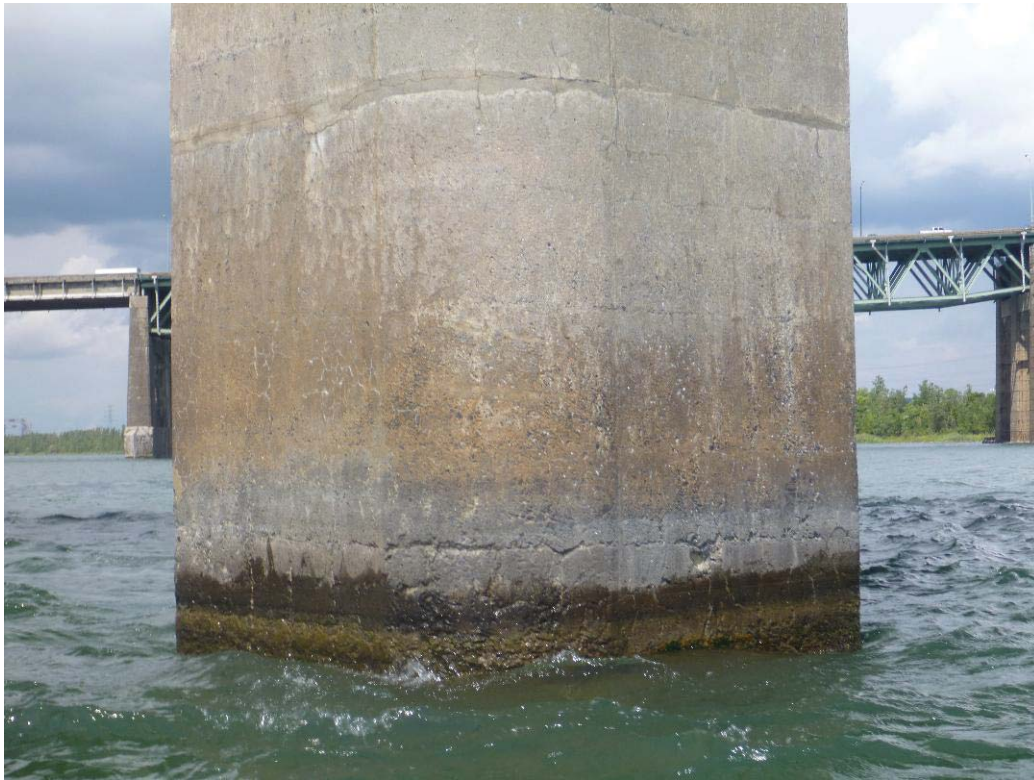
Figure 350 : Paroi amont / Pile 67 (ES67-AM)
