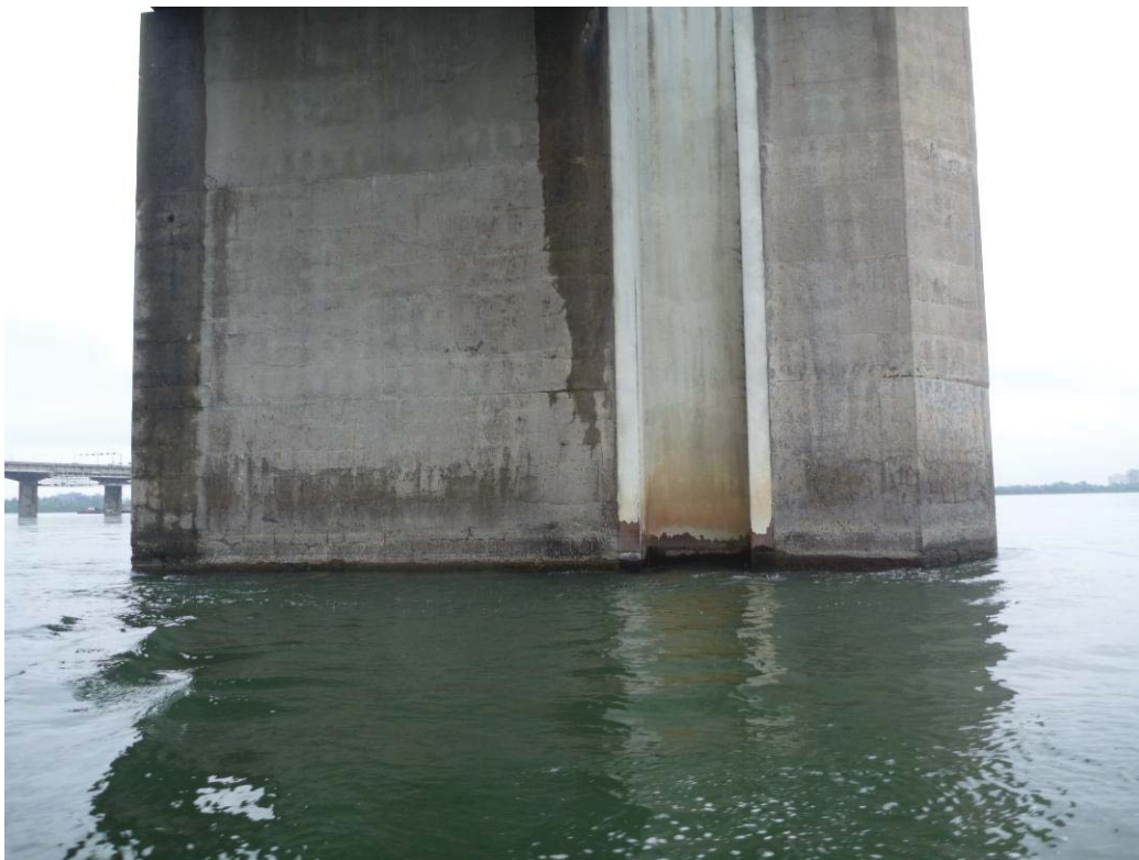
Figure 261 : Paroi droite / Pile 07 (ES07-PD)
