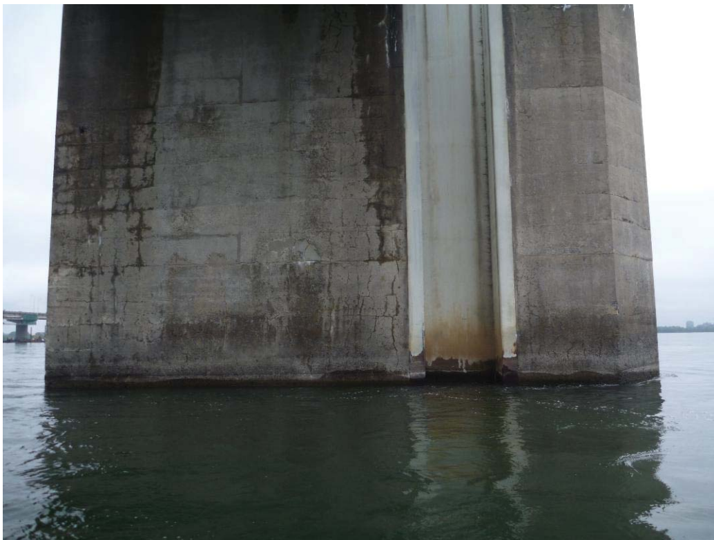
Figure 263 : Paroi gauche / Pile 08 (ES08-PG)
