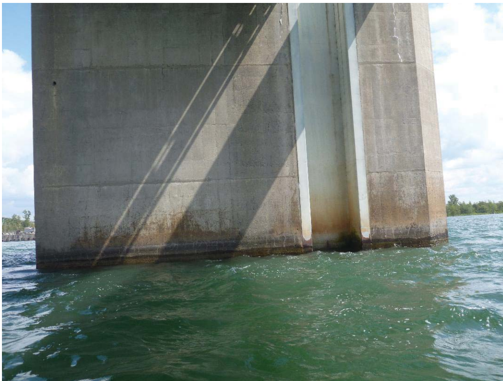
Figure 335 : Paroi gauche / Pile 63 (ES63-PG)
