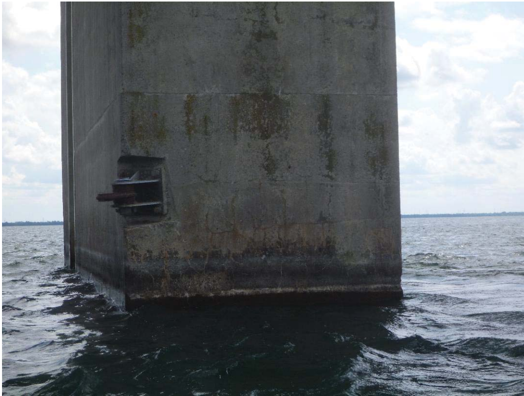
Figure 316 : Paroi aval / Pile 58 (ES58-AV)
