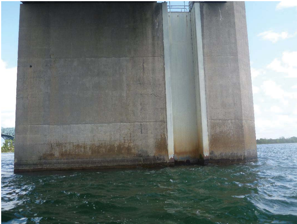
Figure 315 : Paroi gauche / Pile 58 (ES58-PG)
