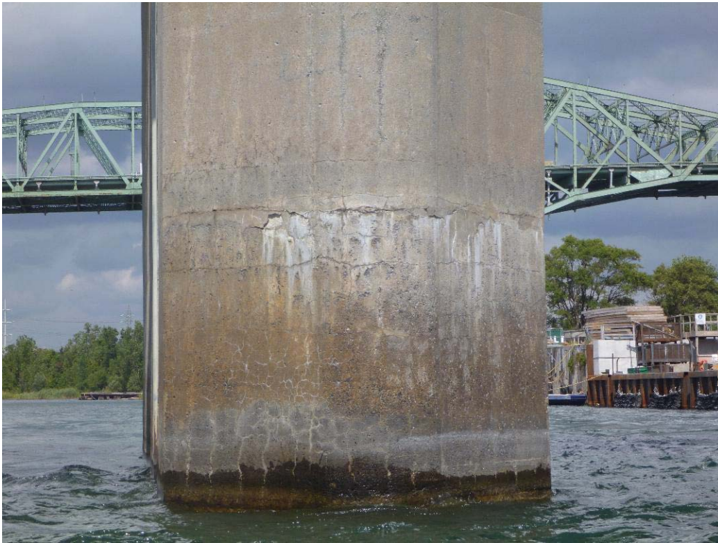
Figure 370 : Paroi amont / Pile 72 (ES72-AM)
