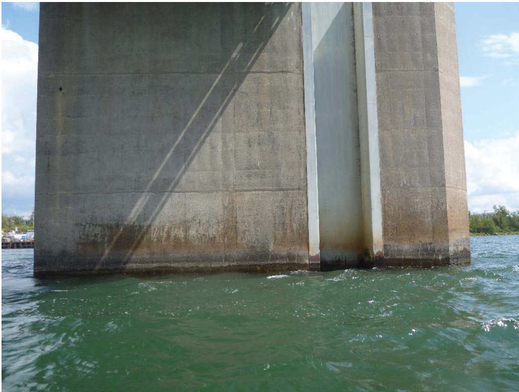
Figure 359 : Paroi gauche / Pile 69 (ES69-PG)
