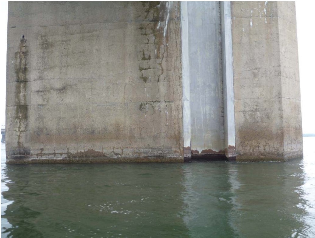
Figure 243 : Paroi gauche / Pile 03 (ES03-PG)
