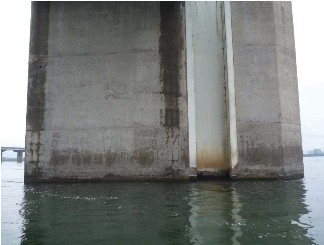
Figure 271 : Paroi gauche / Pile 10 (ES10-PG)
