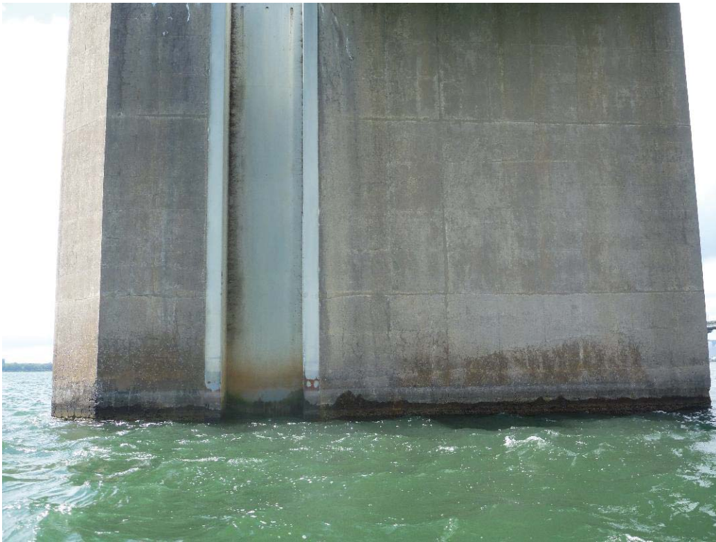
Figure 349 : Paroi droite / Pile 66 (ES66-PD)
