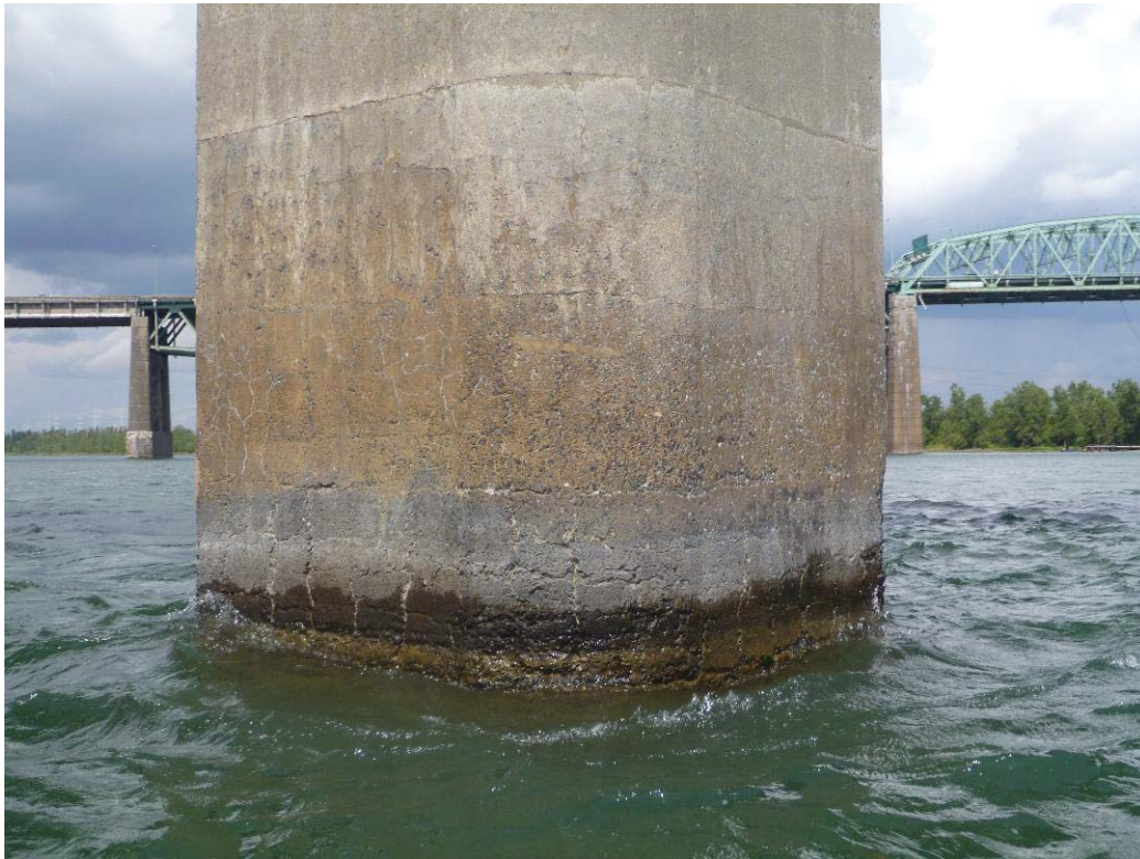
Figure 346 : Paroi amont / Pile 66 (ES66-AM)
