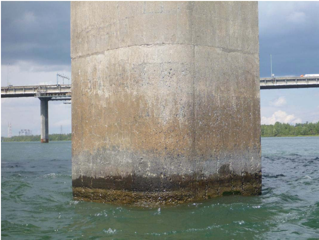
Figure 326 : Paroi amont / Pile 61 (ES61-AM)
