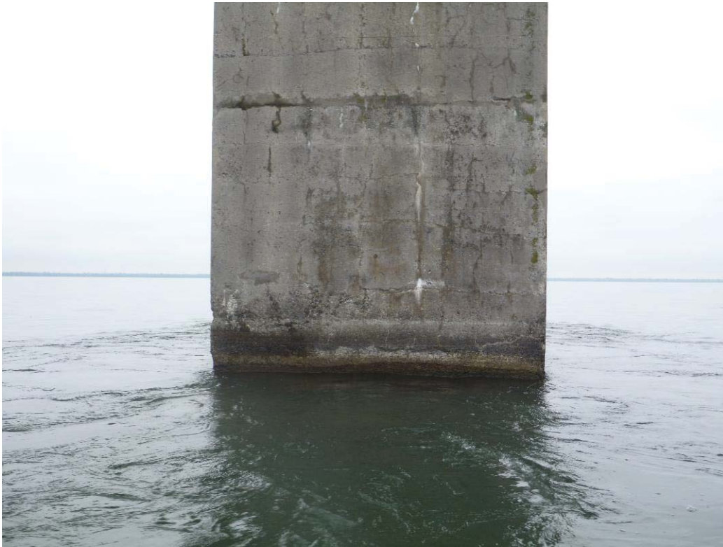
Figure 264 : Paroi aval / Pile 08 (ES08-AV)
