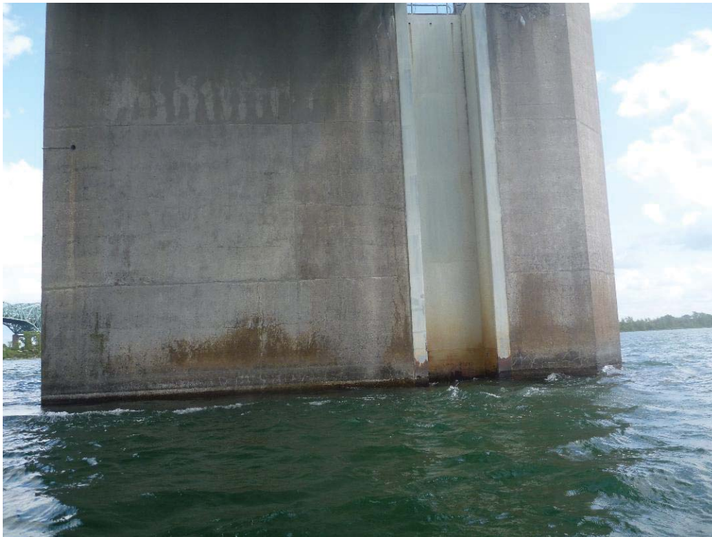
Figure 307 : Paroi gauche / Pile 56 (ES56-PG)
