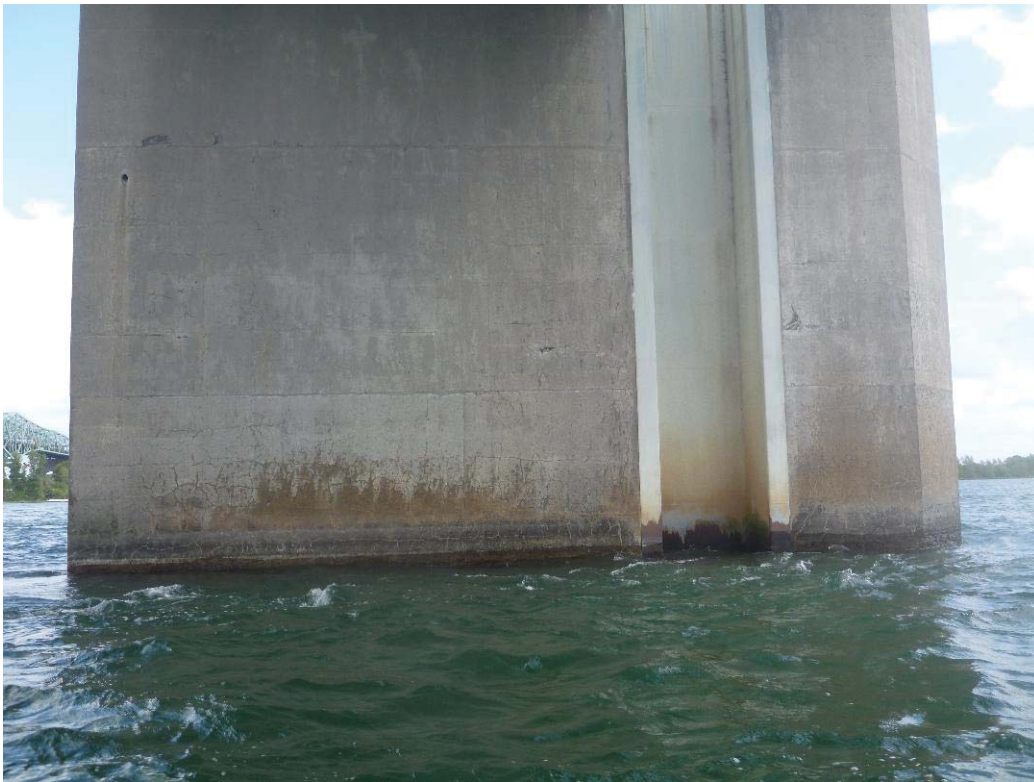
Figure 311 : Paroi gauche / Pile 57 (ES57-PG)
