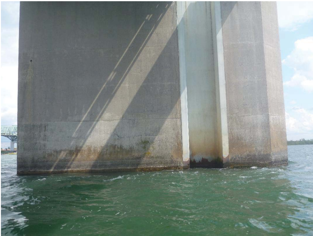
Figure 291 : Paroi gauche / Pile 52 (ES52-PG)
