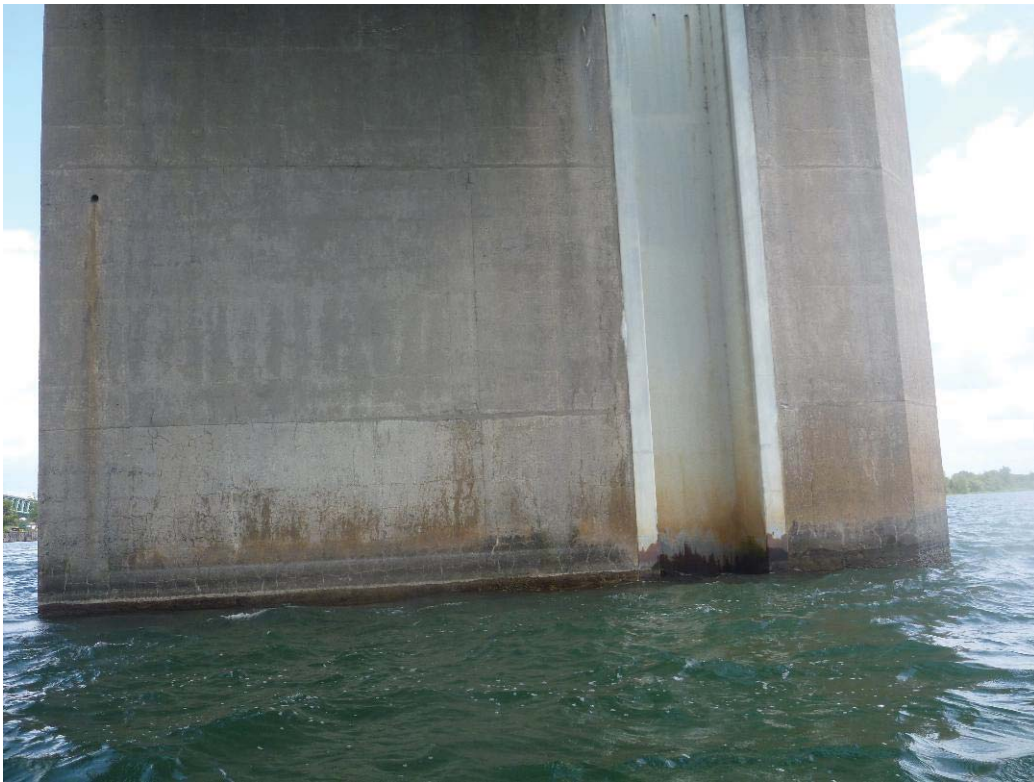
Figure 319 : Paroi gauche / Pile 59 (ES59-PG)
