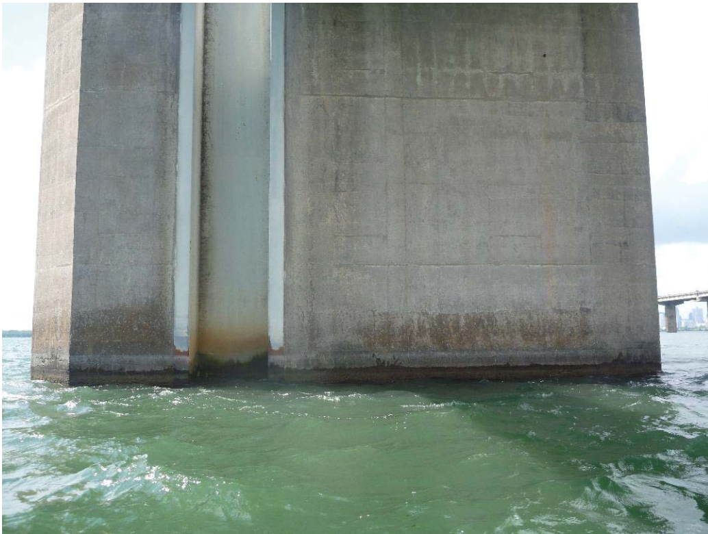
Figure 353 : Paroi droite / Pile 67 (ES67-PD)
