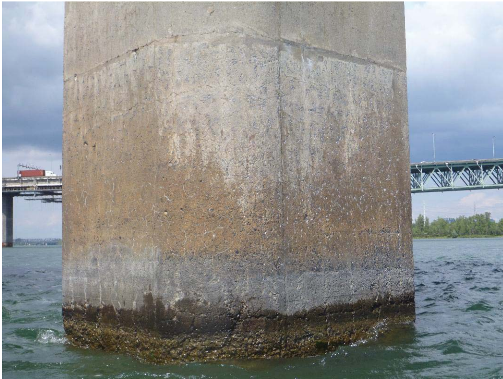
Figure 334 : Paroi amont / Pile 63 (ES63-AM)
