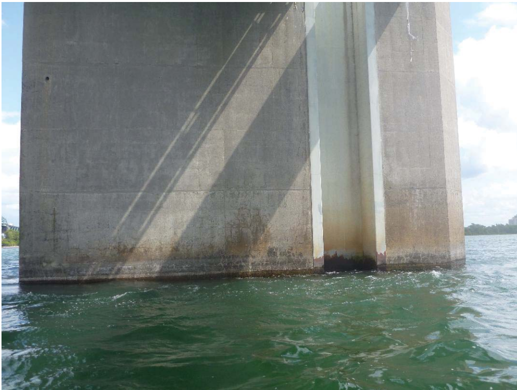
Figure 303 : Paroi gauche / Pile 55 (ES55-PG)
