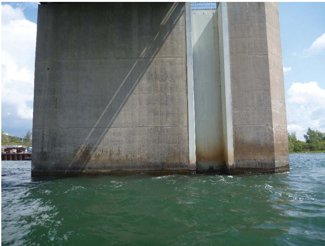
Figure 367 : Paroi gauche / Pile 71 (ES71-PG)
