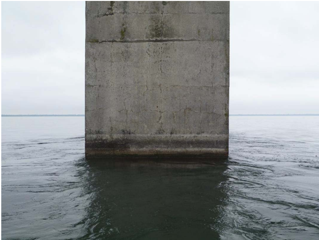
Figure 268 : Paroi aval / Pile 09 (ES09-AV)
