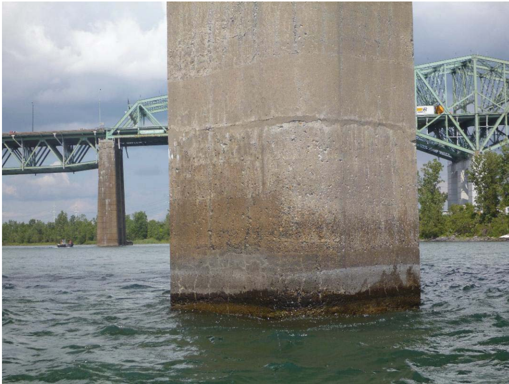
Figure 366 : Paroi amont / Pile 71 (ES71-AM)
