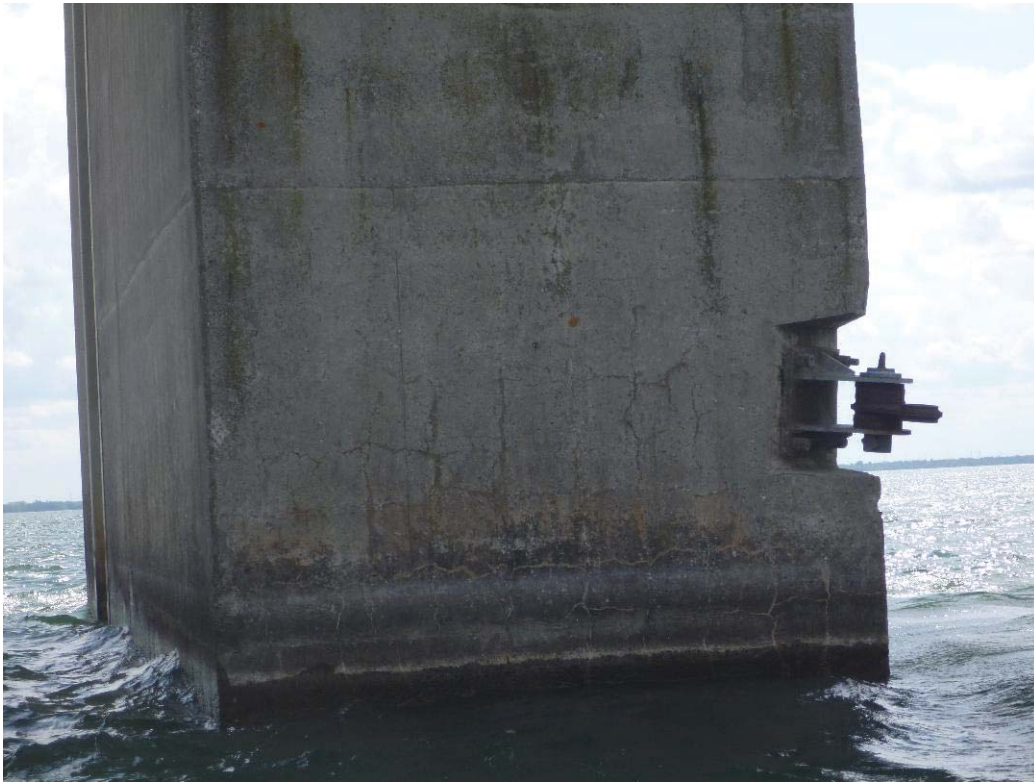
Figure 328 : Paroi aval / Pile 61 (ES61-AV)
