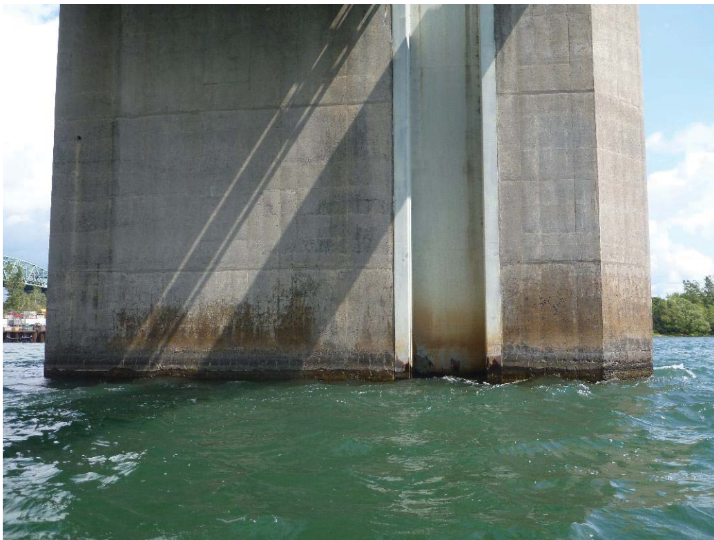
Figure 363 : Paroi gauche / Pile 70 (ES70-PG)
