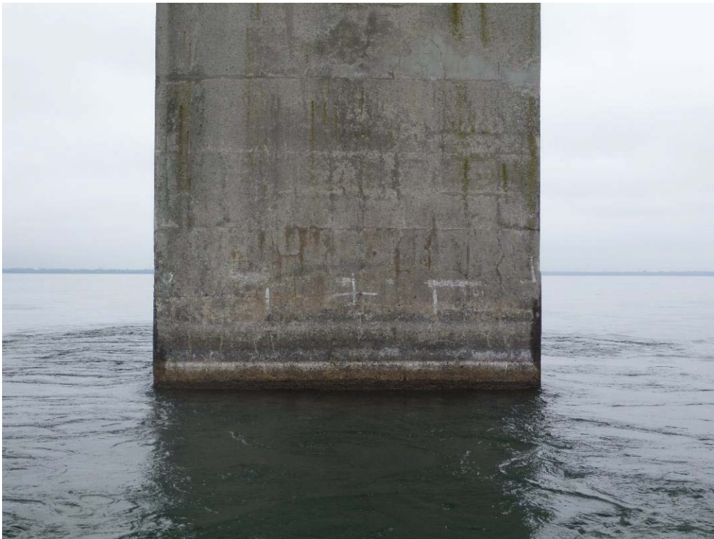
Figure 281 : Paroi droite / Pile 12 (ES12-PD)
