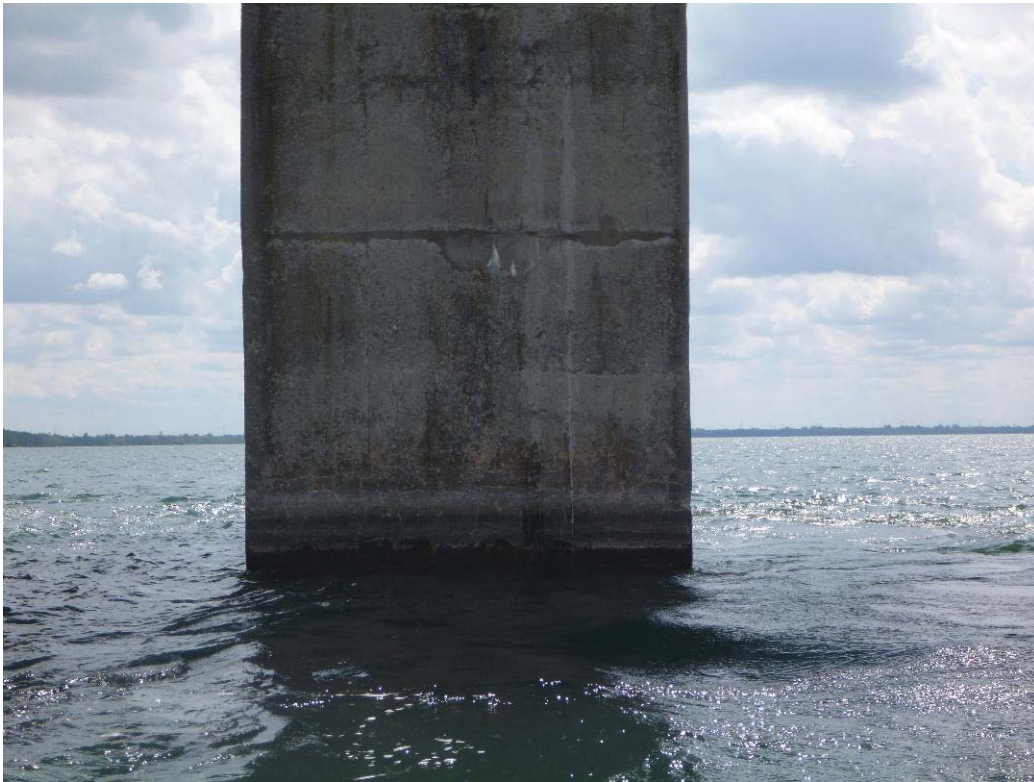
Figure 368 : Paroi aval / Pile 71 (ES71-AV)
