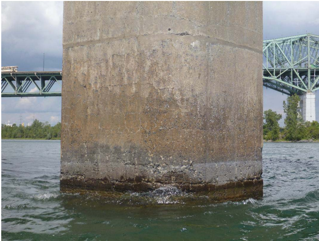
Figure 362 : Paroi amont / Pile 70 (ES70-AM)
