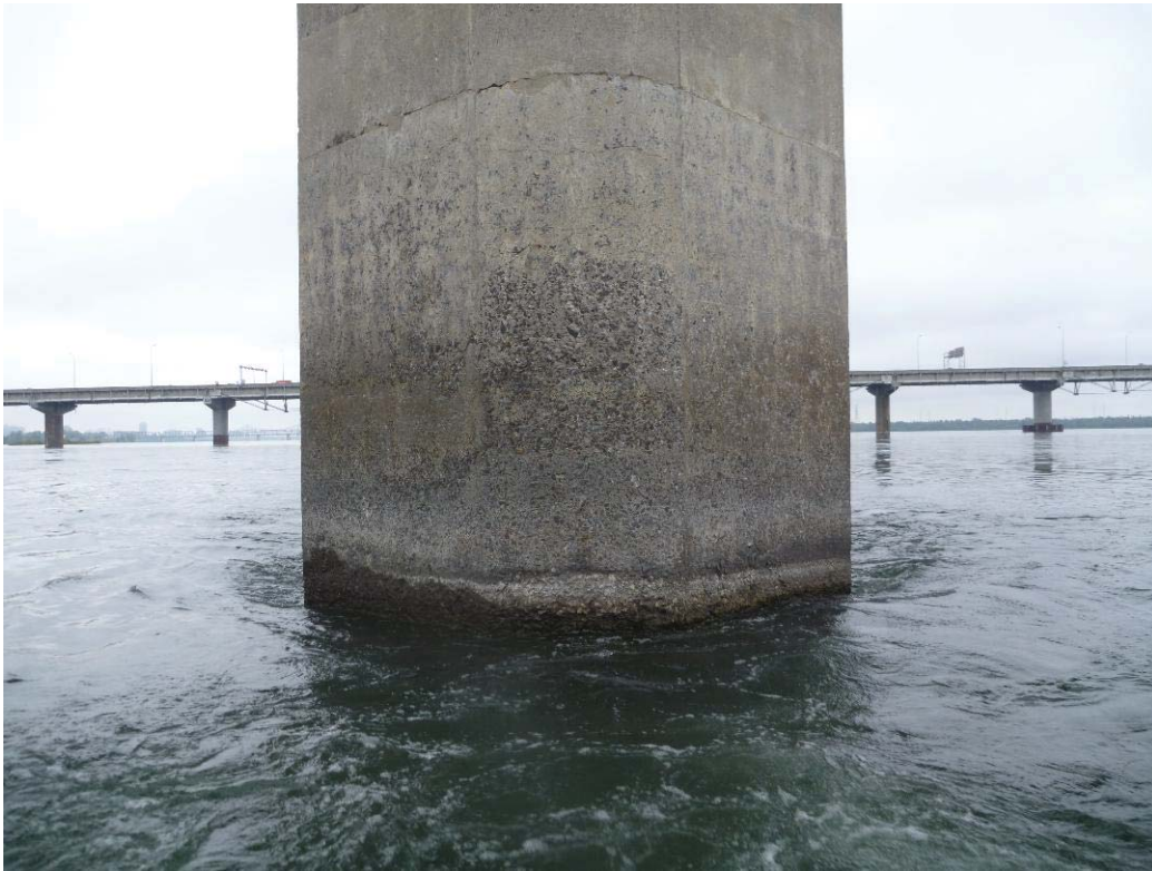
Figure 266 : Paroi amont / Pile 09 (ES09-AM)
