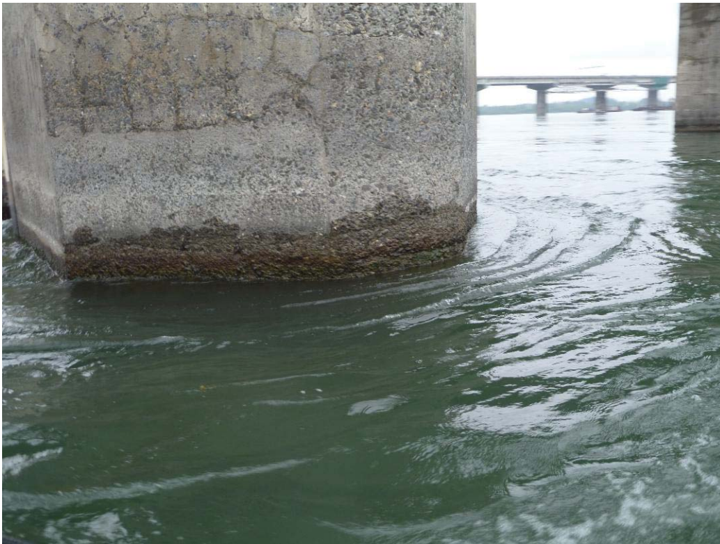
Figure 259 : Paroi gauche / Pile 07 (ES07-PG)
