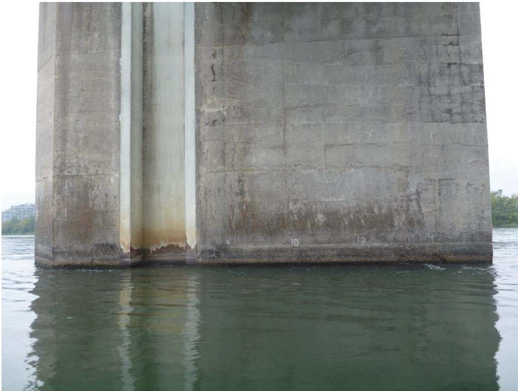
Figure 265 : Paroi droite / Pile 08 (ES08-PD)
