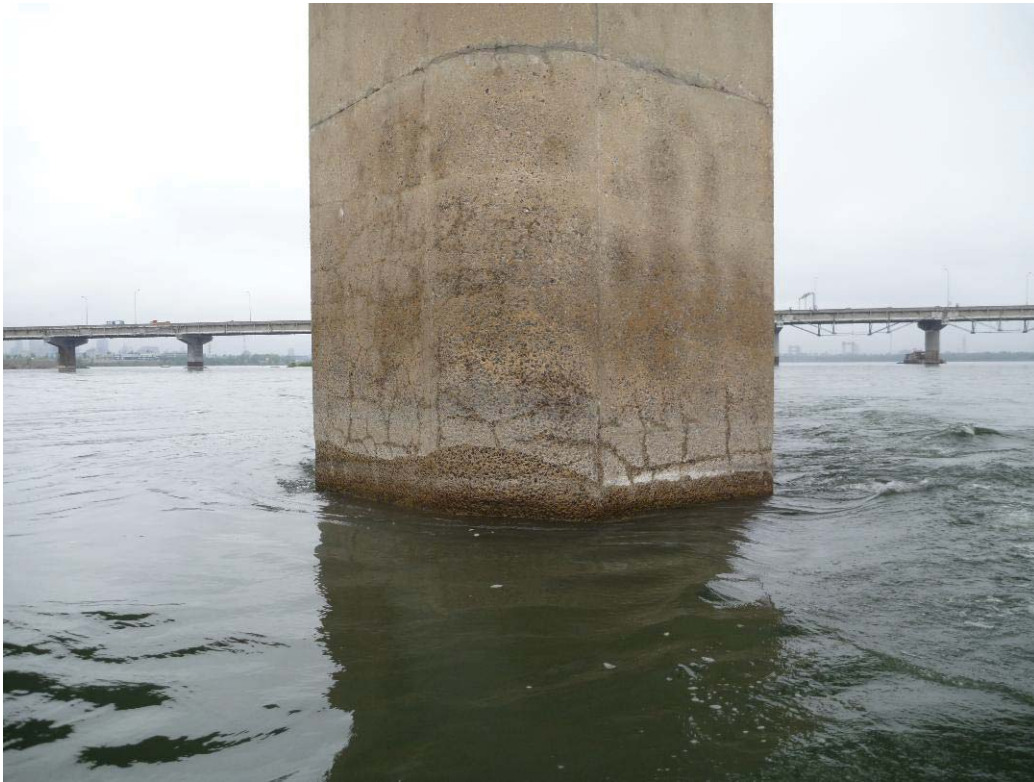
Figure 242 : Paroi amont / Pile 03 (ES03-AM)
