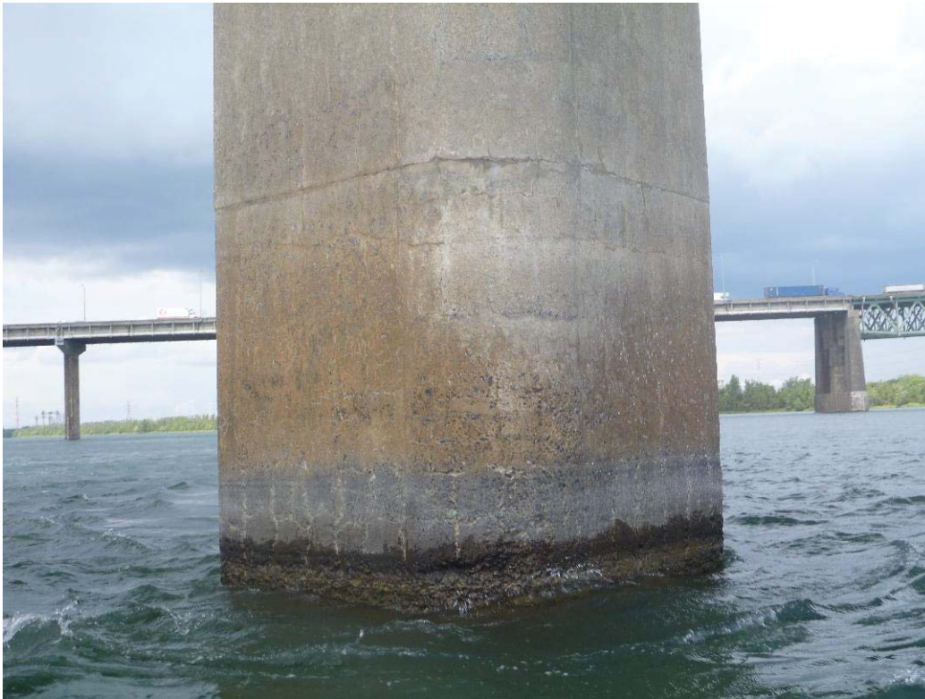
Figure 318 : Paroi amont / Pile 59 (ES59-AM)
