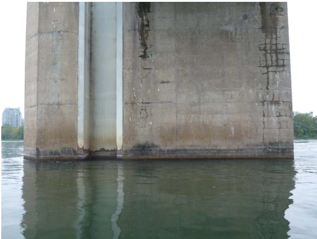
Figure 257 : Paroi droite / Pile 06 (ES06-PD)
