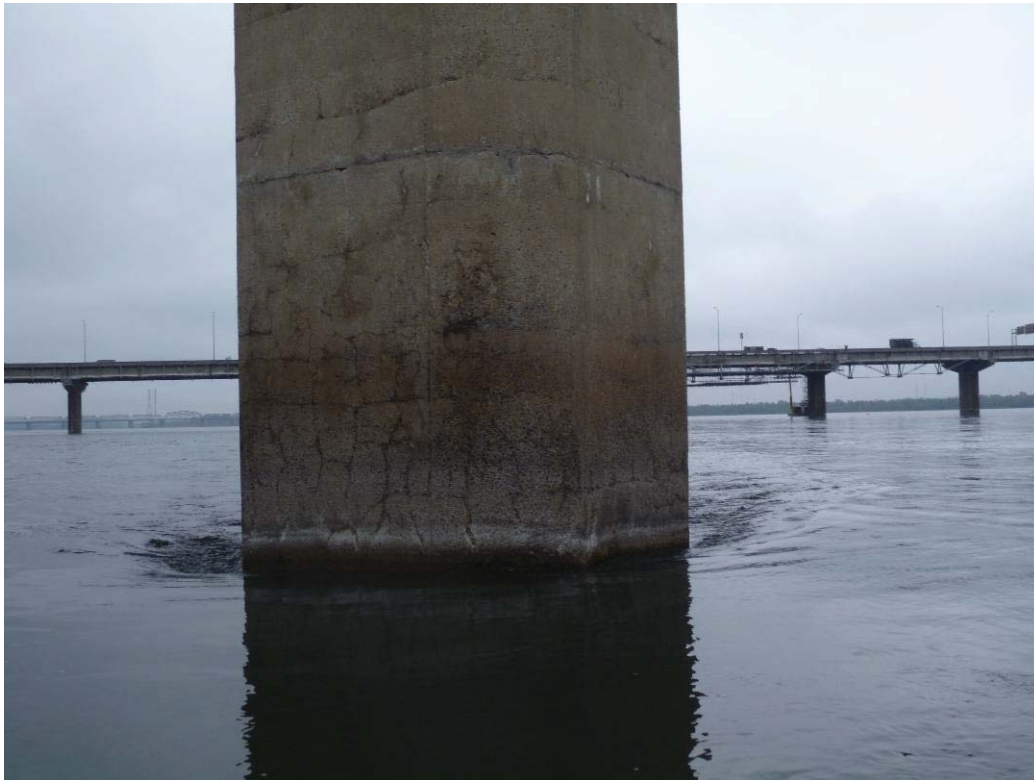
Figure 250 : Paroi amont / Pile 05 (ES05-AM)
