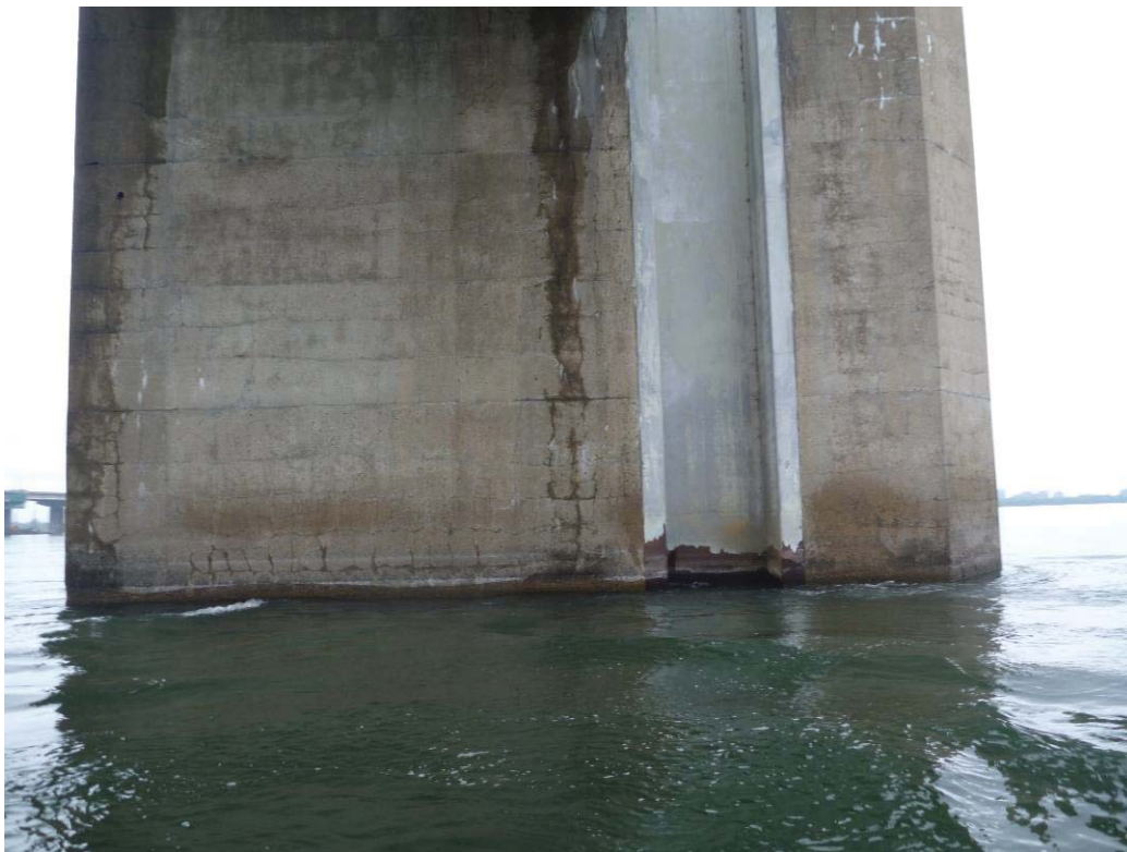
Figure 251 : Paroi gauche / Pile 05 (ES05-PG)
