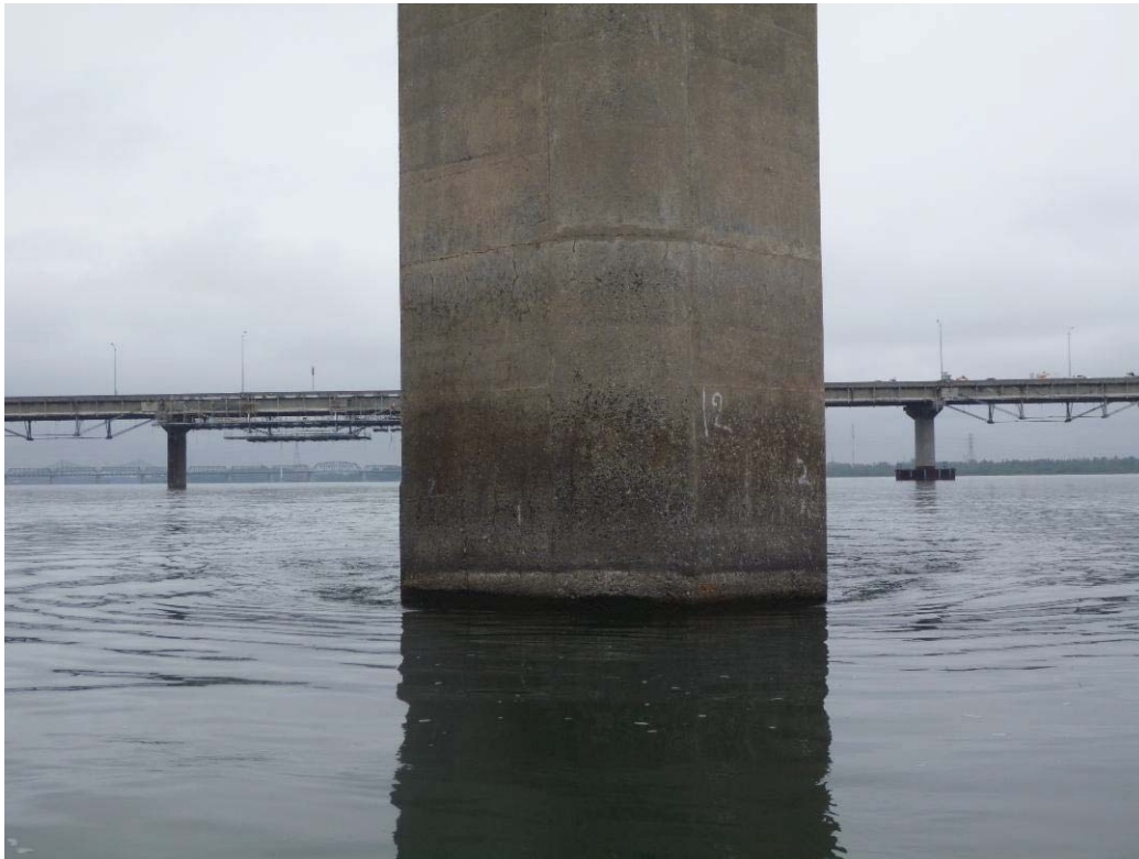
Figure 278 : Paroi amont / Pile 12 (ES12-AM)
