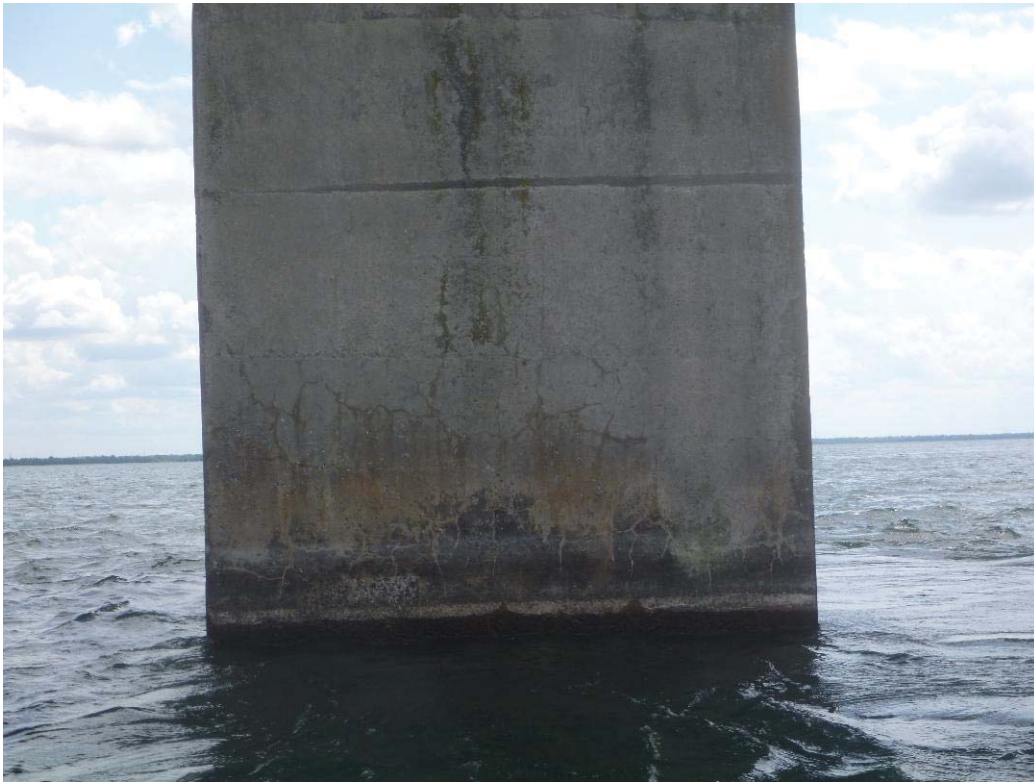
Figure 312 : Paroi aval / Pile 57 (ES57-AV)
