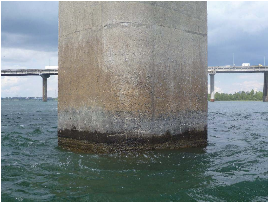
Figure 322 : Paroi amont / Pile 60 (ES60-AM)
