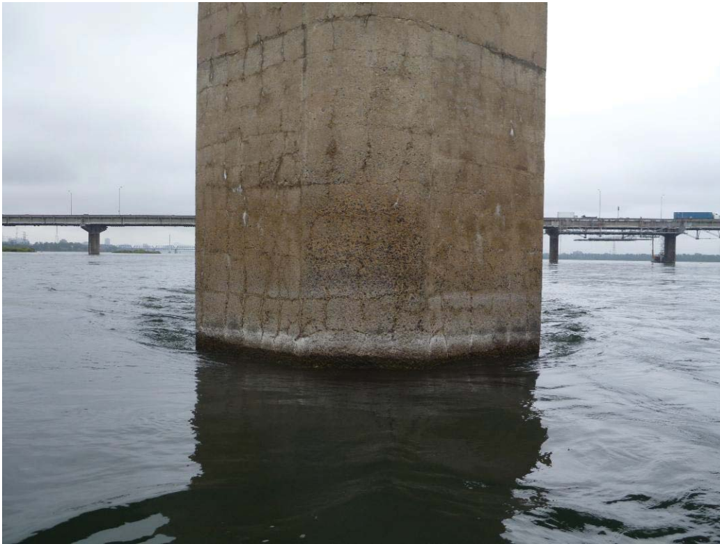
Figure 254 : Paroi amont / Pile 06 (ES06-AM)
