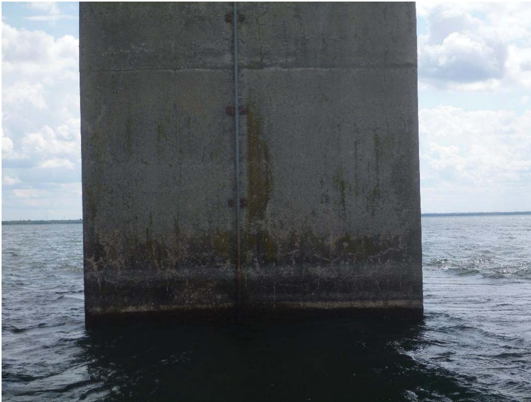
Figure 308 : Paroi aval / Pile 56 (ES56-AV)
