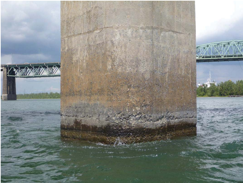
Figure 354 : Paroi amont / Pile 68 (ES68-AM)
