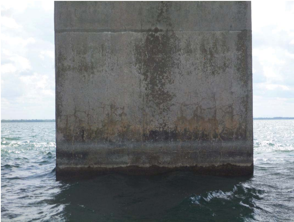
Figure 340 : Paroi aval / Pile 64 (ES64-AV)
