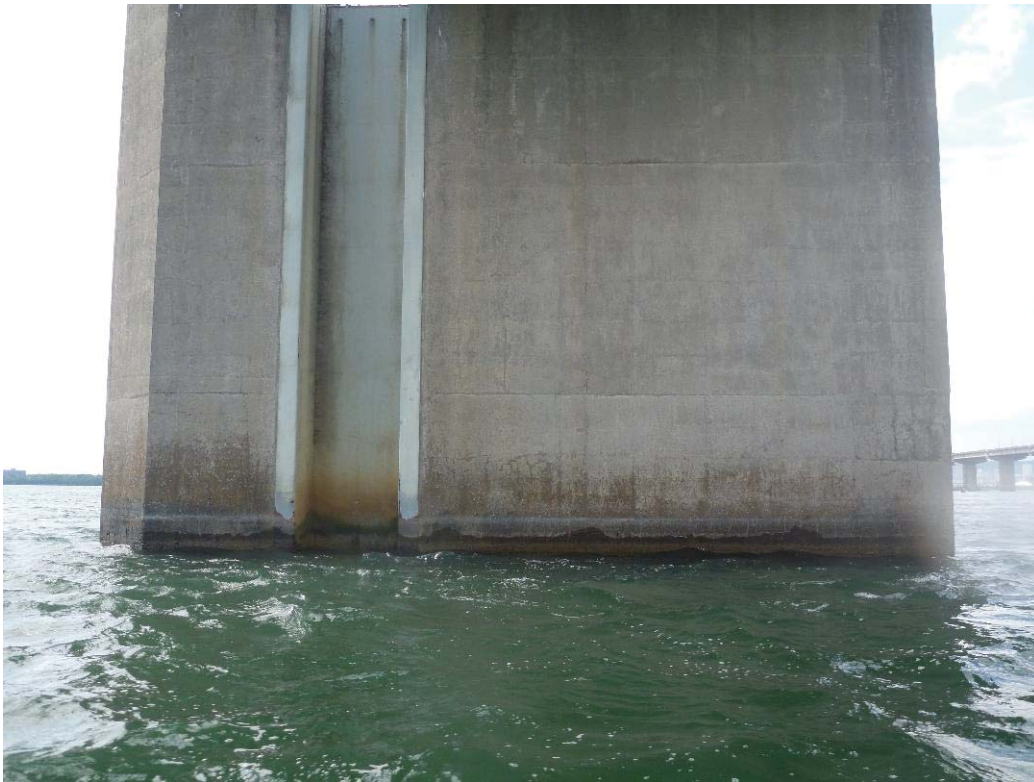
Figure 325 : Paroi droite / Pile 60 (ES60-PD)
