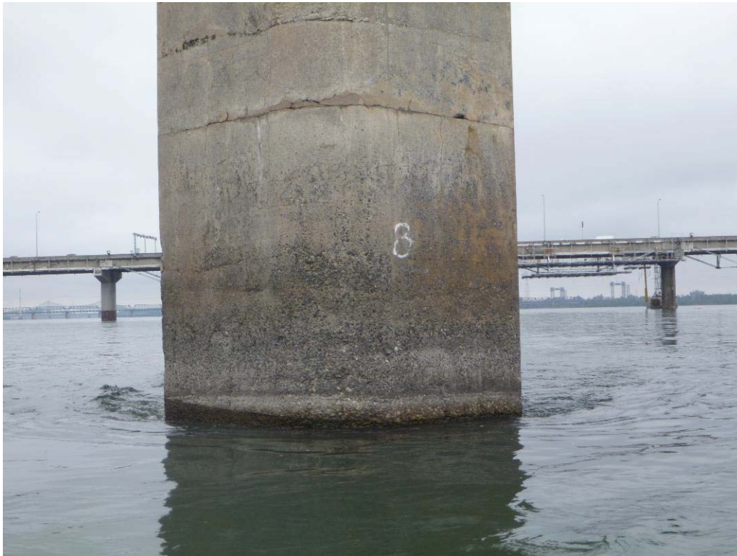
Figure 262 : Paroi amont / Pile 08 (ES08-AM)
