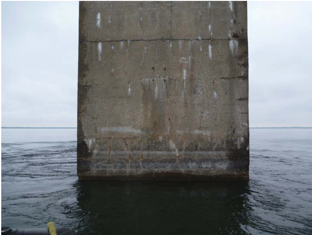
Figure 252 : Paroi aval / Pile 05 (ES05-AV)
