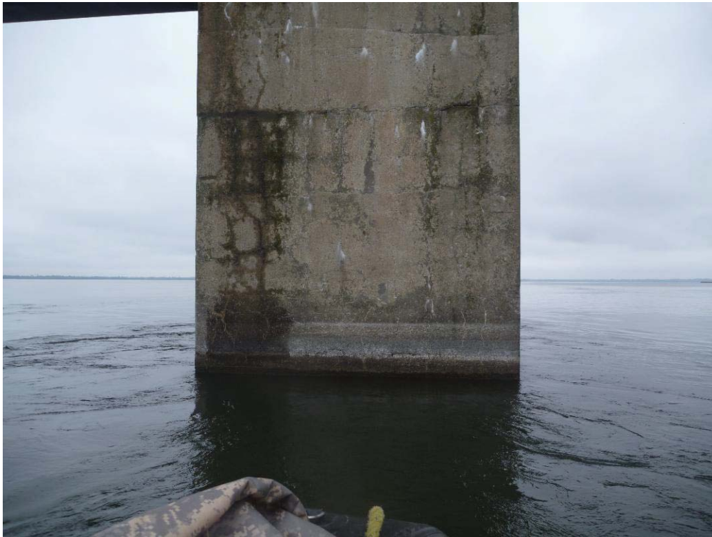
Figure 236 : Paroi aval / Pile 01 (ES01-AV)
