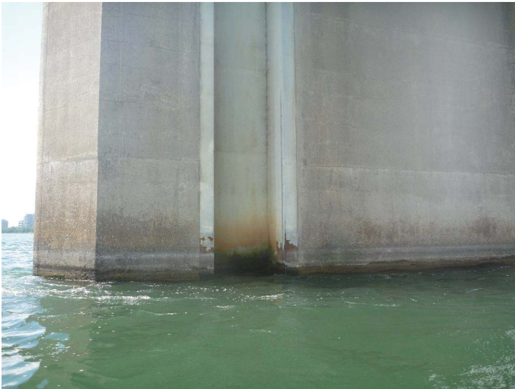
Figure 285 : Paroi droite / Pile 50 (ES50-PD)
