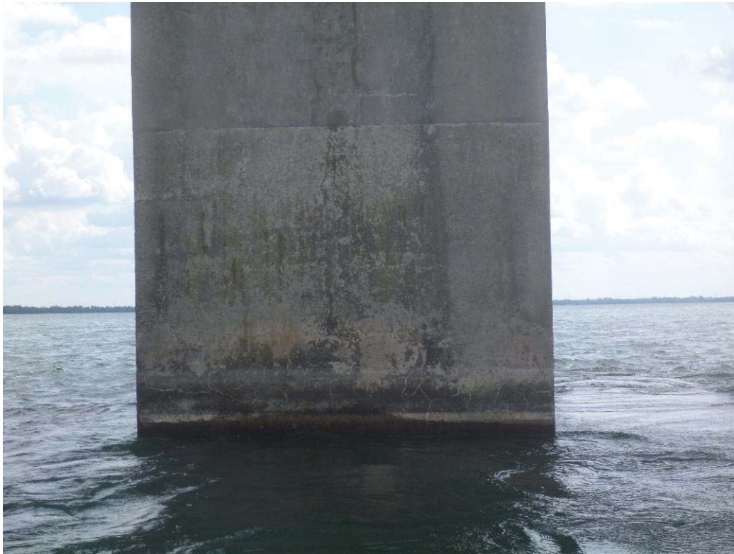
Figure 304 : Paroi aval / Pile 55 (ES55-AV)
