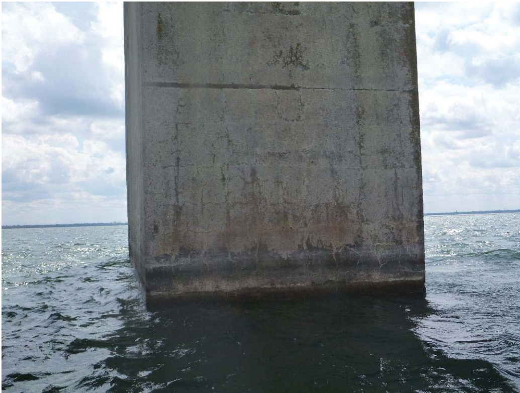
Figure 356 : Paroi aval / Pile 68 (ES68-AV)
