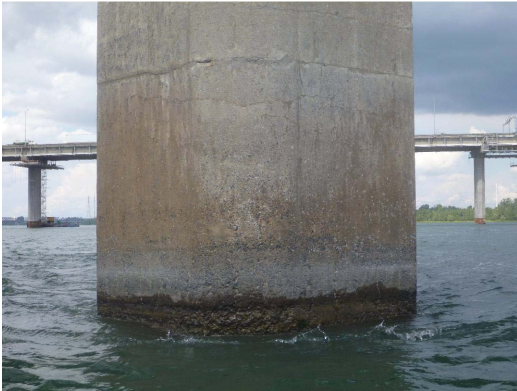
Figure 306 : Paroi amont / Pile 56 (ES56-AM)
