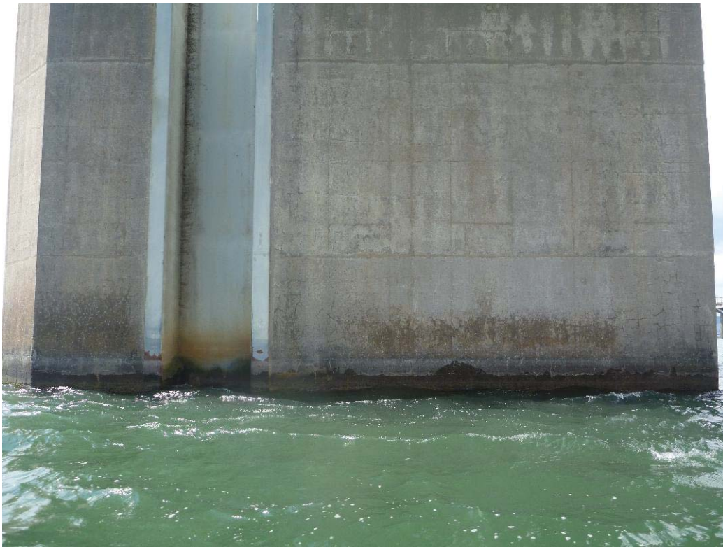
Figure 345 : Paroi droite / Pile 65 (ES65-PD)
