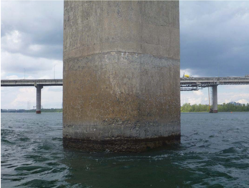
Figure 310 : Paroi amont / Pile 57 (ES57-AM)
