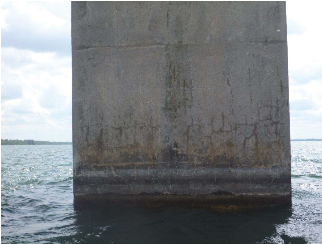
Figure 344 : Paroi aval / Pile 65 (ES65-AV)
