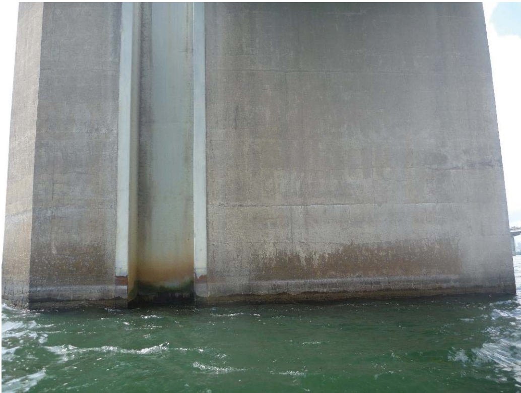
Figure 313 : Paroi droite / Pile 57 (ES57-PD)
