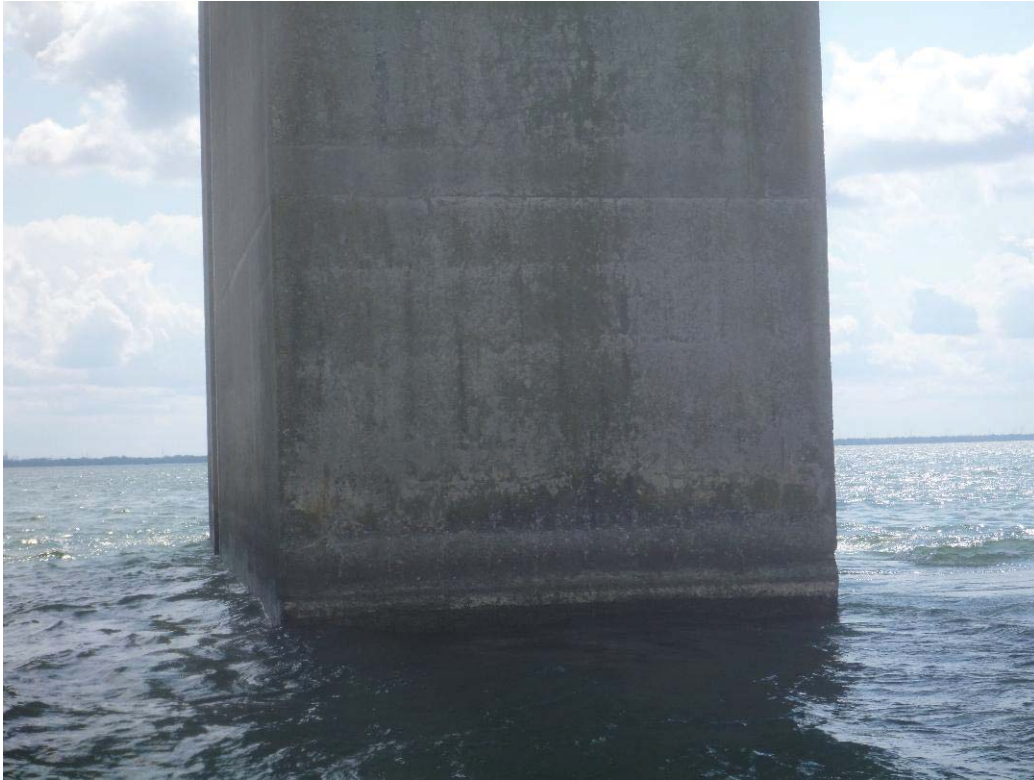
Figure 288 : Paroi aval / Pile 51 (ES51-AV)
