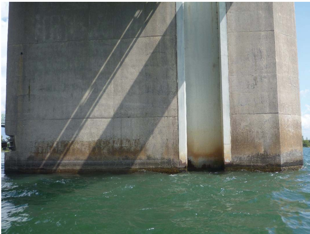
Figure 327 : Paroi gauche / Pile 61 (ES61-PG)
