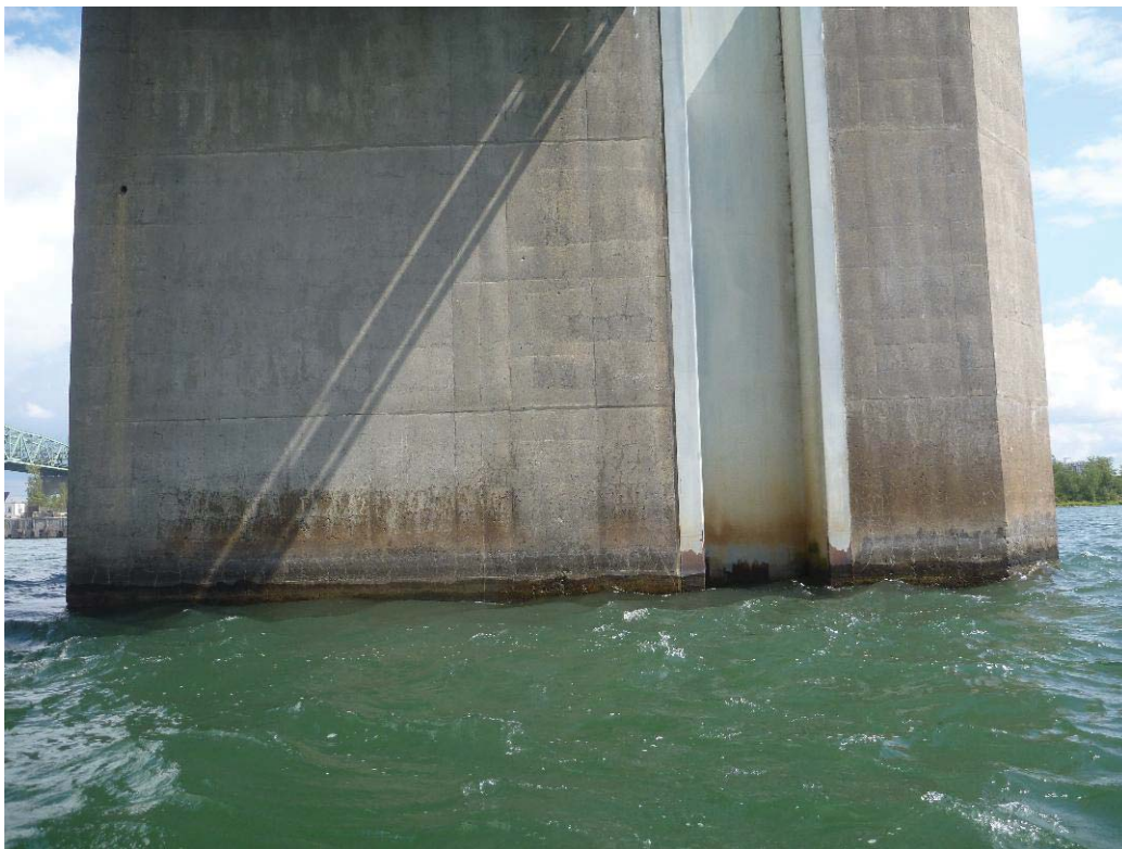
Figure 351 : Paroi gauche / Pile 67 (ES67-PG)
