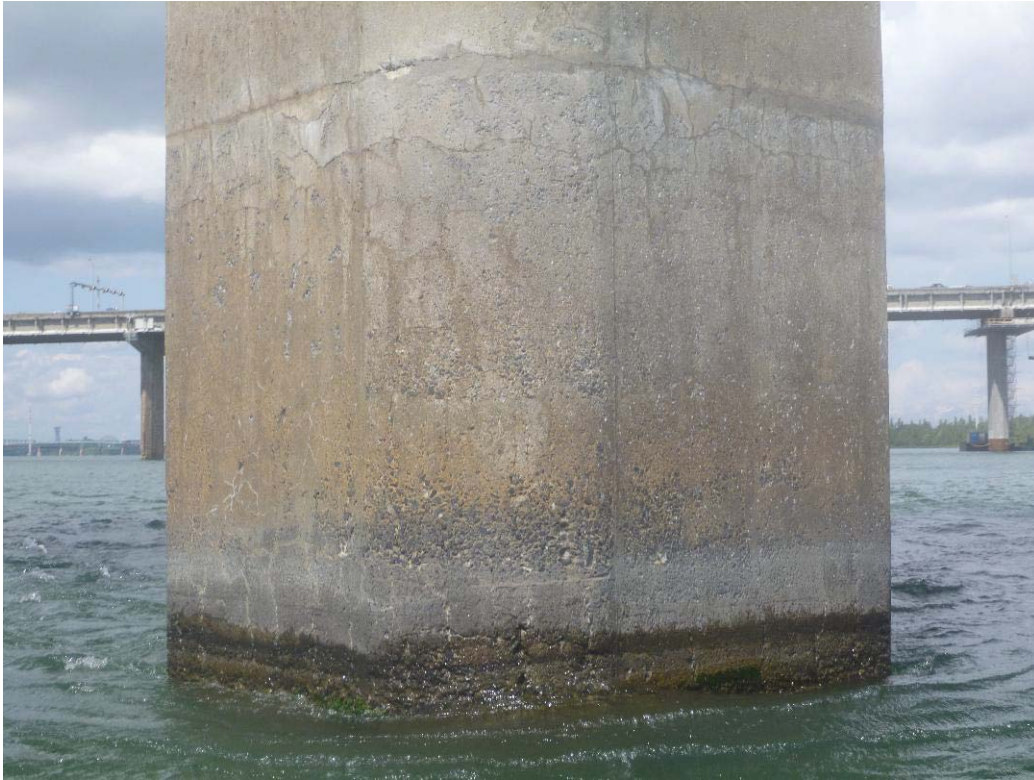
Figure 282 : Paroi amont / Pile 50 (ES50-AM)
