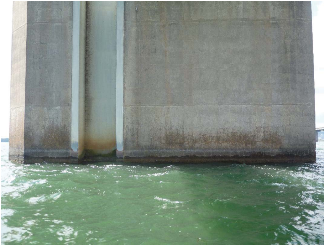
Figure 337 : Paroi droite / Pile 63 (ES63-PD)
