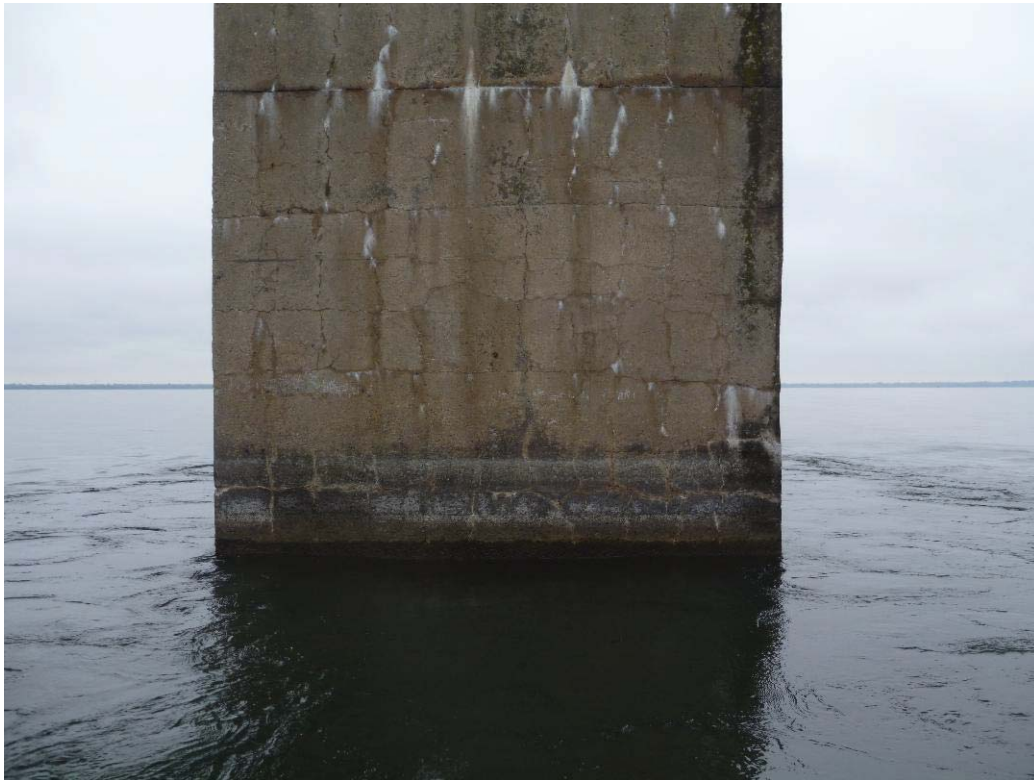
Figure 256 : Paroi aval / Pile 06 (ES06-AV)
