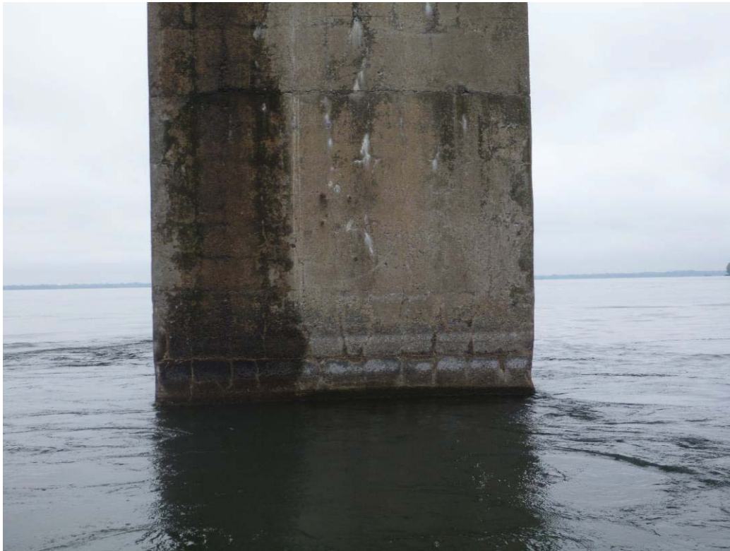
Figure 244 : Paroi aval / Pile 03 (ES03-AV)
