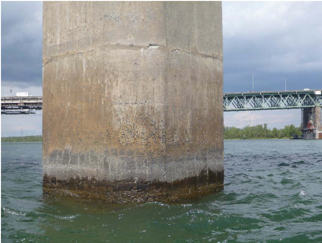
Figure 330 : Paroi amont / Pile 62 (ES62-AM)
