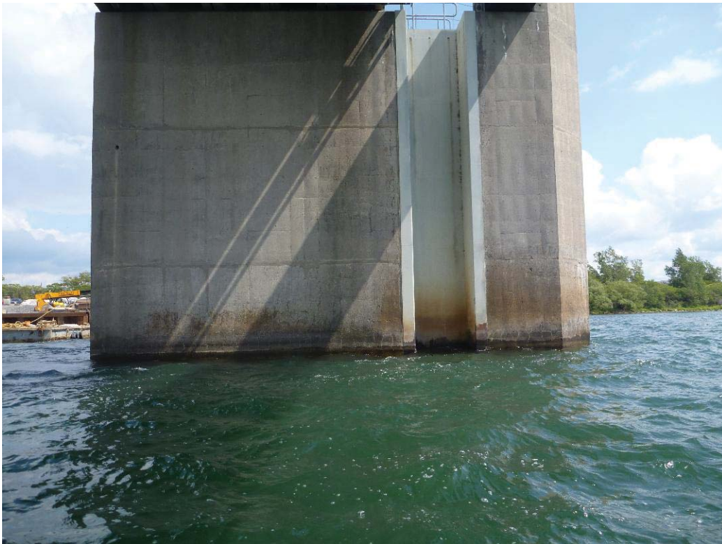
Figure 371 : Paroi gauche / Pile 72 (ES72-PG)
