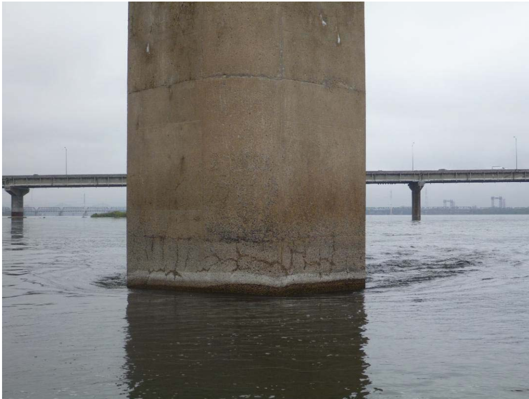
Figure 234 : Paroi amont / Pile 01 (ES01-AM)
