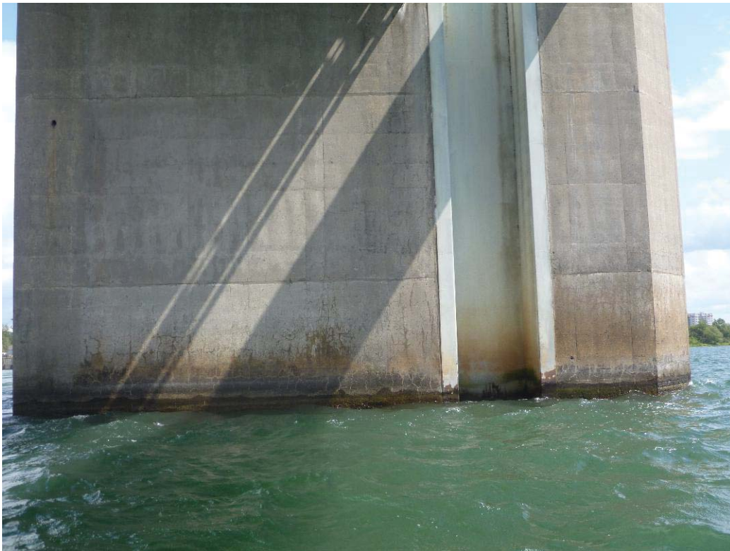
Figure 339 : Paroi gauche / Pile 64 (ES64-PG)
