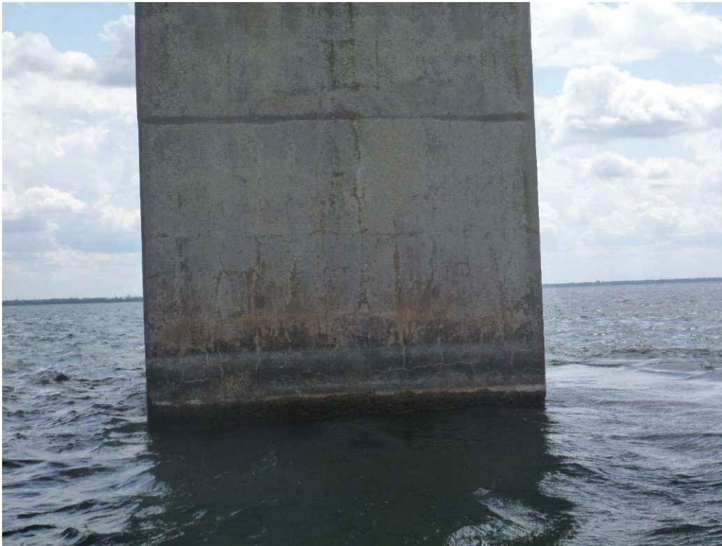
Figure 320 : Paroi aval / Pile 59 (ES59-AV)
