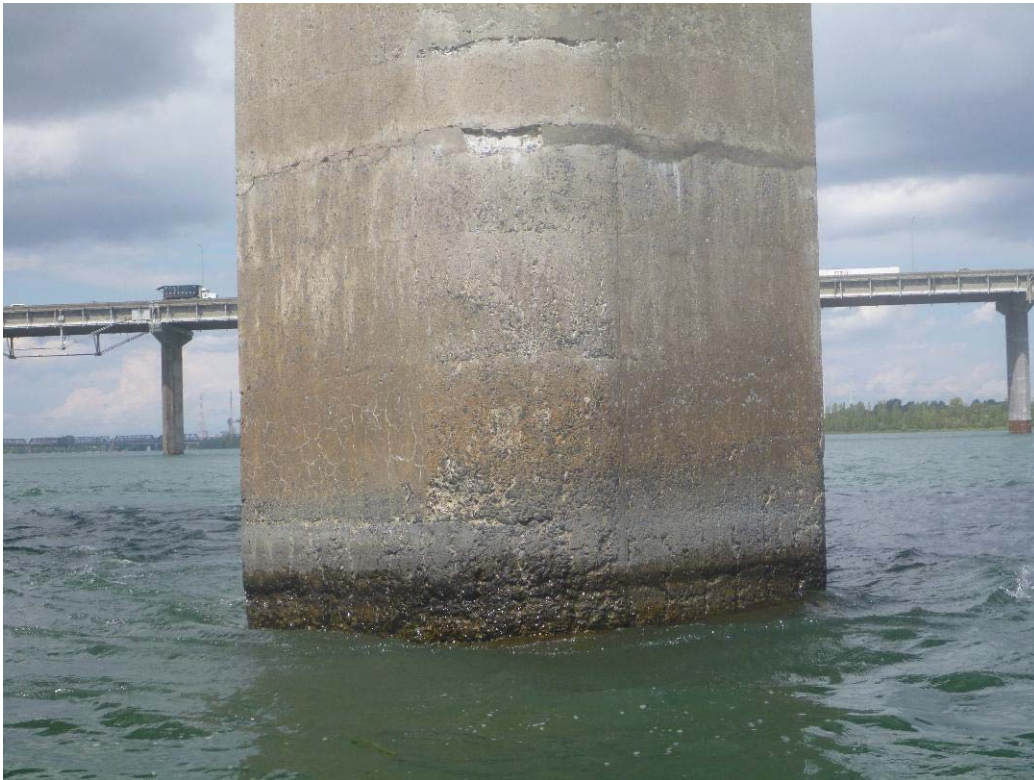
Figure 286 : Paroi amont / Pile 51 (ES51-AM)
