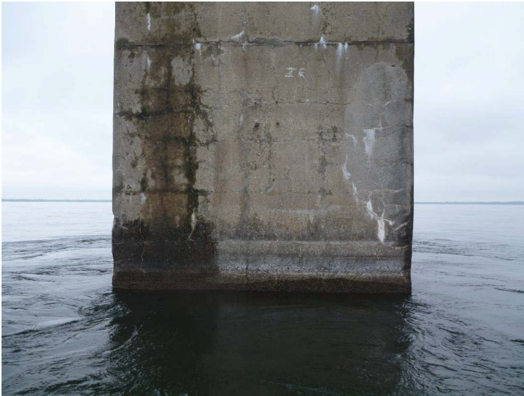
Figure 248 : Paroi aval / Pile 04 (ES04-AV)
