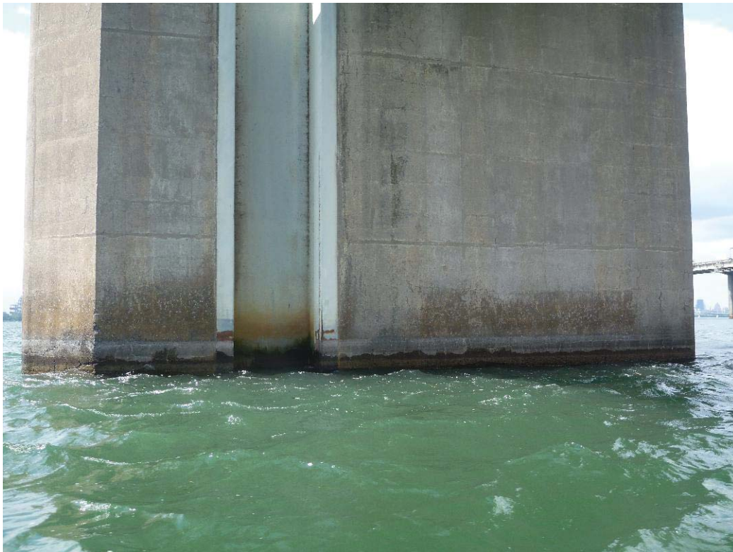
Figure 361 : Paroi droite / Pile 69 (ES69-PD)
