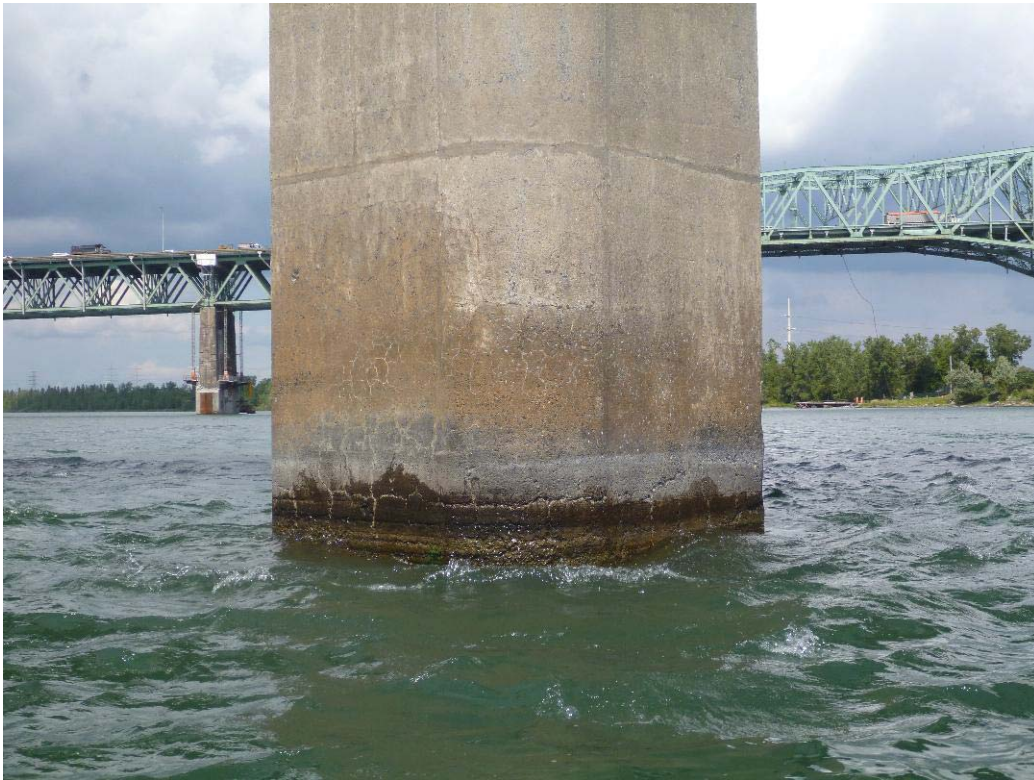
Figure 358 : Paroi amont / Pile 69 (ES69-AM)
