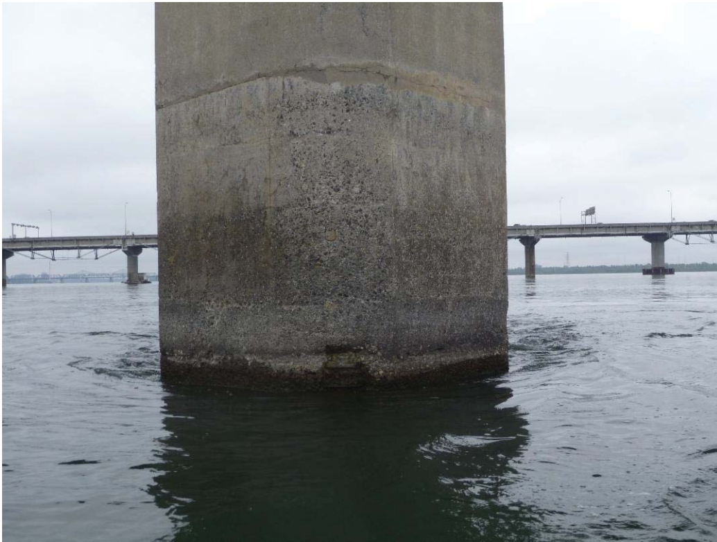
Figure 270 : Paroi amont / Pile 10 (ES10-AM)
