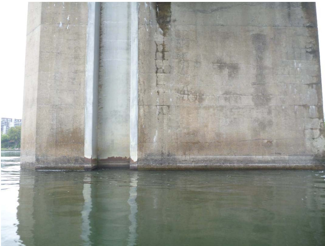
Figure 241 : Paroi droite / Pile 02 (ES02-PD)
