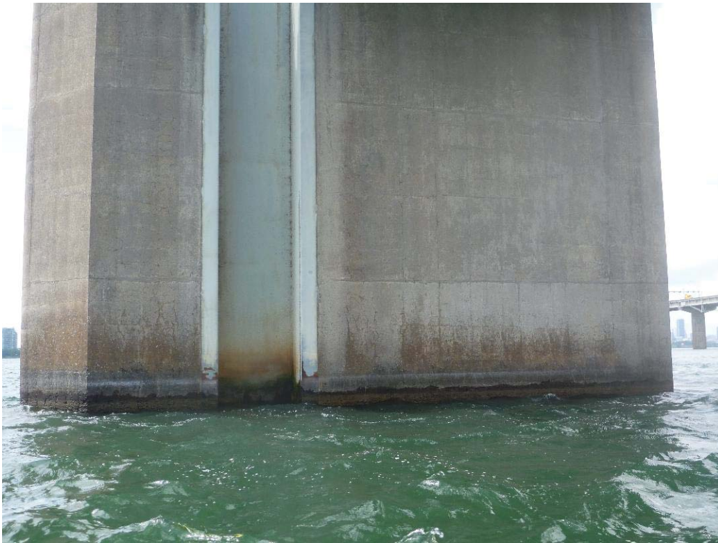
Figure 321 : Paroi droite / Pile 59 (ES59-PD)
