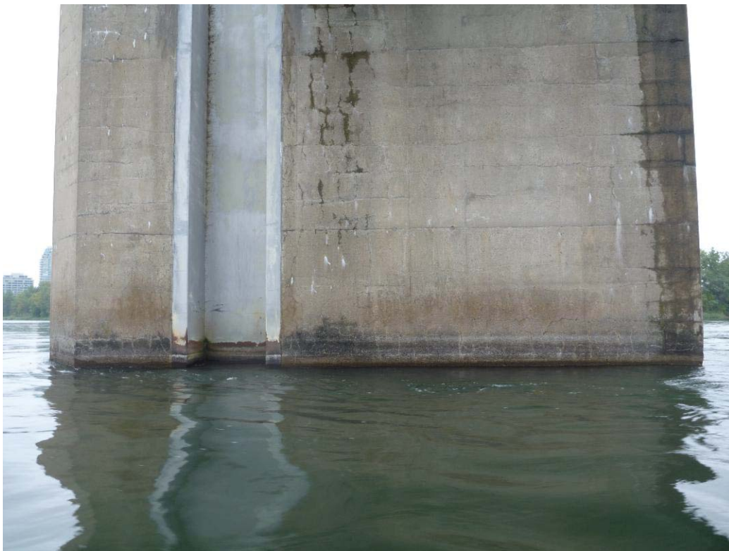
Figure 253 : Paroi droite / Pile 05 (ES05-PD)
