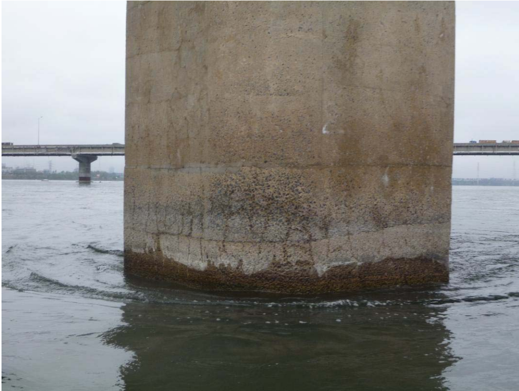
Figure 238 : Paroi amont / Pile 02 (ES02-AM)
