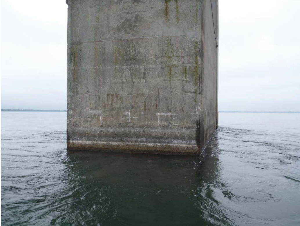
Figure 280 : Paroi aval / Pile 12 (ES12-AV)
