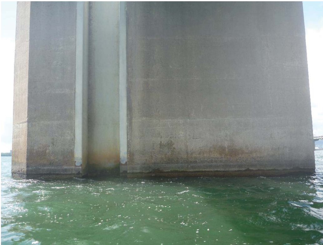
Figure 293 : Paroi droite / Pile 52 (ES52-PD)
