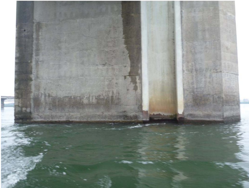
Figure 260 : Paroi aval / Pile 07 (ES07-AV)
