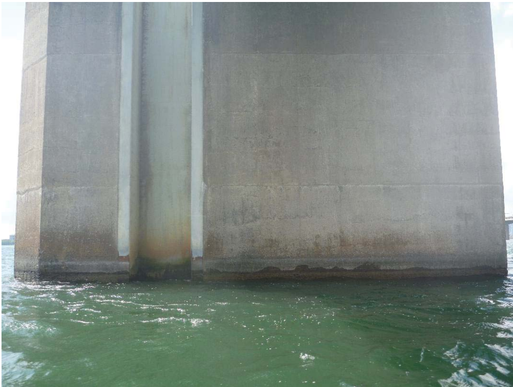
Figure 289 : Paroi droite / Pile 51 (ES51-PD)
