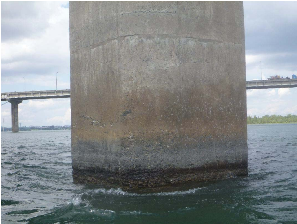
Figure 294 : Paroi amont / Pile 53 (ES53-AM)
