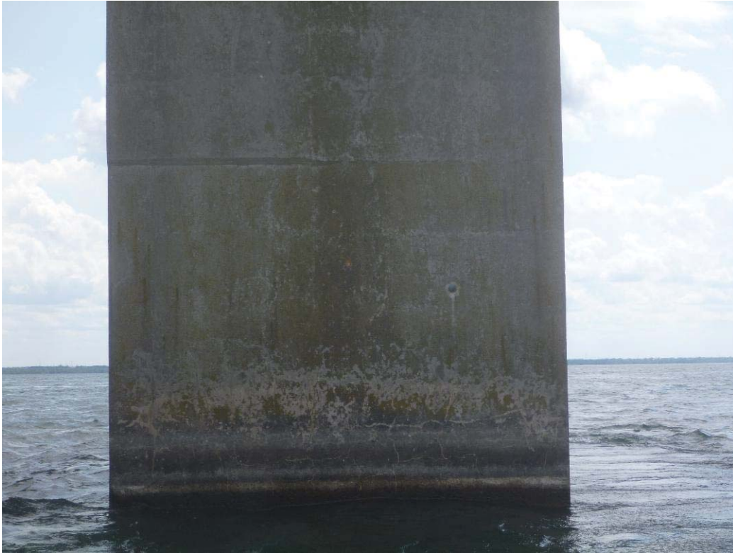
Figure 300 : Paroi aval / Pile 54 (ES54-AV)
