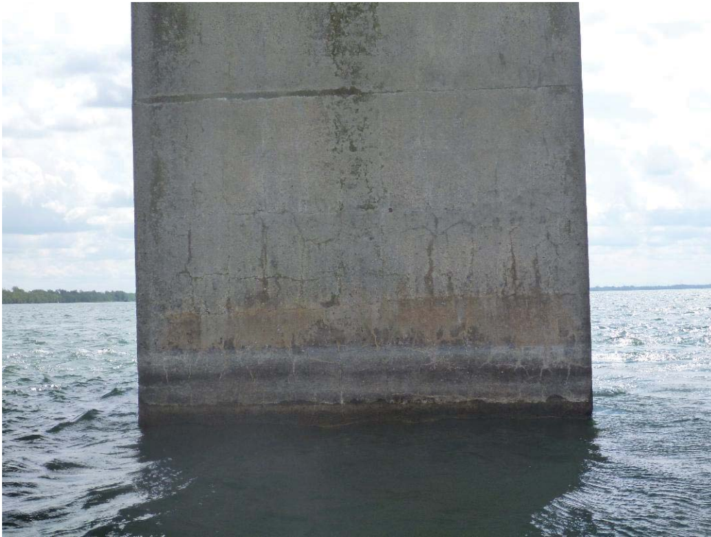
Figure 352 : Paroi aval / Pile 67 (ES67-AV)
