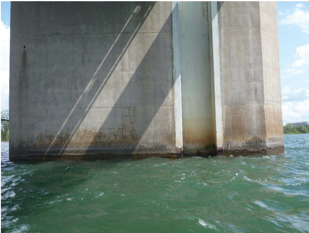
Figure 331 : Paroi gauche / Pile 62 (ES62-PG)
