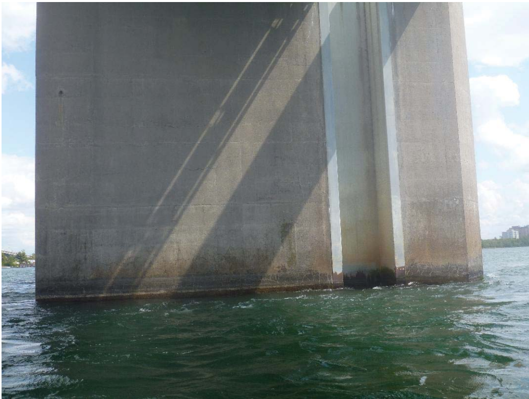
Figure 283 : Paroi gauche / Pile 50 (ES50-PG)
