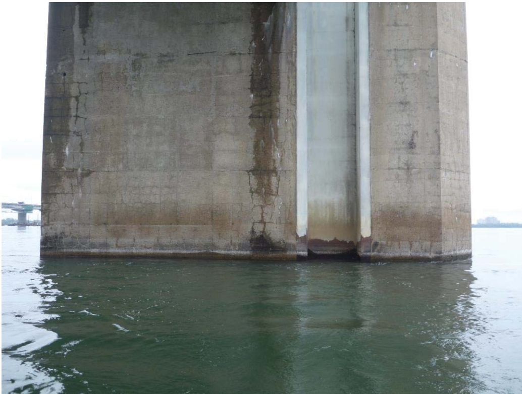
Figure 255 : Paroi gauche / Pile 06 (ES06-PG)
