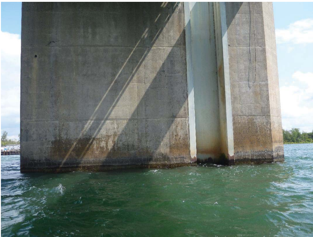
Figure 355 : Paroi gauche / Pile 68 (ES68-PG)
