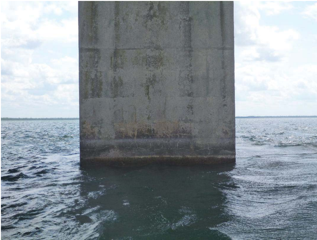
Figure 324 : Paroi aval / Pile 60 (ES60-AV)
