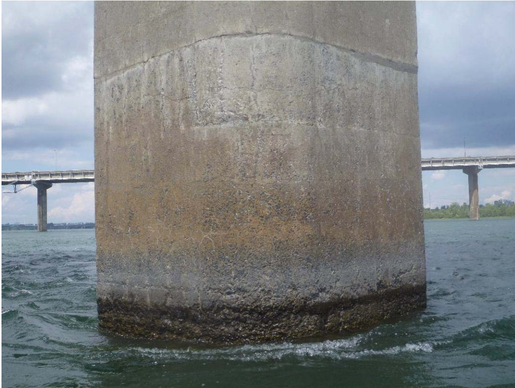
Figure 290 : Paroi amont / Pile 52 (ES52-AM)
