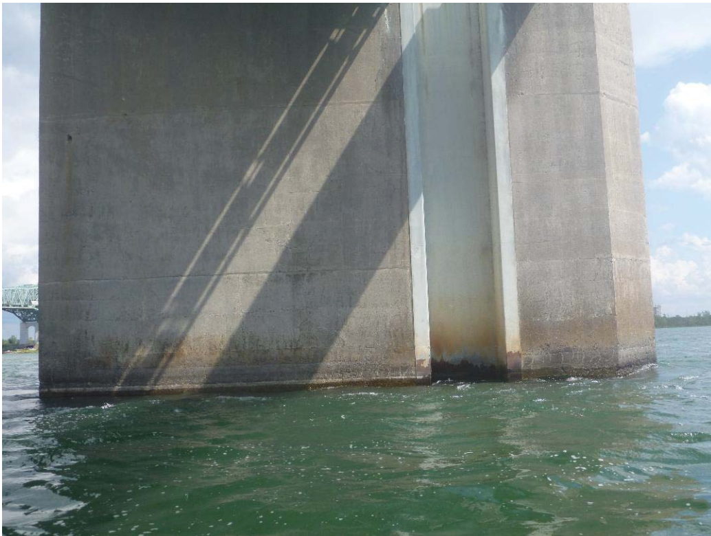
Figure 287 : Paroi gauche / Pile 51 (ES51-PG)
