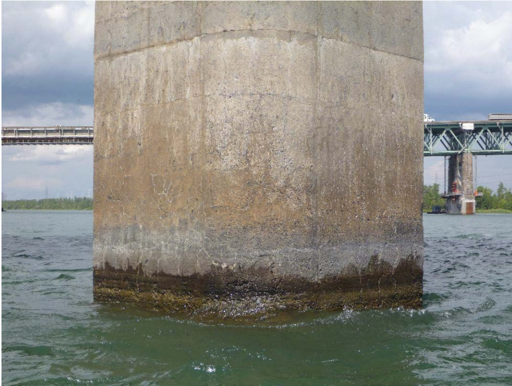
Figure 338 : Paroi amont / Pile 64 (ES64-AM)
