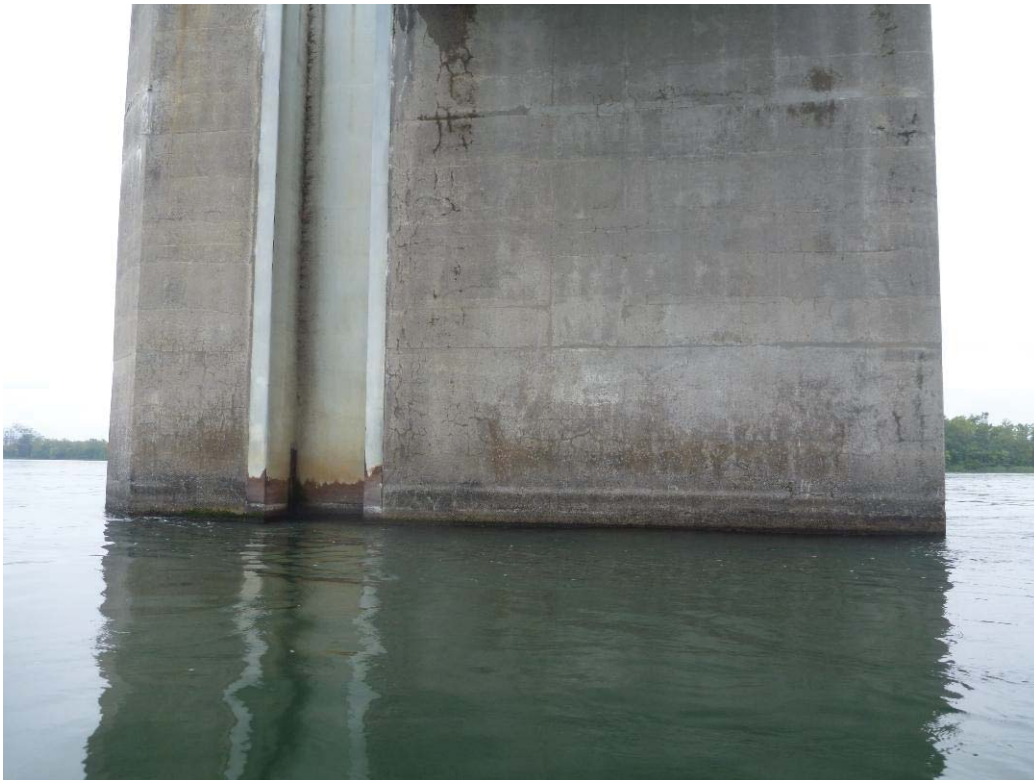
Figure 277 : Paroi droite / Pile 11 (ES11-PD)
