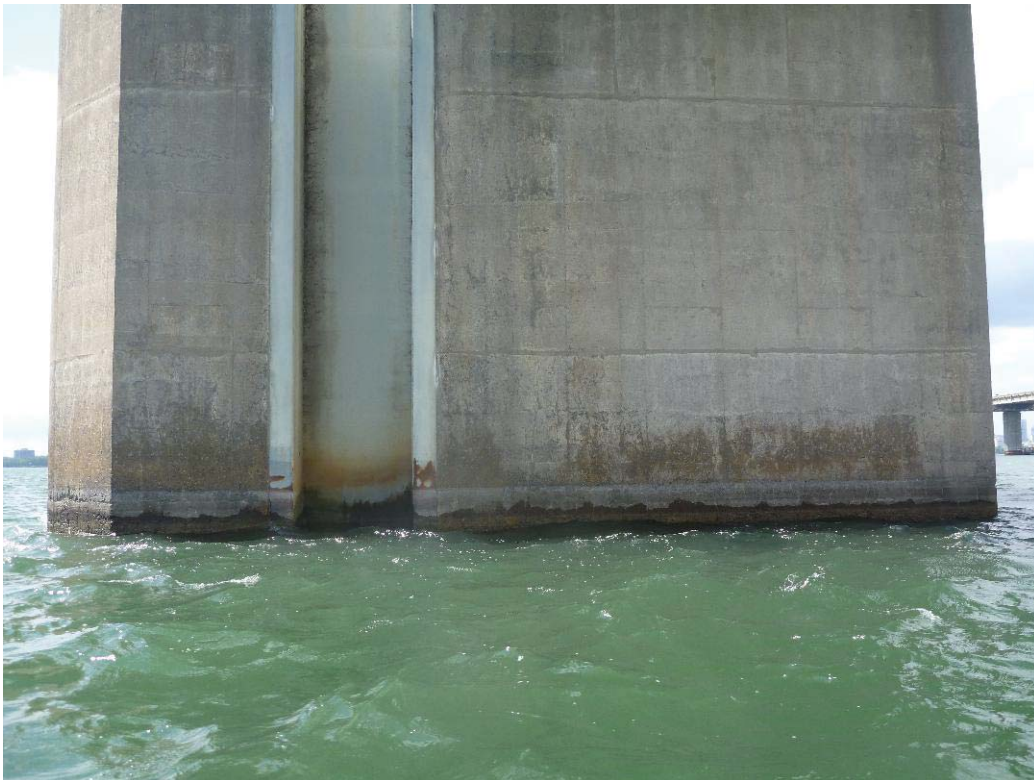
Figure 357 : Paroi droite / Pile 68 (ES68-PD)
