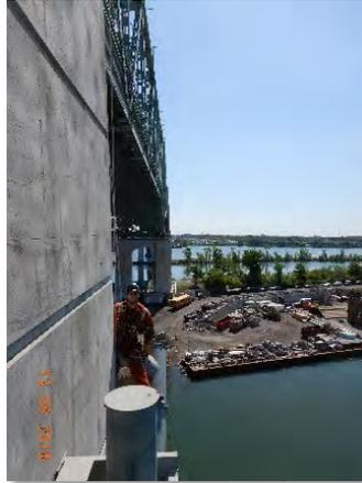
Figure 2 : Exemple d'inspection détaillée des unités de fondation par accès sur corde
