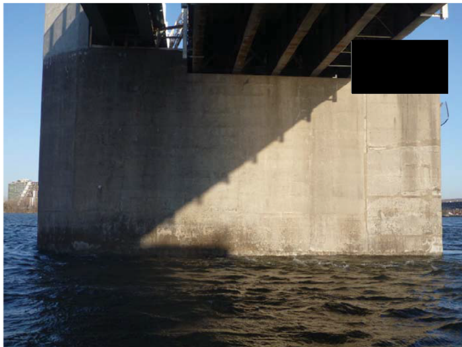
Figure 29 : Paroi droite / Pile 19 (ES19-PD)
