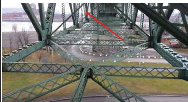
Photo 1: Vue générale JC_6_20151211_471
