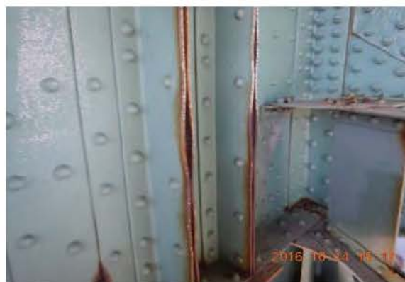
Photo 2: Poutre levage L10
