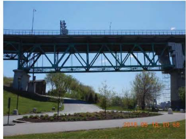
Photo 3 – Vue générale de la travée 20-21
