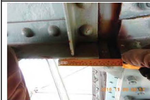
Photo 5: Face amont - extérieur JC_6_20161109_EM_9520
