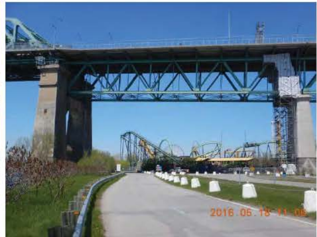
Photo 5 – Vue générale de la travée 22-23
