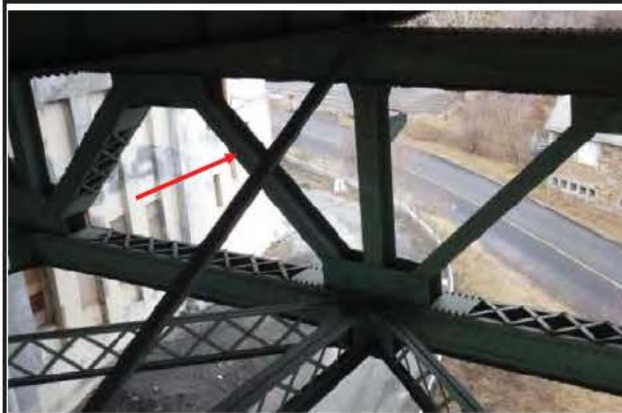
Photo 1: Vue générale JC_6_20151211_413
