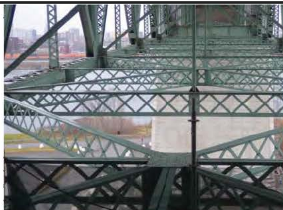
Photo 1: Vue générale JC_6_20151211_398
