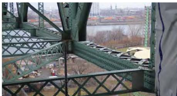
Photo 1: Vue générale JC_6_20151211_388
