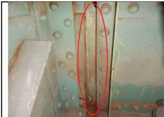
Photo 3: Face aval - extérieur JC_6_20161109_EM_9532
