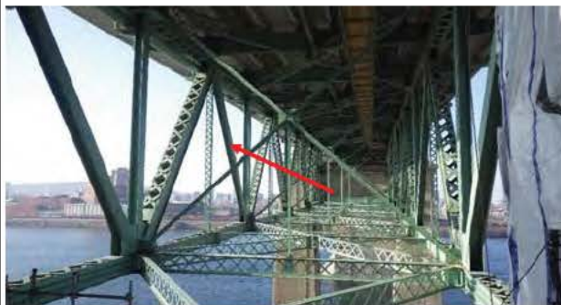
Photo 1: Vue générale JC_6_20151211_492
