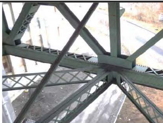
Photo 1: Vue générale JC_6_20151211_418
