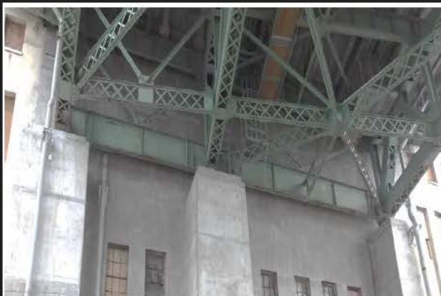
Photo 1: Vue générale JC_6_20151210_3639
