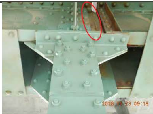
Photo 1: Face aval - vue générale JC_6_161123_MB_1892
