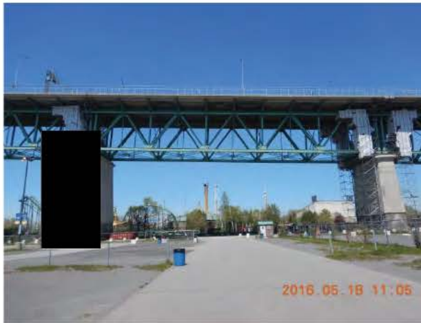
Photo 4 – Vue générale de la travée 21-22
