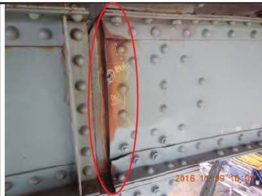
Photo 4: Face amont - extérieur JC_6_20161109_EM_9521
