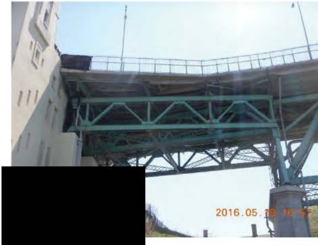
Photo 2 – Vue générale de la travée 19B-20
