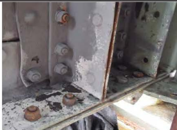
Photo 1: Poutre levage 1 JC_6_20151211_370
