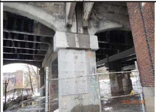
Photo 2: Vue générale de la face aval
