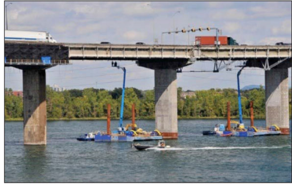
Figure 2 : Exemple d'inspection détaillée, exécutée à l'aide de nacelles élévatrices placées sur barges flottantes
