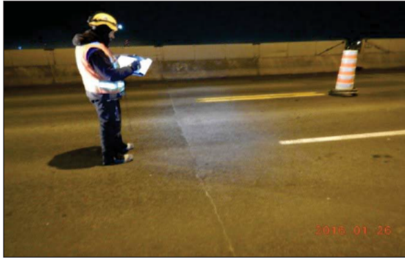
Figure 1 : Exemple d'inspection détaillée sur le tablier, exécutée à pied à partir de la surface de roulement du tablier
