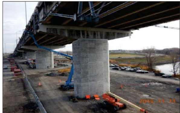
Figure 4 : Exemple d'inspection détaillée, exécutée à l'aide d'une nacelle élévatrice à partir de la terre ferme
