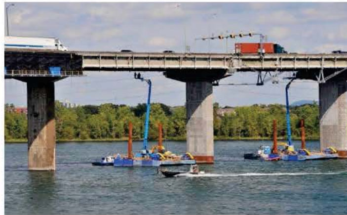
Figure 2 : Exemple d'inspection détaillée, exécutée à l'aide de nacelles élévatrices placées sur barges flottantes
