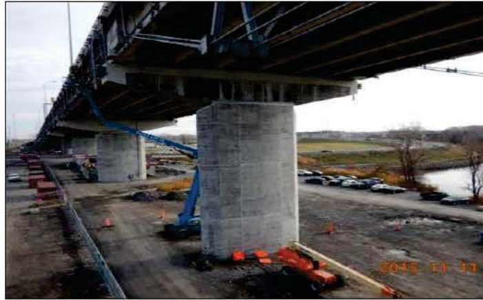
Figure 4 : Exemple d'inspection détaillée, exécutée à l'aide d'une nacelle élévatrice à partir de la terre ferme
