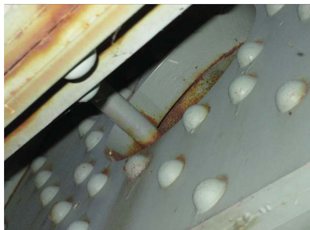
Tourillon 12T Ferme Amont – Tige filetée Côté Montréal (Joint 0.5W)
