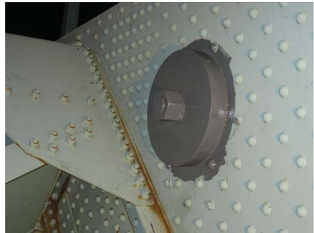
Tourillon 12D Ferme Centrale Côté Brossard (Joint 0.5E) après peinture
