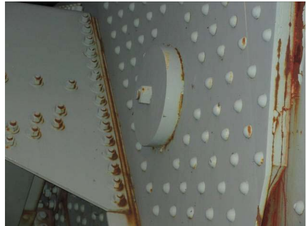
Tourillon 12K Ferme Aval Côté Brossard (Joint 0.5E)
