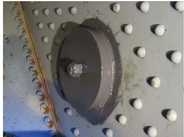
Tourillon 12K Ferme Aval Côté Brossard (Joint 0.5E) - après peinture
