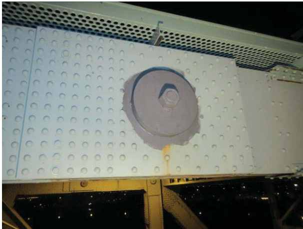
Tourillon 12N Ferme Centrale – Tige filetée Côté Brossard (Joint 0.5E) - après peinture
