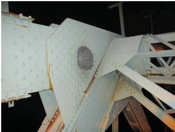
Tourillon 12K Ferme Amont Côté Brossard (Joint 0.5E)- après peinture
