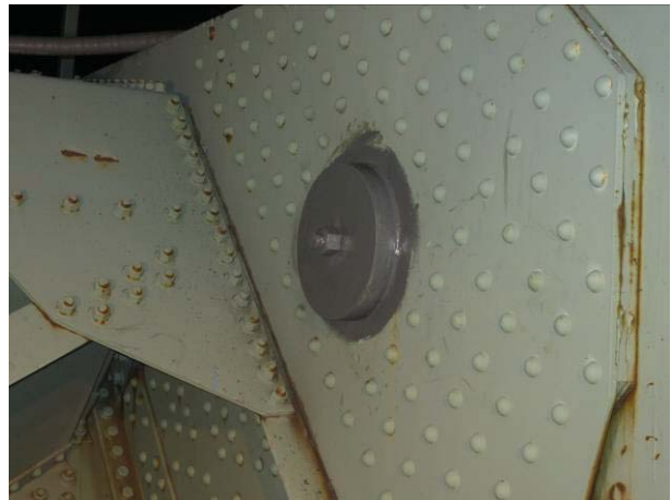
Tourillon 12K Ferme Amont Côté Montréal (Joint 0.5W) - après peinture
