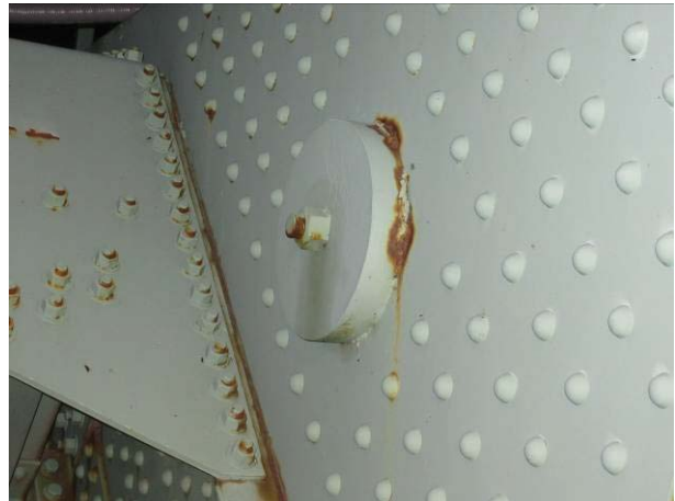
Tourillon 12K Ferme Amont Côté Montréal (Joint 0.5W)
