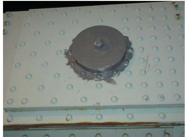
Tourillon 12T Ferme Amont – Tige filetée Côté Brossard (Joint 0.5E) - après peinture
