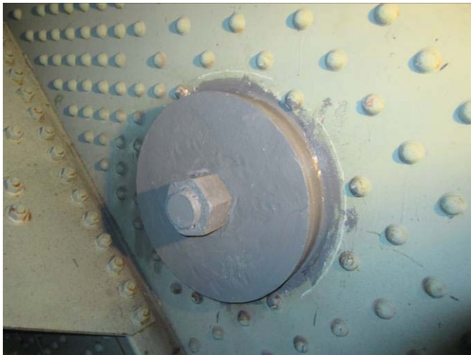
Tourillon 12D Ferme Centrale Côté Brossard (Joint 0.5W) après peinture
