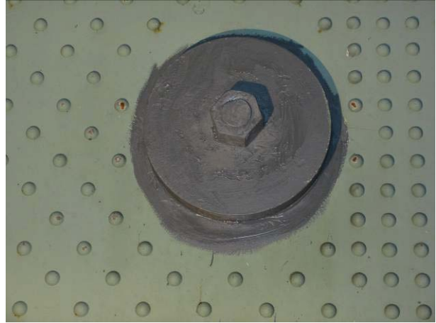
Tourillon 12N Ferme Centrale – Tige filetée Côté Montréal (Joint 0.5W) - après peinture
