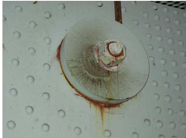
Tourillon 12N Ferme Centrale – Tige filetée Côté Brossard (Joint 0.5E)
