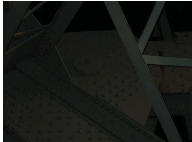
Tourillon 12D Ferme Centrale Côté Brossard (Joint 0.5E)
