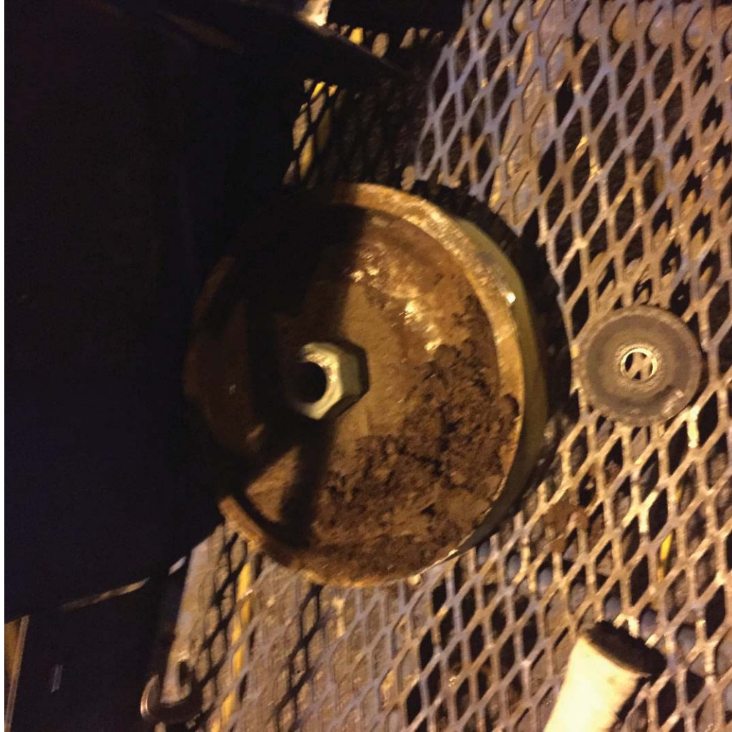
Photo 4 : Capuchon démonté typique avec graisse séchée (avant nettoyage)
