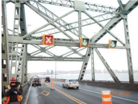
Figure 1 : Exemple d'inspection générale, exécutée à pied à partir de la surface de roulement du tablier
