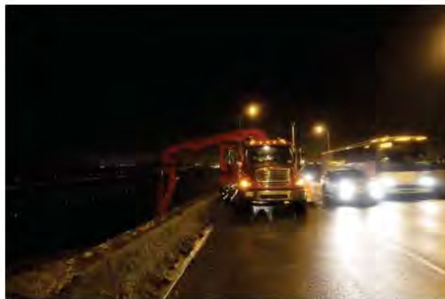
Figure 2 : Exemple d'inspection détaillée, exécutée à l'aide d'équipement de levage
