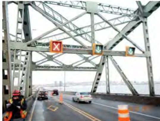
Figure 1 : Exemple d'inspection générale, exécutée à pied à partir de la surface de roulement du tablier
