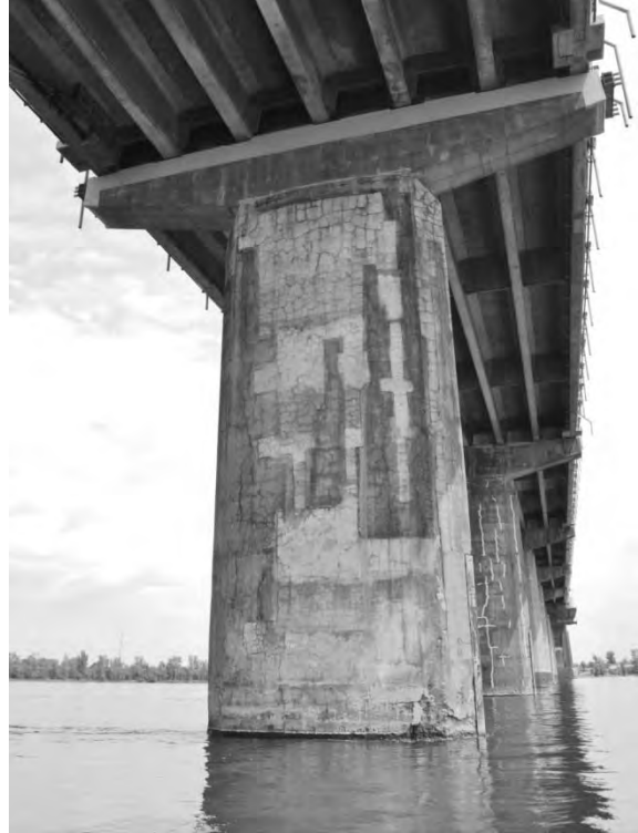
S5.PC.2.3.b – 5005 - Pile 12W (face ouest)
