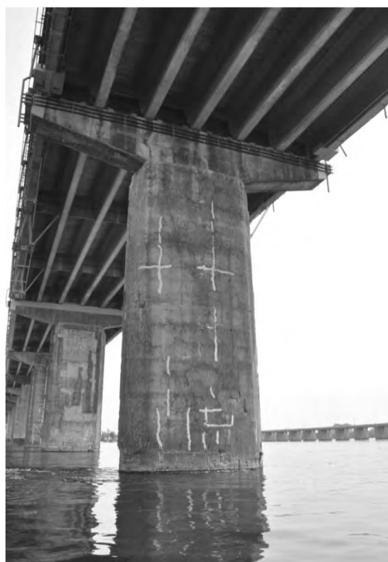
S5.PC.2.2.b – 4994 - Pile 13W (face ouest)
