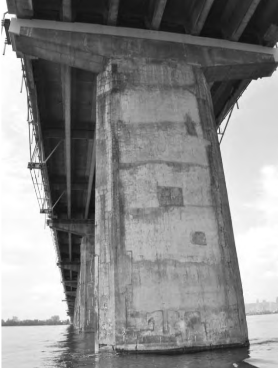
S5.PC.2.3.a – 5010 - Pile 12W (face est)
