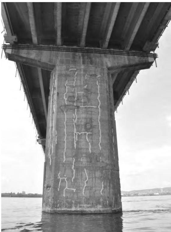
S5.PC.2.1.a – 4993 - Pile 14W (face est)
