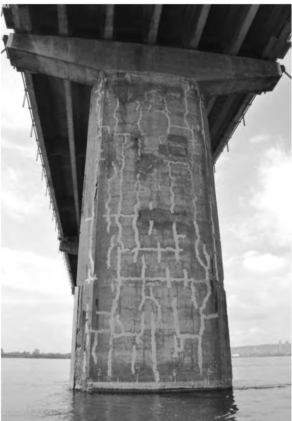
S5.PC.2.7.a – 5044 - Pile 8W (face est)
