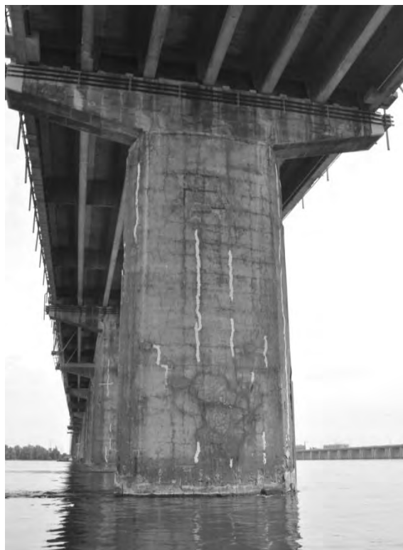
S5.PC.2.1.b – 4989 - Pile 14W (face ouest)
