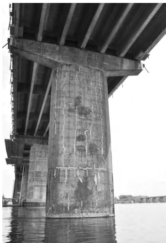
S5.PC.2.7.b – 5035 - Pile 8W (face ouest)
