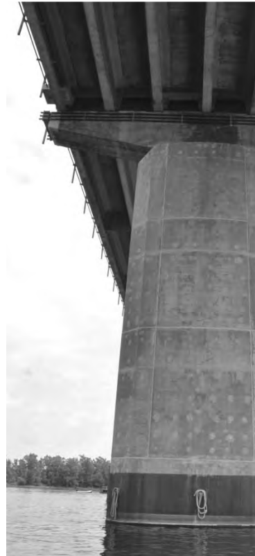
S5.PC.2.10.b – 5056 - Pile 5W (face ouest)
