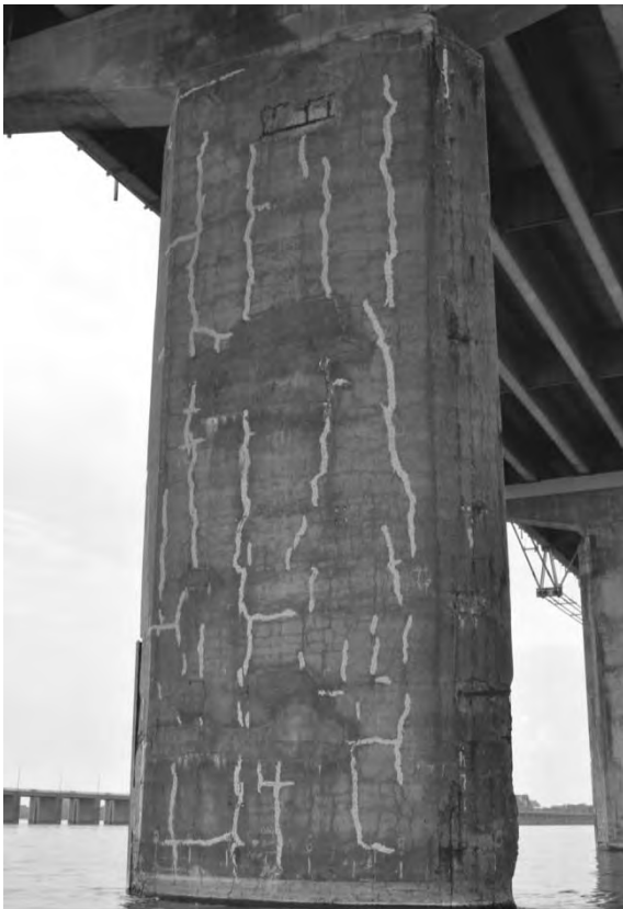
S5.PC.2.4.a – 5018 - Pile 11W (face est)
