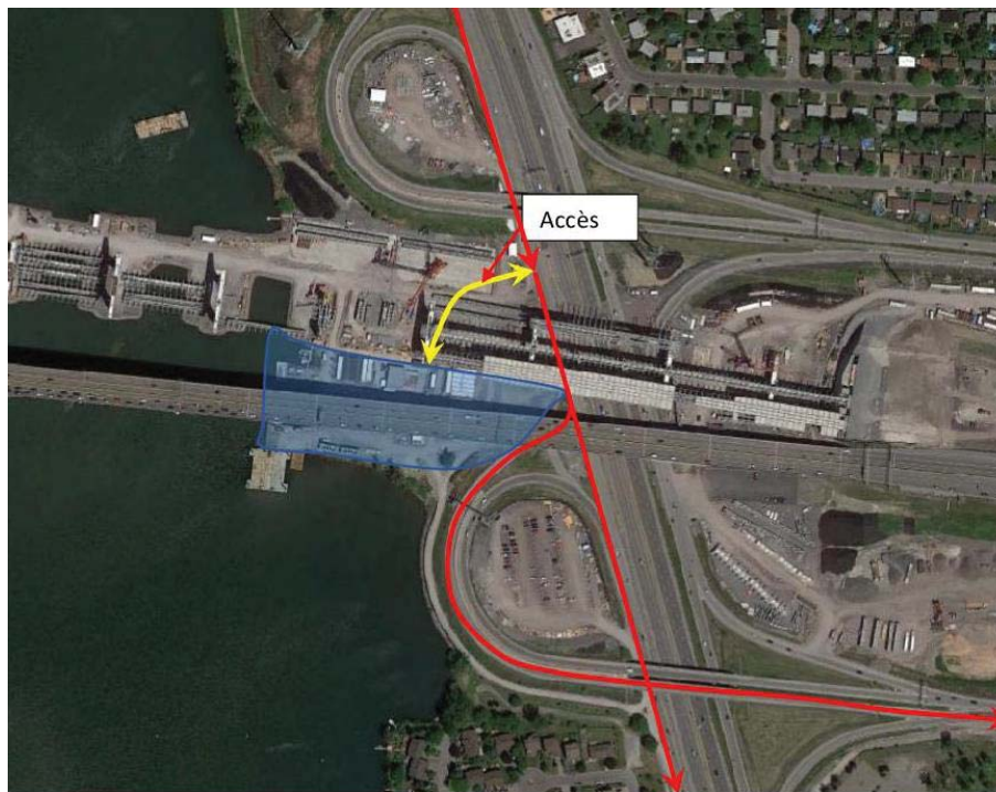
Figure 58 – Zone de travaux au nord de la route 132
