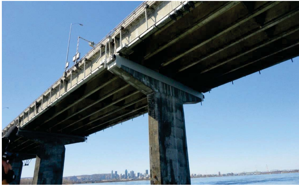
Figure A11 Travée en béton typique dans les sections 5 & 7
