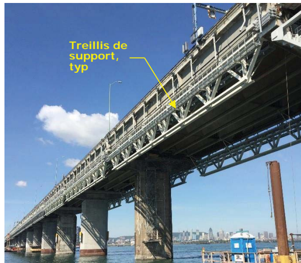
Figure 6 Treillis de support installés sous les poutres de rive en béton
