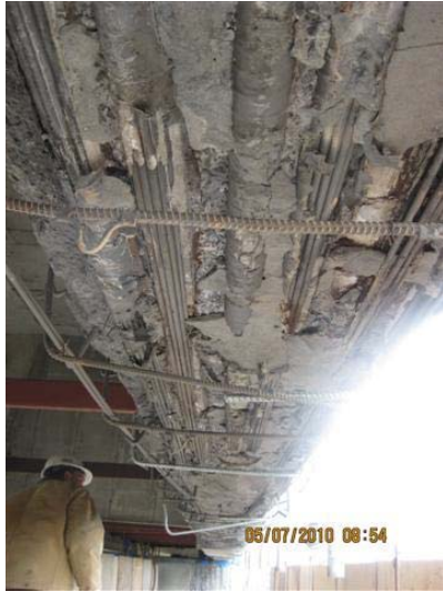
(a) Travée 8E-9E, câbles Freyssinet
