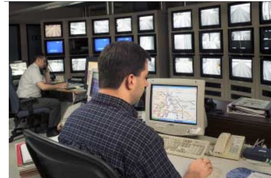
Salle de contrôle des caméras de surveillance vidéo et des feux de voies des ponts Jacques-Cartier et Champlain.
