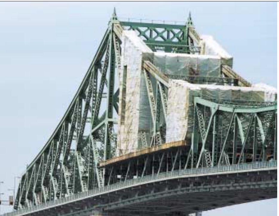
Travaux de peinture sur le pont Jacques-Cartier.
