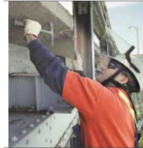
Inspection du béton au pont international de la Voie maritime.
