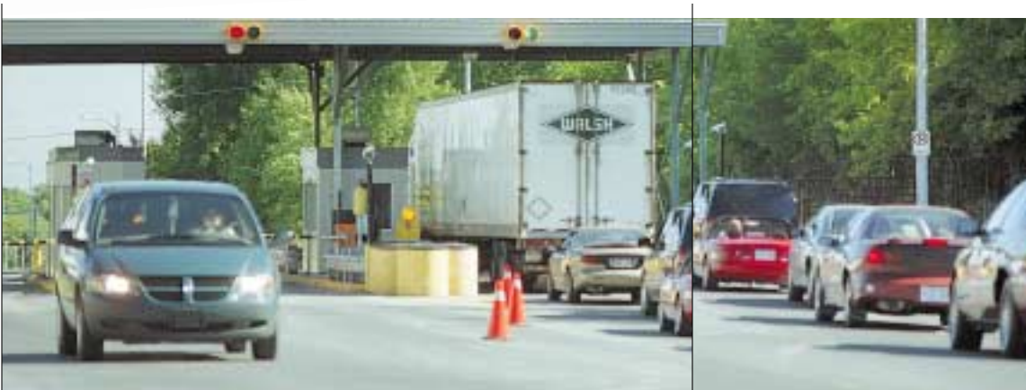
Poste de péage au pont international de la Voie maritime à Cornwall.
