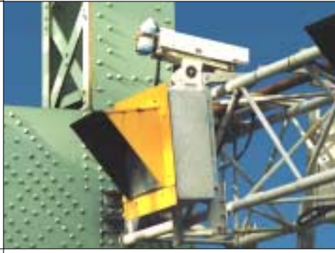
Caméras de surveillance vidéo et feux de voies au pont Jacques-Cartier.
