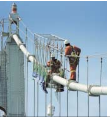
Peinture des câbles du pont international de la Voie maritime.
