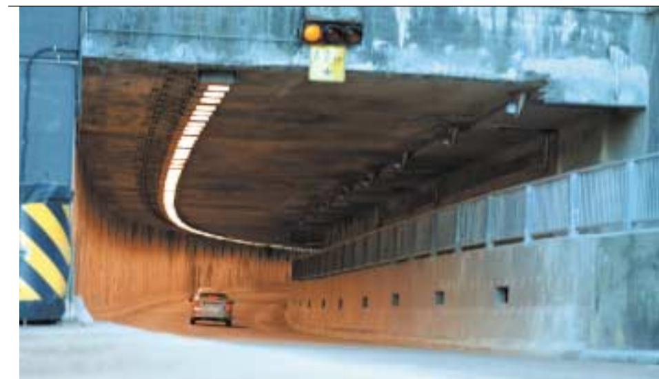
Tunnel de Melocheville.
