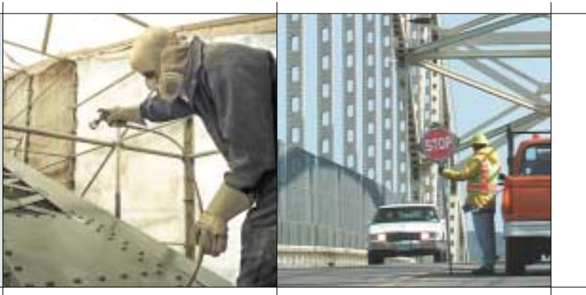
À gauche : peinture de la superstructure du pont Jacques-Cartier. À droite : travaux d'entretien au pont international de Sault Ste. Marie.
