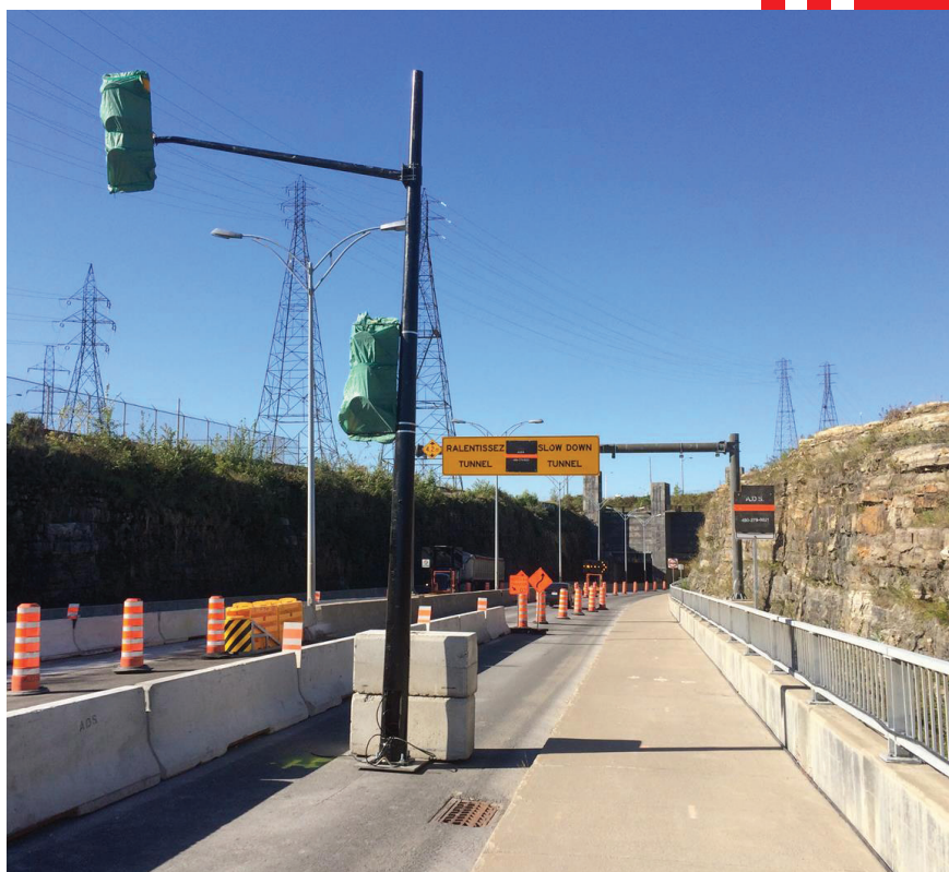
Tunnel de Melocheville
