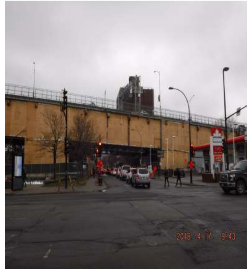
Encoffrements acoustiques boulevard De Maisonneuve
