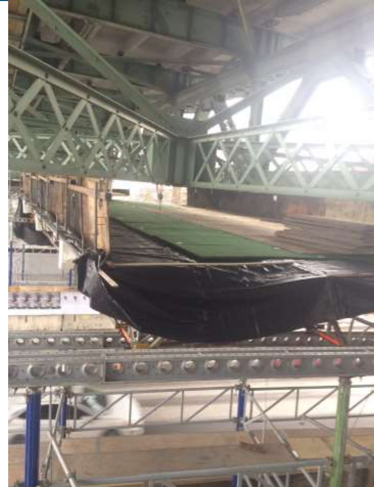
Work platform above De Maisonneuve Boulevard
