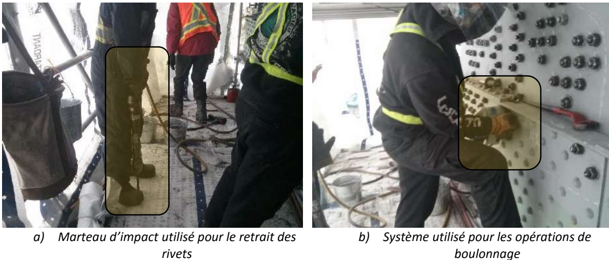
Figure 9: Outils utilisés lors de la mesure des niveaux sonores en proximité des travaux
