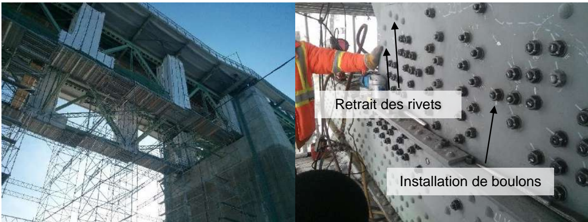
a) Vue de dessous des travaux d'entretien sous le tablier du pont b) Opérations de retrait des rivets et d'installation des boulons Figure 2: Travaux sous le tablier du pont et opérations d'entretien lors de la visite
